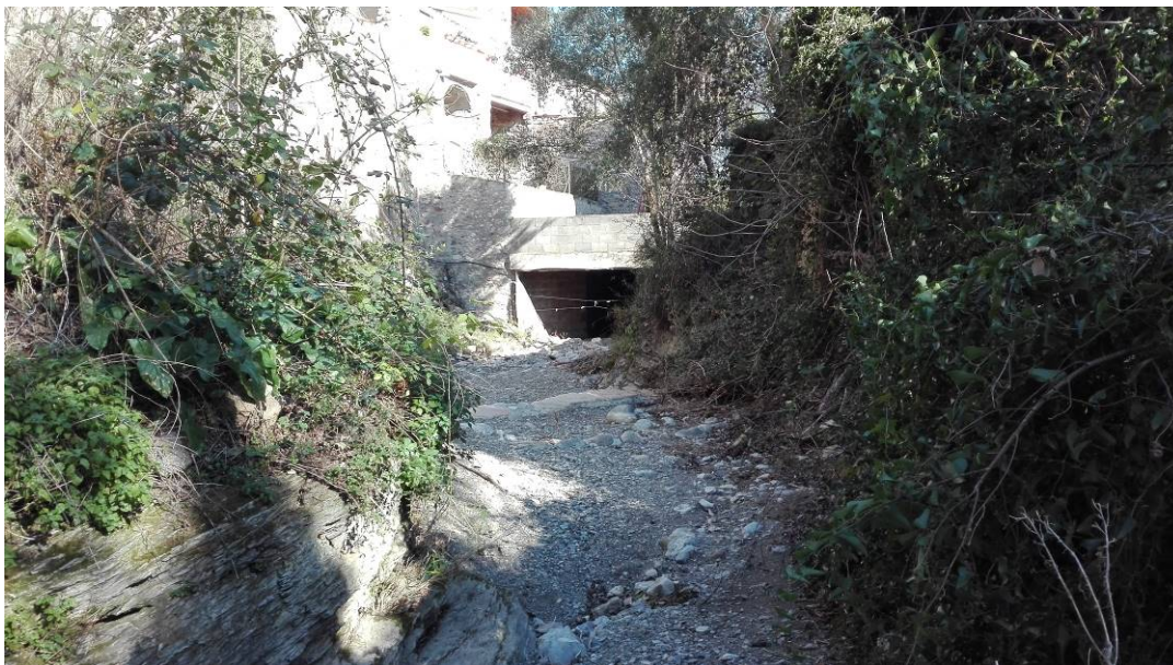
Imatge 19. Vista aigües avall obra de pas i desembocadura a la Muga
