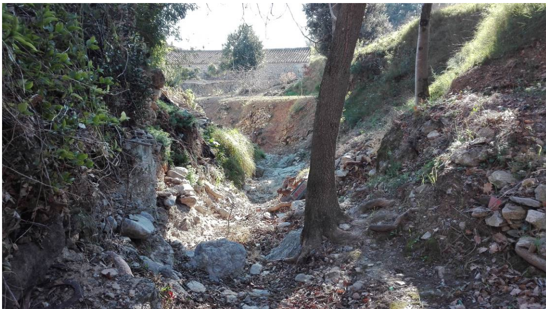
Imatge 22. Vista de l'inici del tram 2
