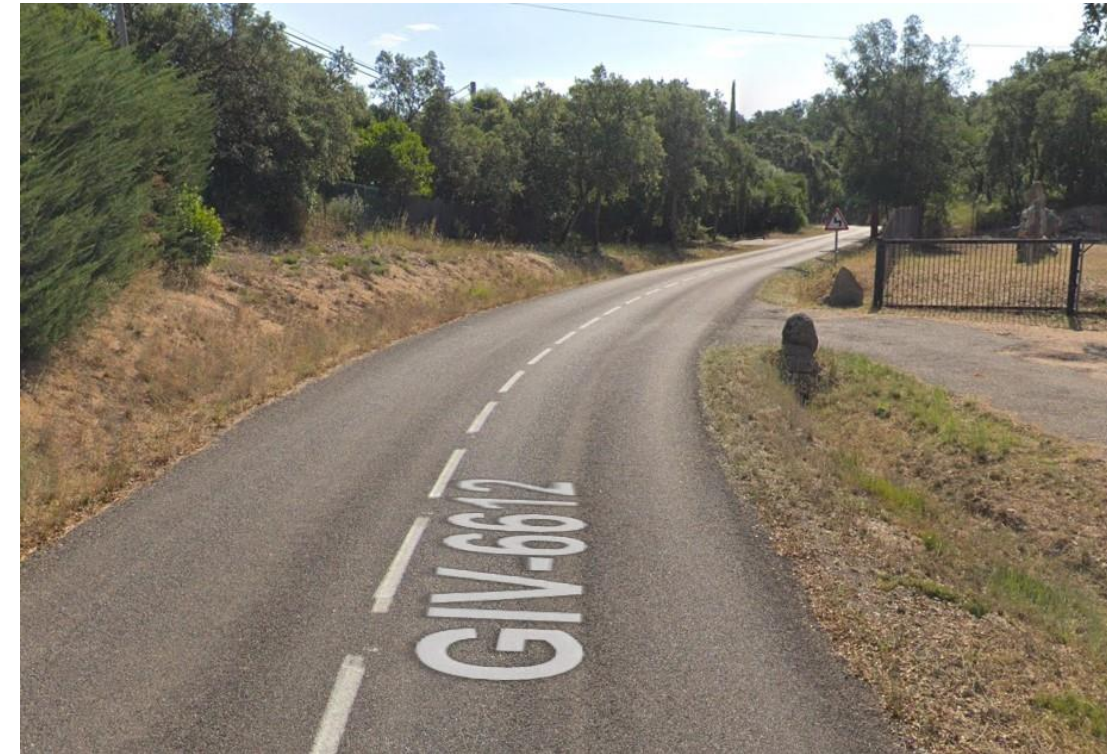
Figura 14 Creuament de carretera GIV-6612 des de pericó 17181PE3009 fins a pericó 17181PE3010
