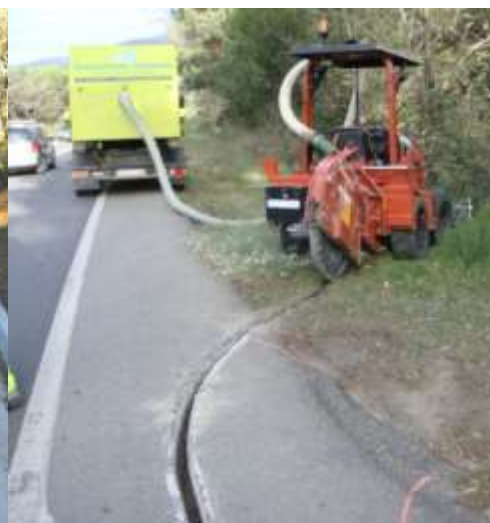
Gir de sortida de la calçada per col·locació d'un pericó
