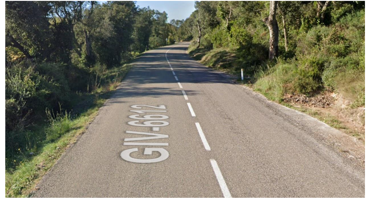
Figura 26 Creuament de carretera GIV-6612 des de pericó 17034PE3013 fins a pericó 17034PE3014
