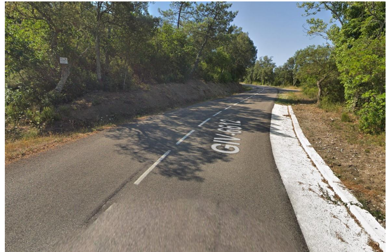
Figura 7 Creuament de carretera GIV-6612 des de pericó 17181PE3022 fins a pericó 17181PE3023
