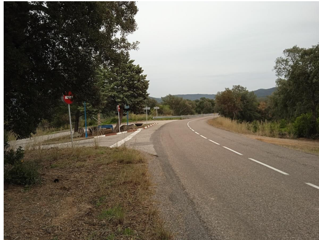
Figura 16 Creuament de carretera GIV-6612 des de pericó 17181PE3006 fins a pericó 17181PE3007
