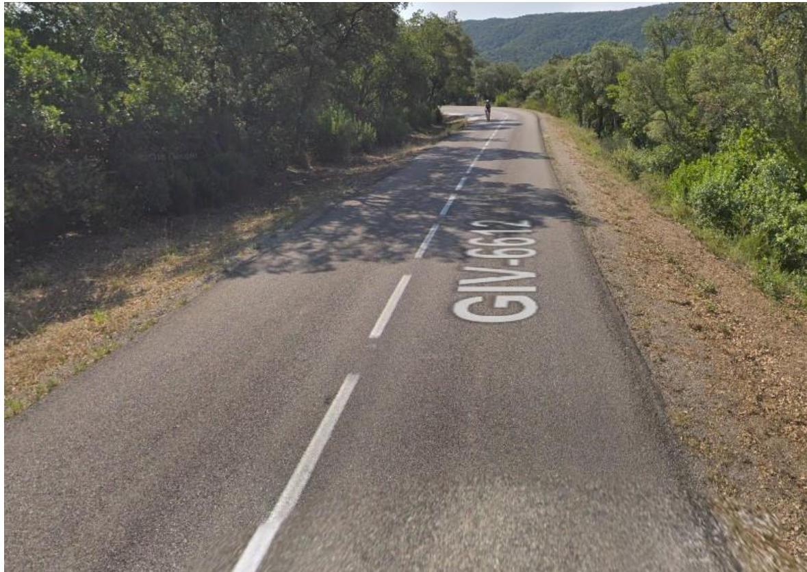
Figura 12 Creuament de carretera GIV-6612 des de pericó 17181PE3013 fins a pericó 17181PE3014
