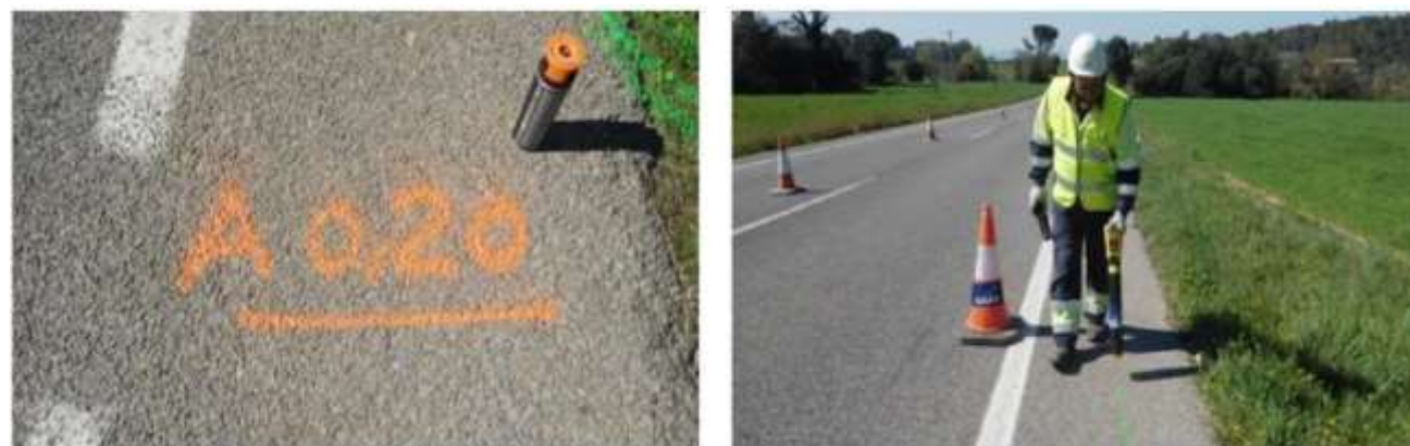
Localització de serveis amb georadar
