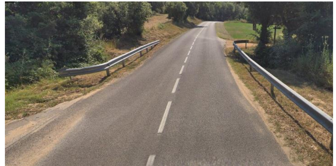
Figura 23 Creuament de carretera GIV-6612 des de pericó 17034PE3018 fins a pericó 17034PE3019
