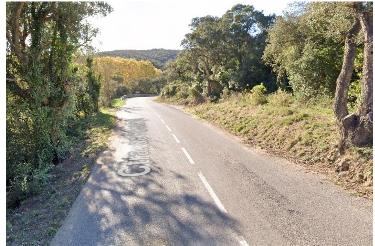
Figura 27 Creuament de carretera GIV-6612 des de pericó 17034PE3011 fins a pericó 17034PE3012
