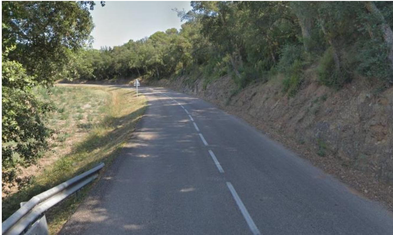
Figura 24 Creuament de carretera GIV-6612 des de pericó 17034PE3016 fins a pericó 17034PE3017
