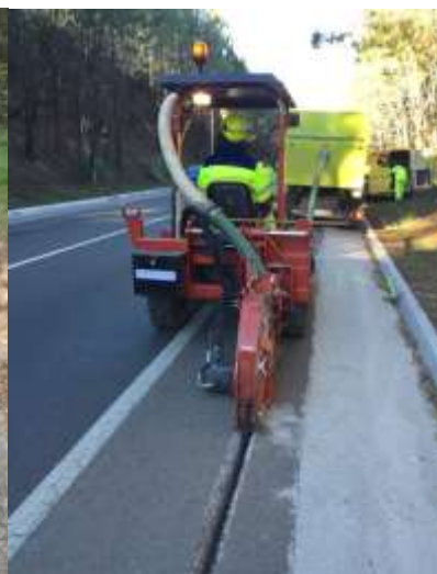
Exemple de treballs d'obertura de la microrasa
