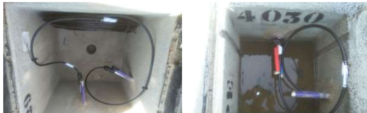
Exemples terminació microductes en pericó
