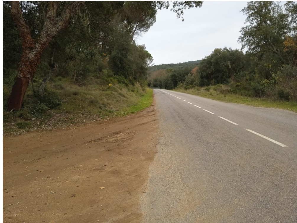
Figura 20 Creuament de carretera GIV-6612 des de pericó 17034PE3023 fins a pericó 17034PE3024 i inici PHD
