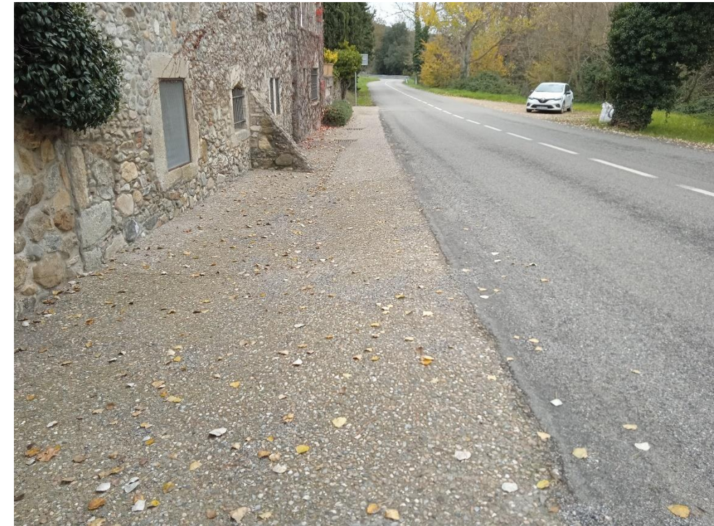
Figura 22 Creuament de carretera GIV-6612 des de pericó 17034PE3020 fins a pericó 17034PE3021
