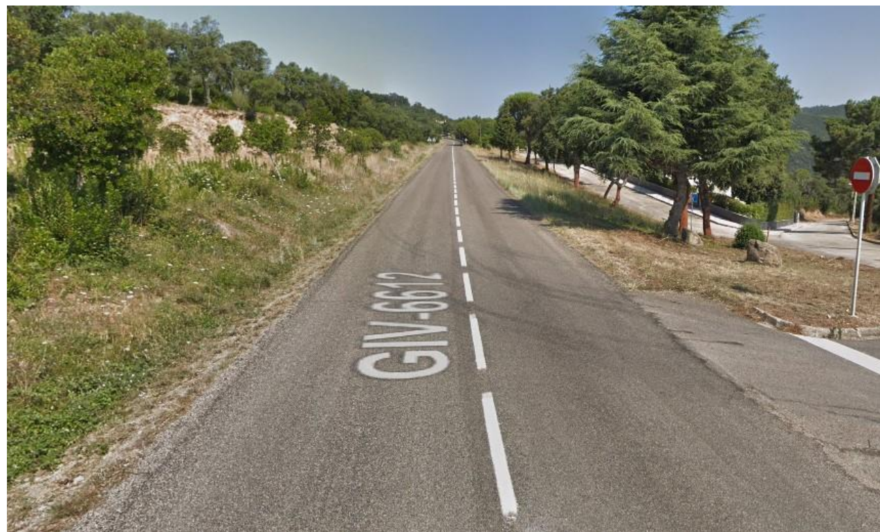
Figura 17 Creuament de carretera GIV-6612 des de pericó 17181PE3004 fins a pericó 17181PE3005
