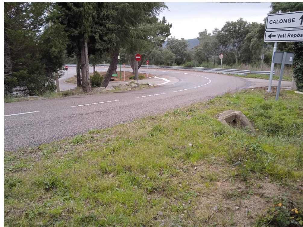
Figura 13 Creuament de carretera GIV-6612 des de pericó 17181PE3011 fins a pericó 17181PE3012
