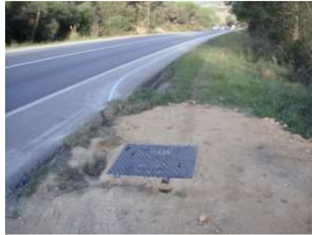
Exemple de l'estat de la canalització acabada
