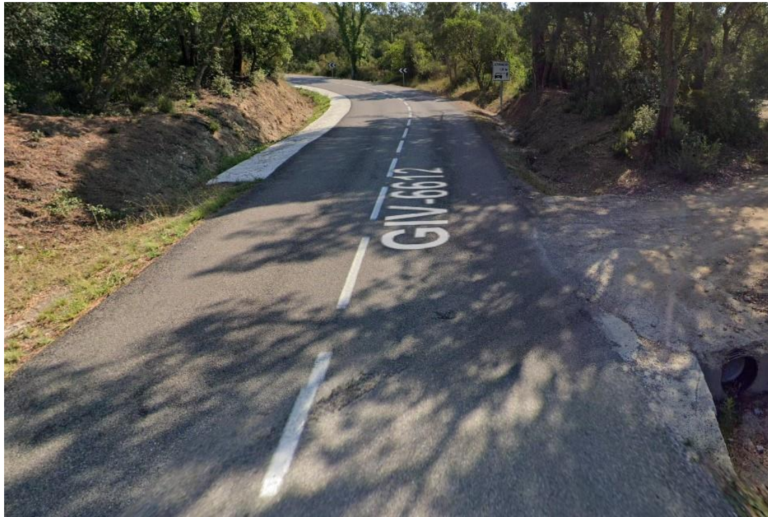
Figura 4 Creuament de carretera GIV-6612 des de pericó 17181PE3028 fins a pericó 17181PE3029
