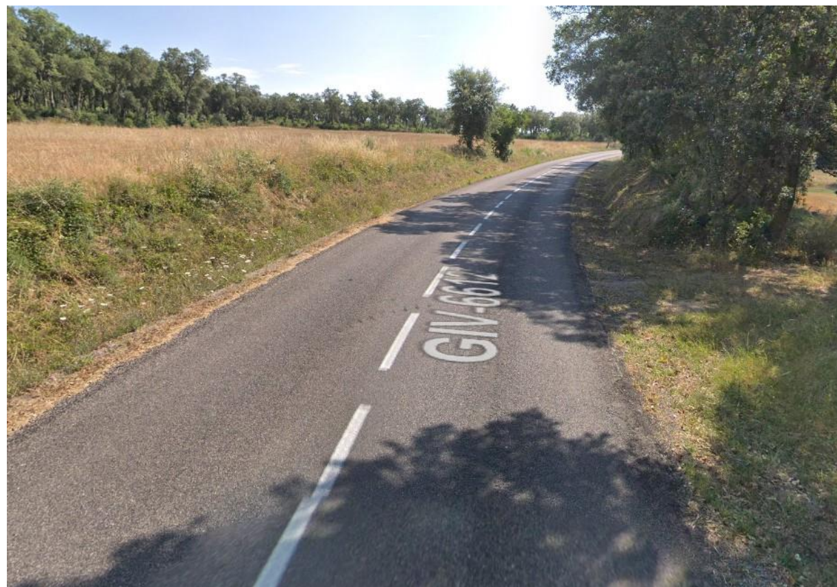
Figura 9 Creuament de carretera GIV-6612 des de pericó 17181PE3019 fins a pericó 17181PE3020
