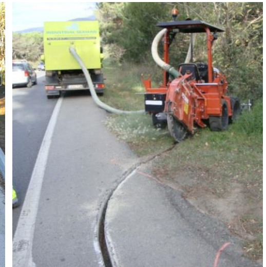
Gir de sortida de la calçada per col·locació d'un pericó
