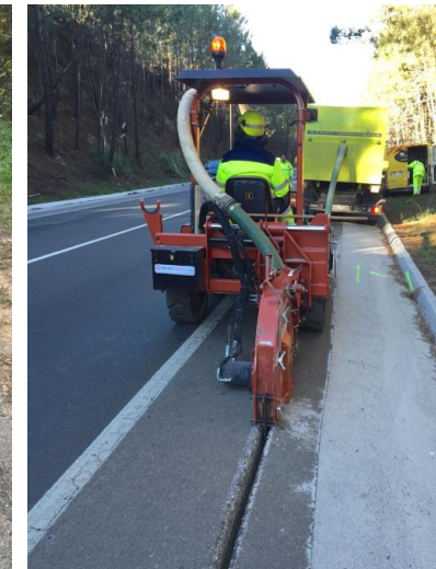
Exemple de treballs d'obertura de la microrasa
