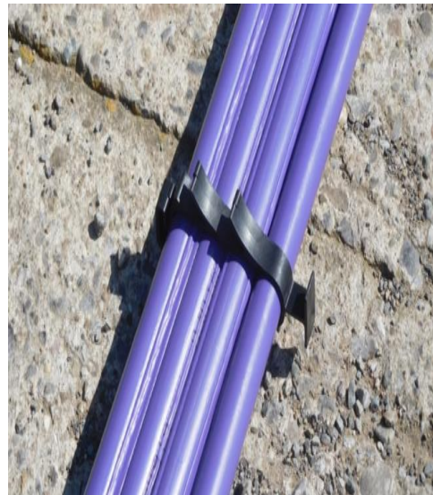
Centrador plàstic per homogeneïtzar la distribució del morter.
