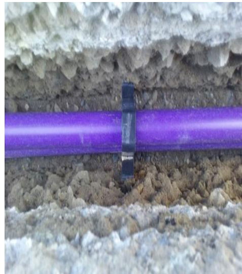
Centrador plàstic per homogeneïtzar la distribució del morter.
