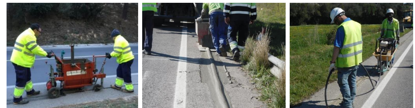
Exemple de treballs de rebliment de la rasa
