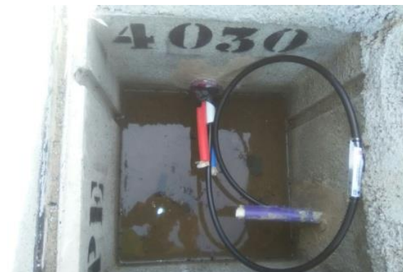
Exemples terminació microductes en pericó
