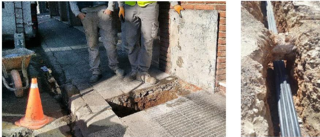
Exemple d'execució de cata amb detecció de serveis i minat de canonada
