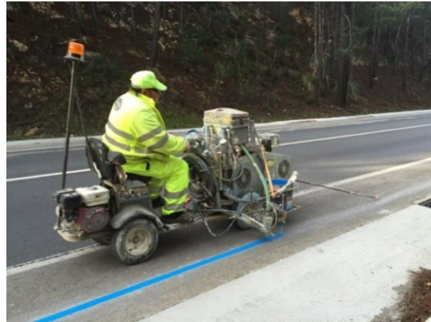
Exemple dels treballs de pintat de la línia blava
