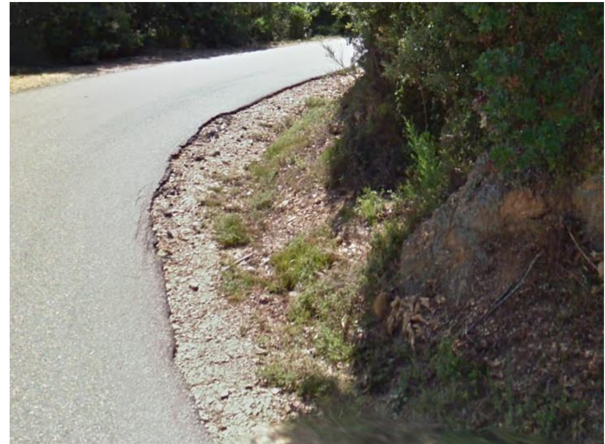
Figura 14 Ubicació pericó 17007PE3012 en la GI-7525
