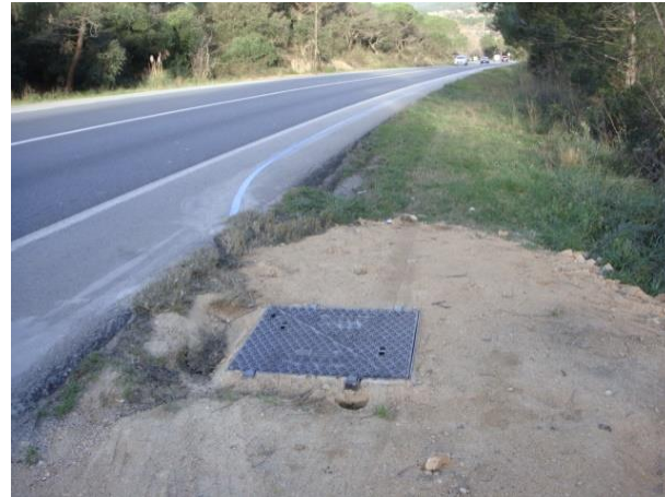
Exemple de l'estat de la canalització acabada
