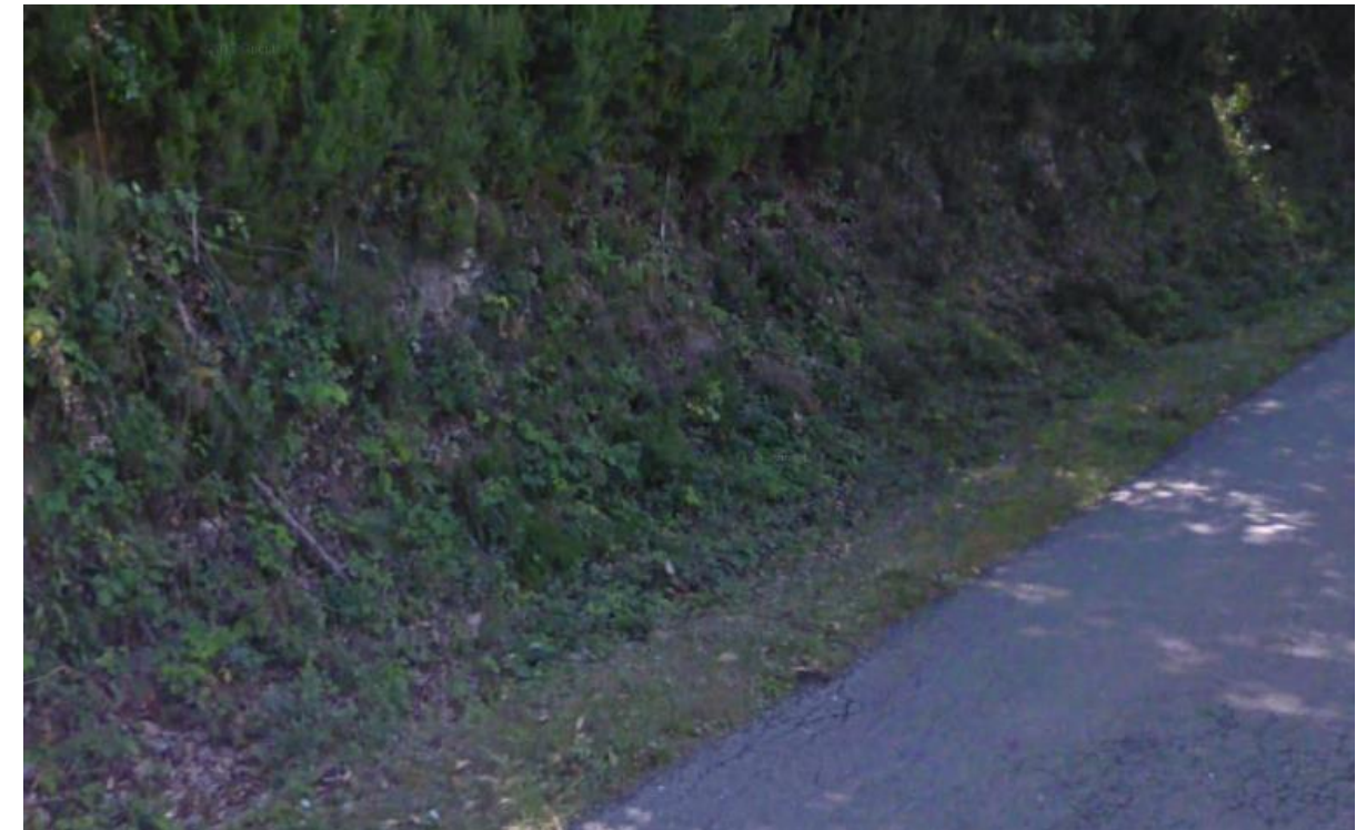
Figura 22 Ubicació pericó 17007PE3021 en la GI-7525
