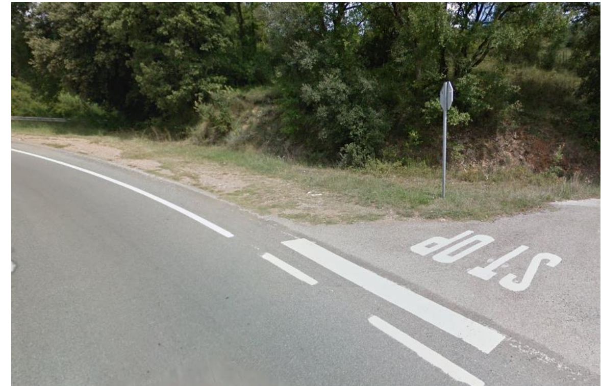
Figura 2 Ubicació pericó 17010PE3002 en la GI-523
