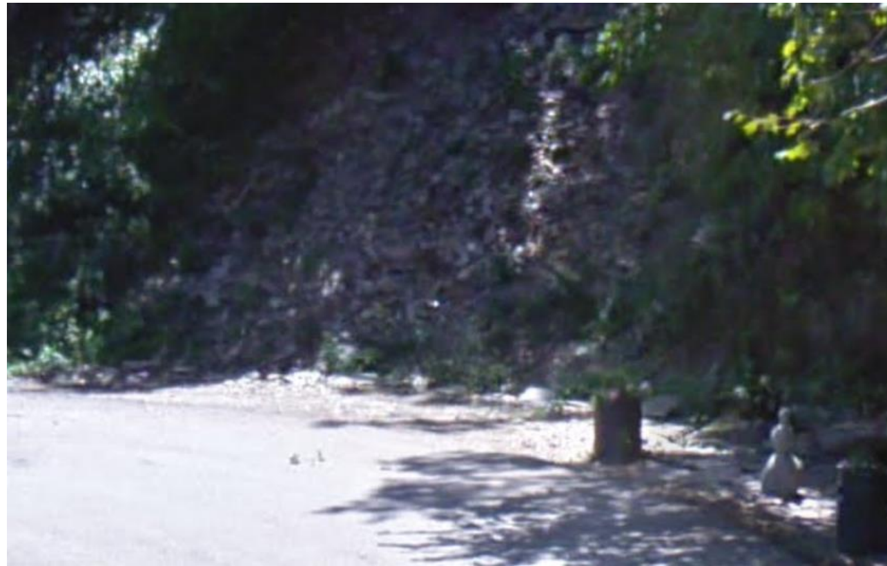
Figura 20 Ubicació pericó 17007PE3019 en la GI-7525
