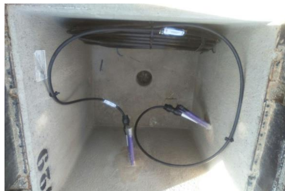
Exemples terminació microductes en pericó
