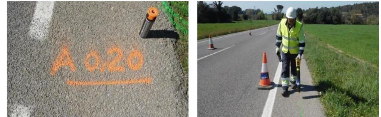
Localització de serveis amb georadar
