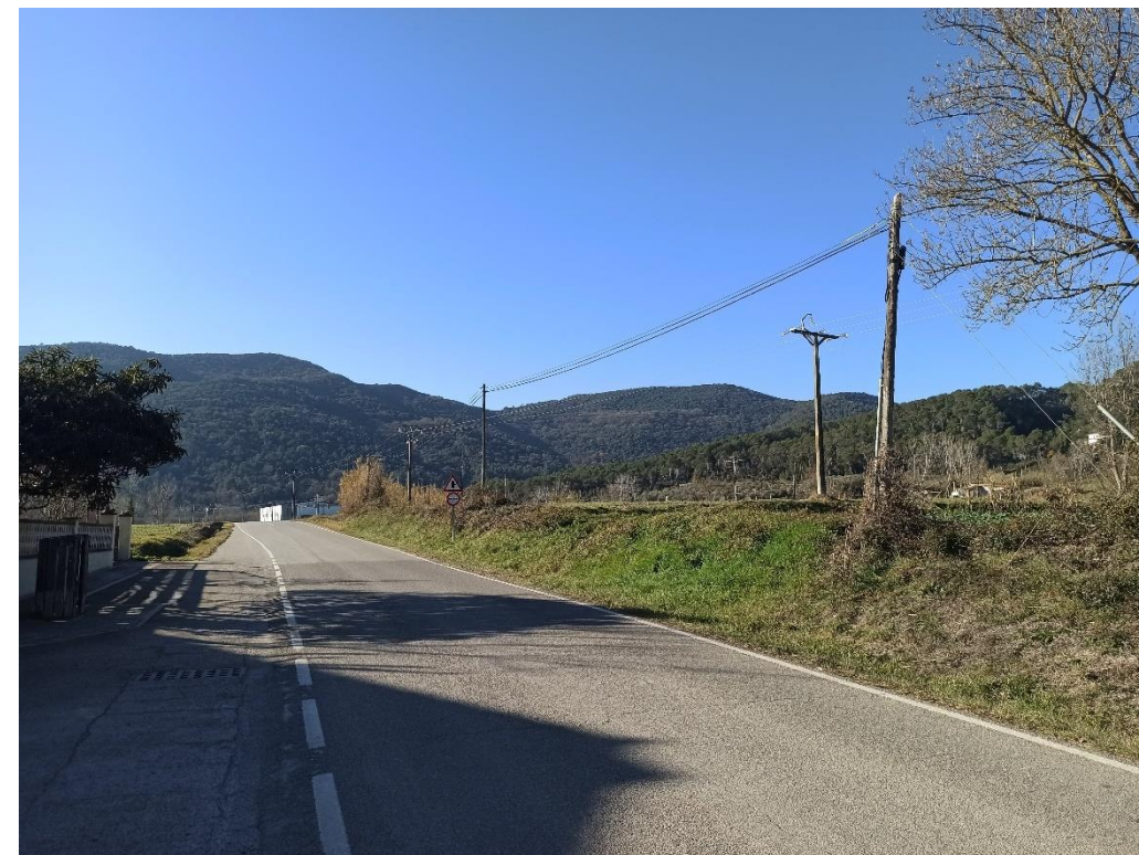
Fotografia núm. 15. Vista de la línia telefònica afectada per les obres de condicionament de la carretera.
