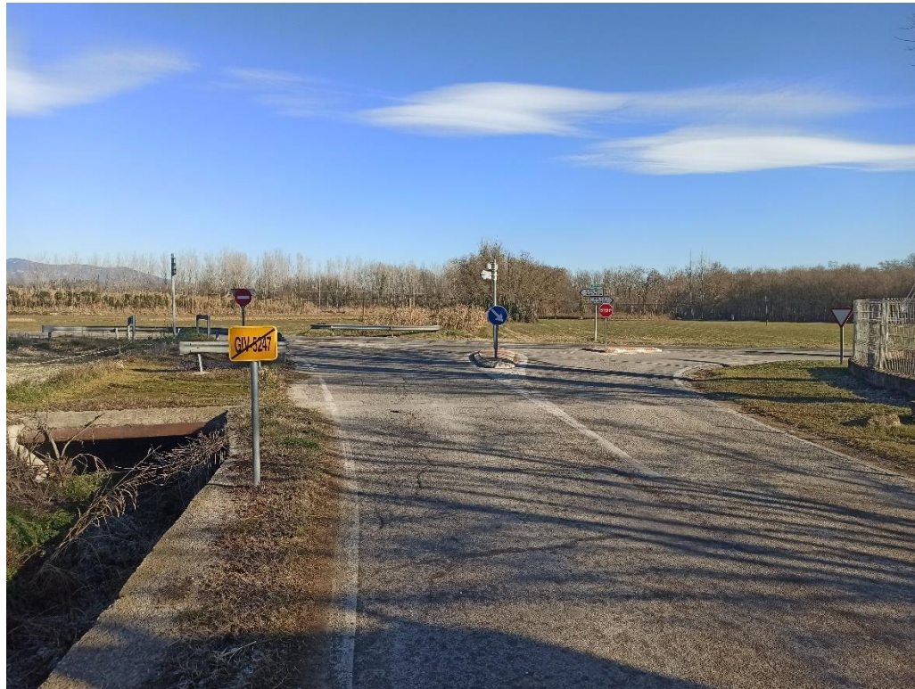
Fotografia núm. 1. Vista de l'inici del tram d'actuació en el punt d'encreuament amb la GI-524.
