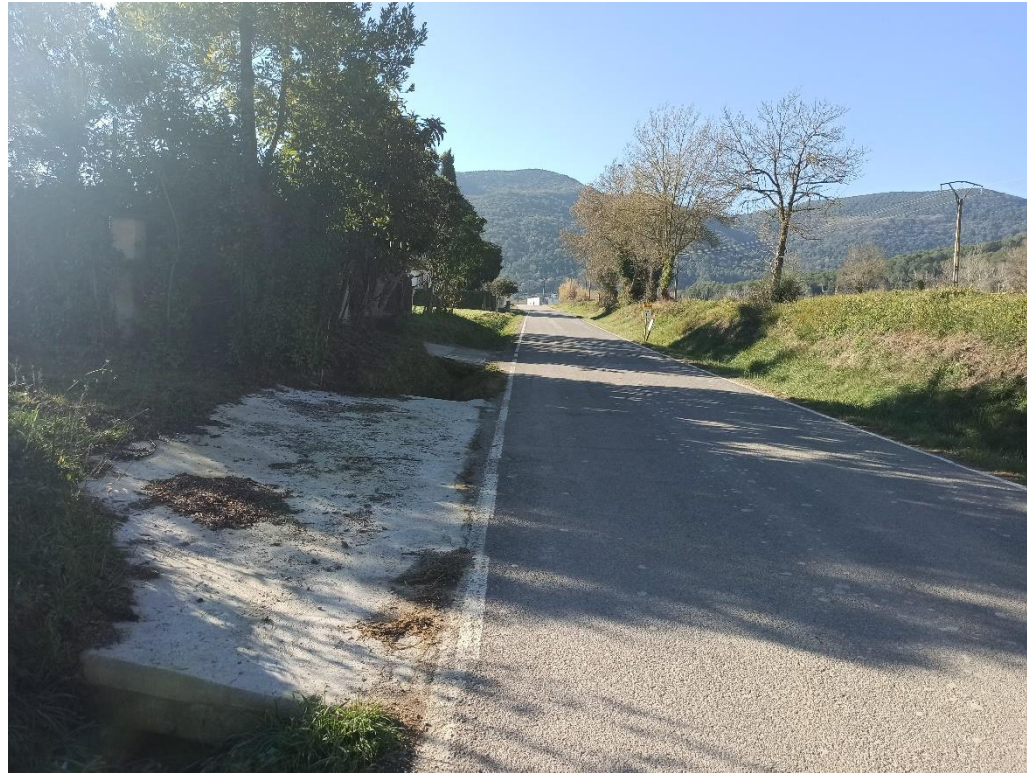
Fotografia núm. 12. Vista de l'accés a finca en el PK 0+960 direcció Pujarnol.
