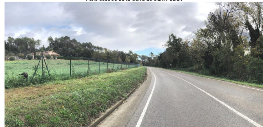
Tram central amb construccions modernes a l'entorn (PK 2+100)
