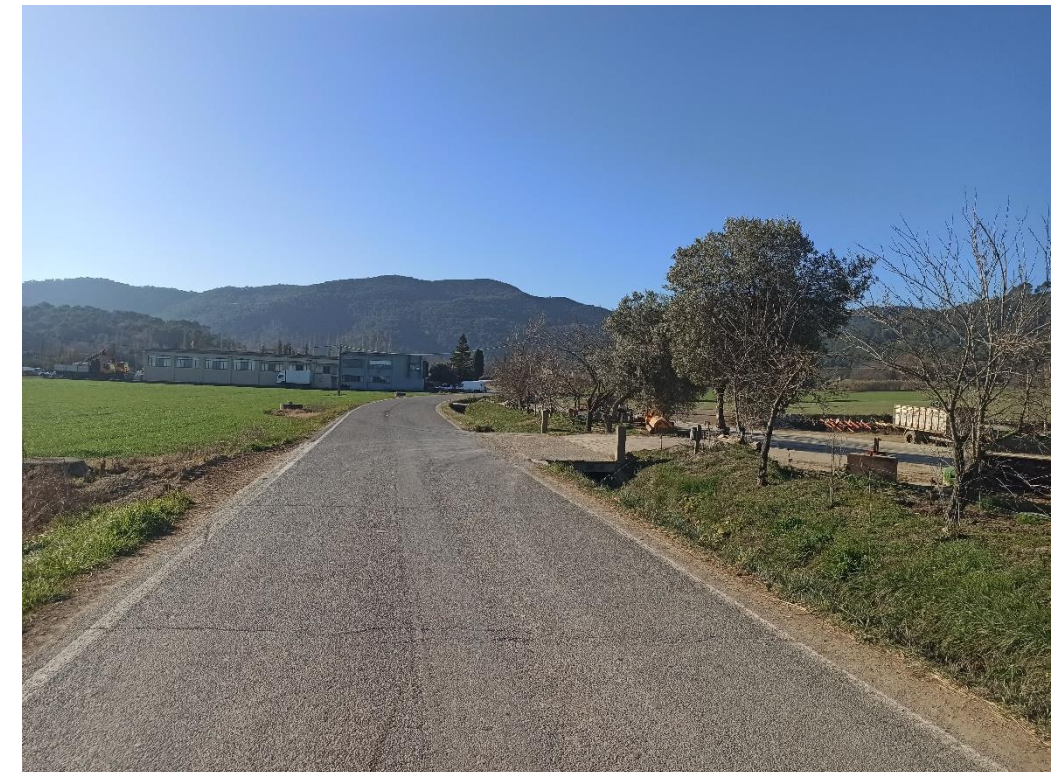
Fotografia núm. 3. Vista de l'accés a finca sobre el rec existent en el PK 0+280 direcció Pujarnol.
