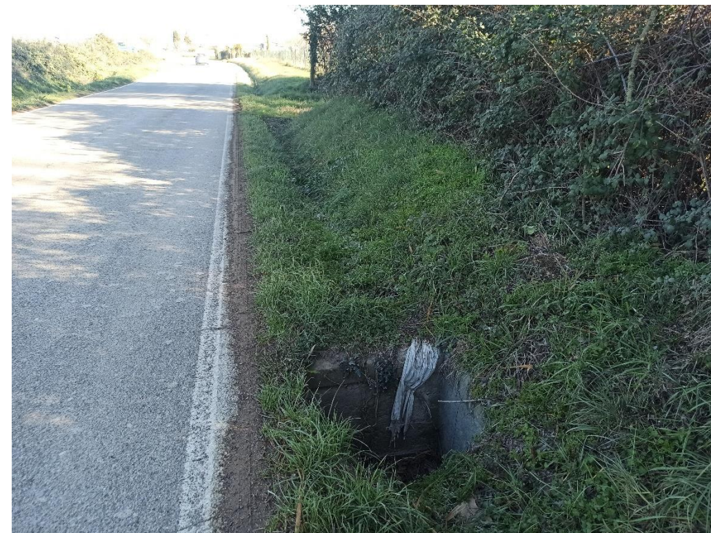
Fotografia núm. 7. Vista de l'obra de drenatge en el PK 0+790.
