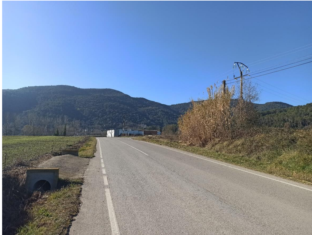
Fotografia núm. 16. Vista de l'últim tram d'actuació on s'uneix amb el tram ja condicionat.
