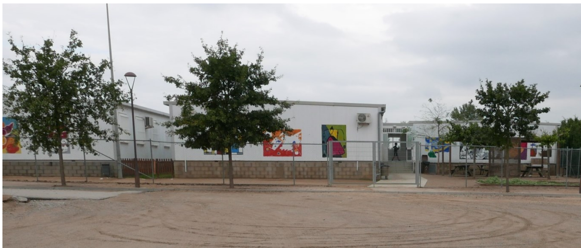
Fotografia 2. Detall dels mòduls que componen l'institut d'educació secundària de Verges, on s'identifica la sobreelevació per a evitar l'arribada d'aigua durant inundacions.
