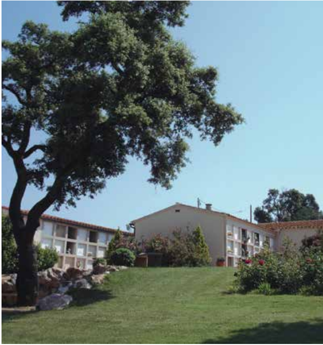
Arranjament i millora del cementiri. FOTO: LLUIS MASCLANS
