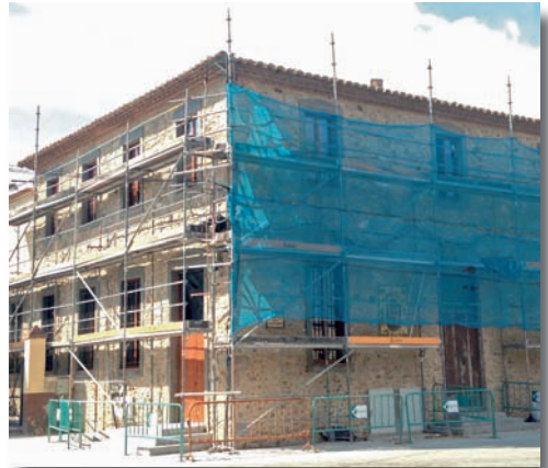
La façana amb les bastides posades.
