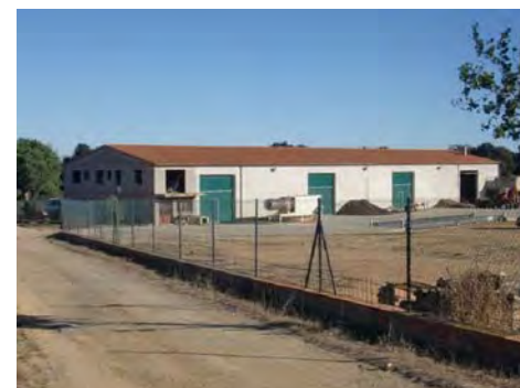
3. Façana sud i oest
