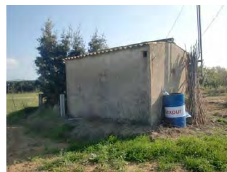
4. Façana nord i oest
