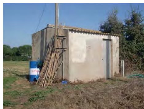
1. Façana sud i oest
