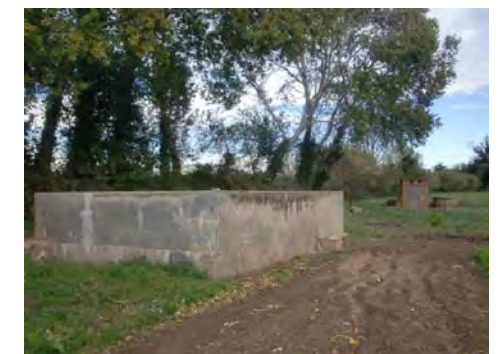
6. Bassa i pou amb edificació
