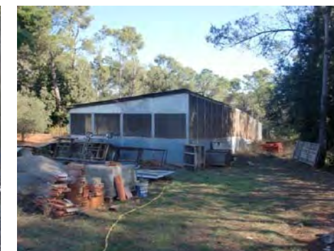
5. Cobert aïllat - Façana sud i oest
