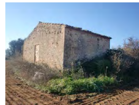
4. Façana nord i est
