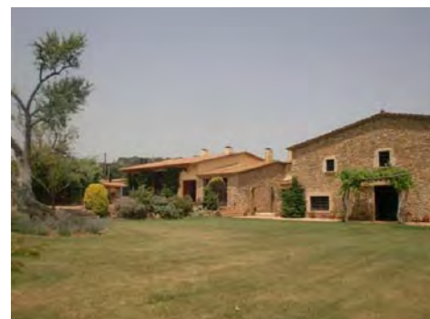
1. Façana principal i annexos adossats
