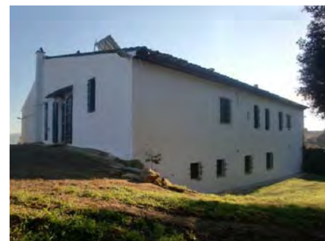
2. Façana nord i oest
