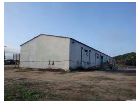
2. Façana nord i est
