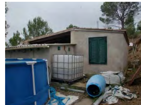
4. Façana nord i oest
