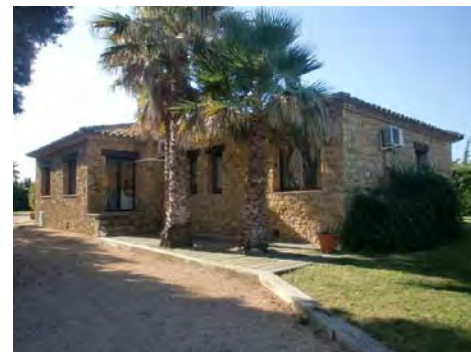
2. Façana nord i est
