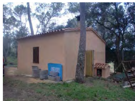
2. Façana nord i est
