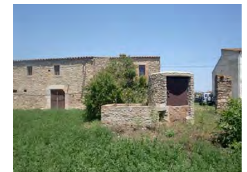
6. Pou i façana principal
