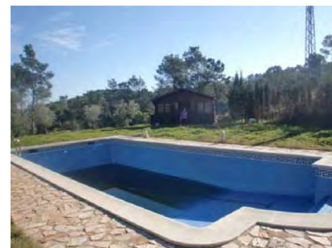
3. Caseta i piscina
