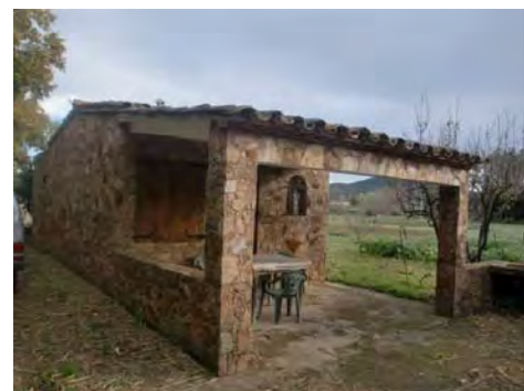
2. Façana sud i oest
