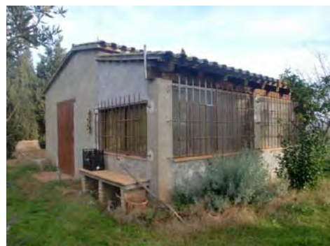
1. Façana sud i oest
