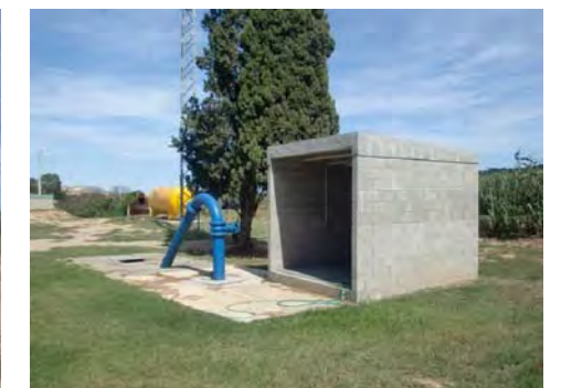
6. Cobert per impulsió
