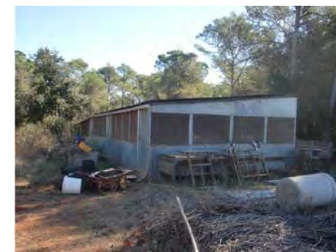
4. Cobert aïllat - Façana nord i oest
