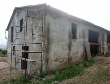
2. Façana nord i oest
