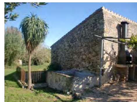
3. Façana oest - zona safareig
