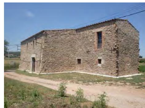
2. Façana principal i façana est
