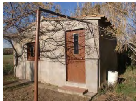
2. Façana principal i façana est
