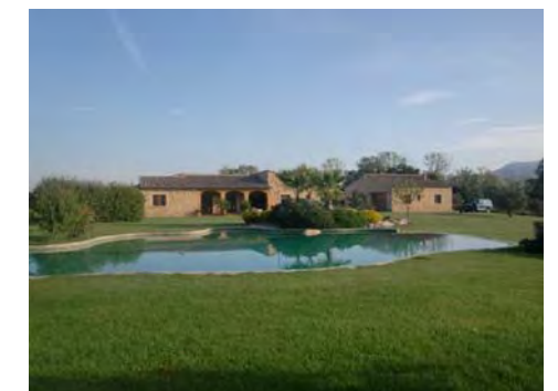
5. Façana sud i zona piscina
