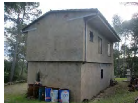
3. Façana nord - oest
