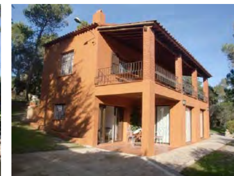
5. Façana sud - est
