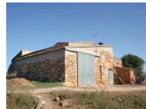
4. Façana sud i oest
