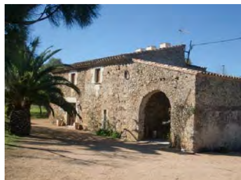
1. Façana est - principal
