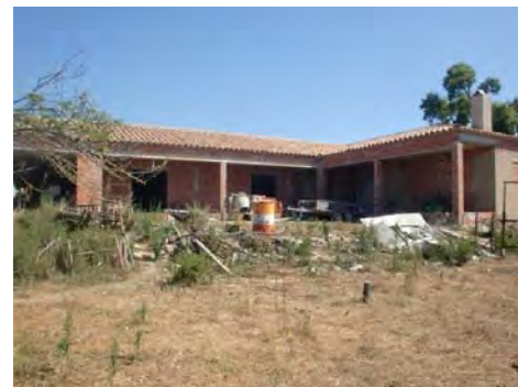
2. Façana principal i façana est
