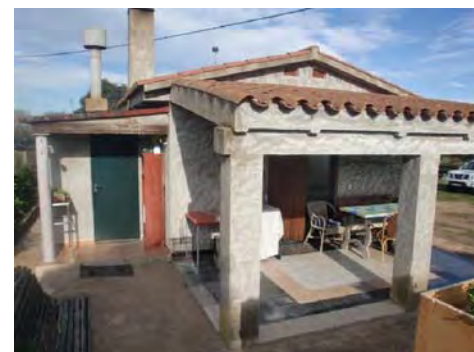
2. Porxo a la façana sud
