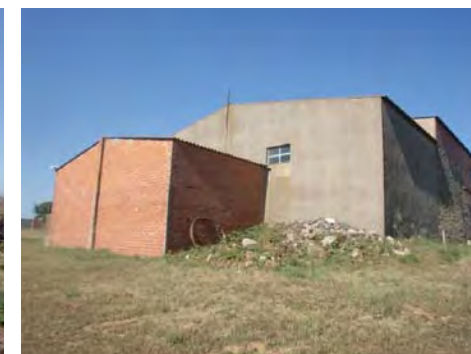
5. Façana nord i est
