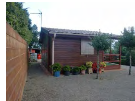
4. Façana sud i oest - casa de fusta
