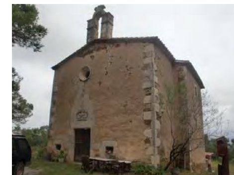
5. Ermita façana oest
