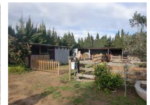
6. Coberts al nord de la finca
