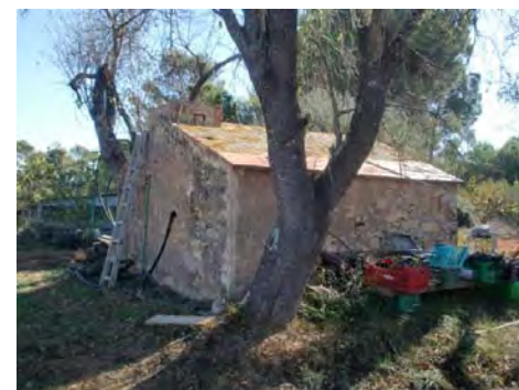
3. Façana oest i nord
