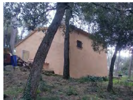
3. Façana nord i oest
