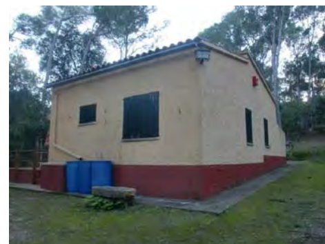
2. Façana principal i est
