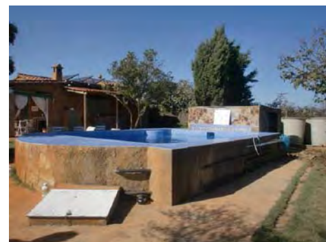
2. Façana est i piscina
