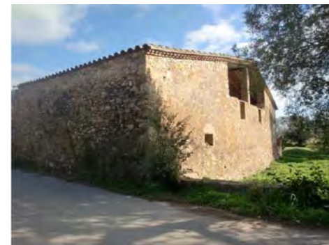
3. Façana sud i oest
