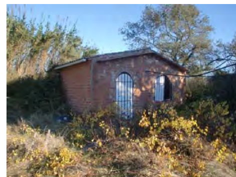
2. Façana sud i oest
