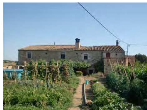
1. Façana sud - principal
