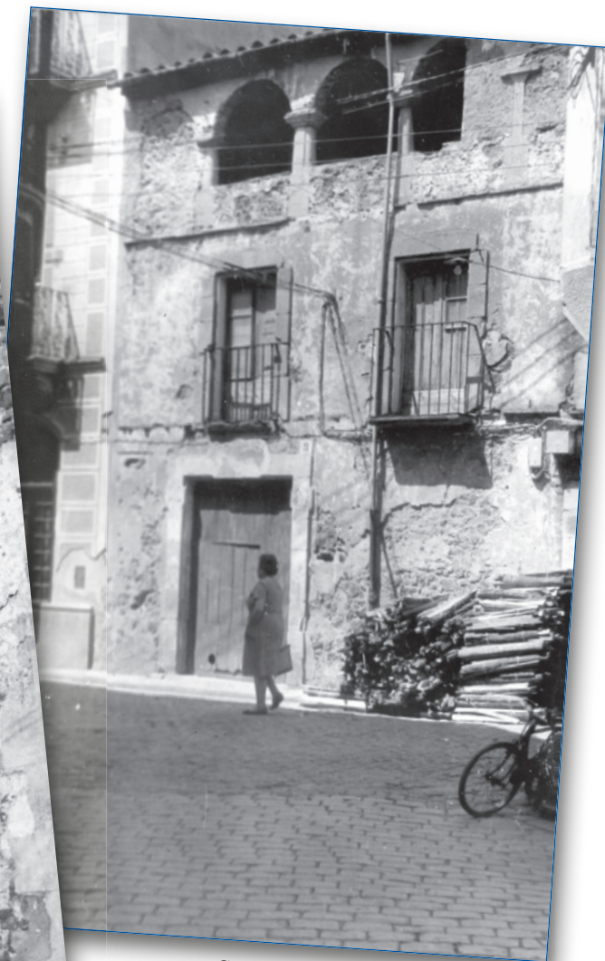
Cal Botiguer (Casa aterrada al costat del pont i de can Casas)
