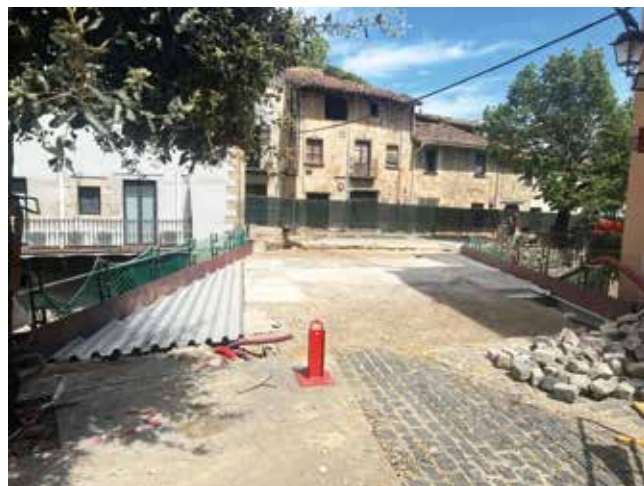
Obres del Pont del carrer del Centre
