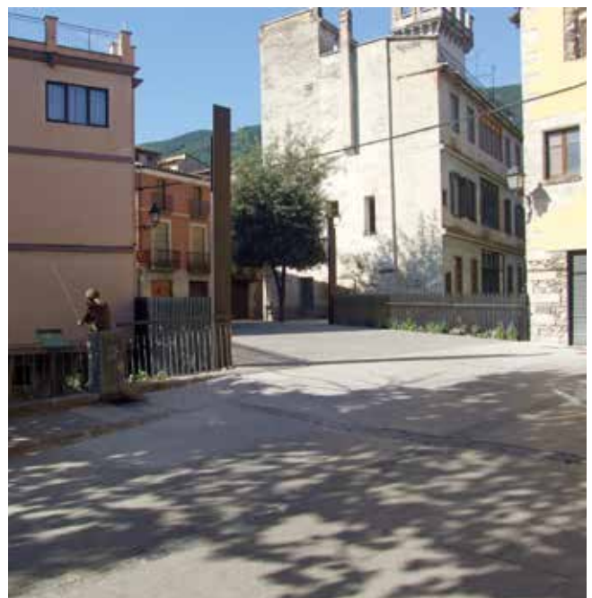
Imatge del pont remodelat del carrer del Centre
