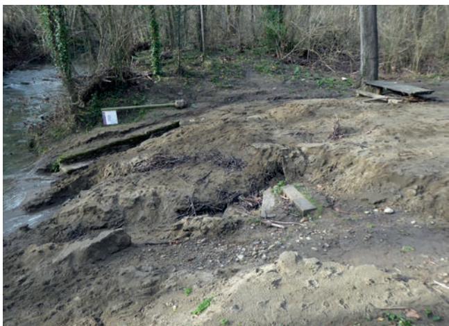
Desperfectes a la Font de la Teula
