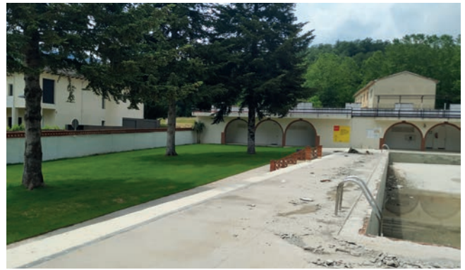
Obres de condicionament a la piscina municipal
