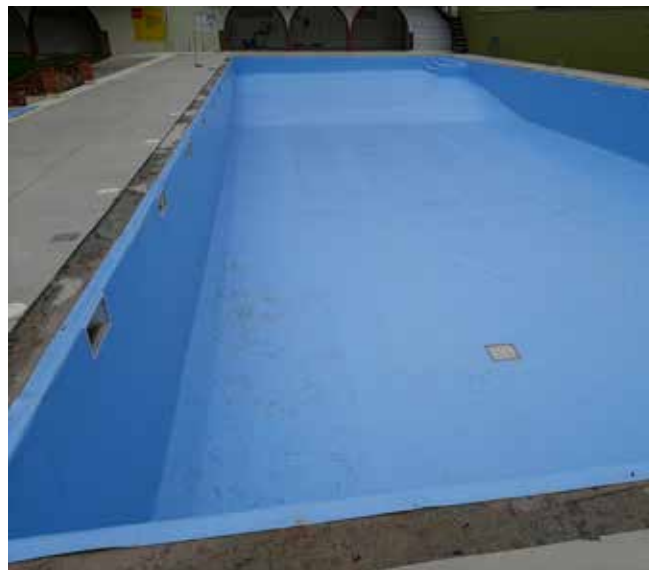
Nova làmina antilliscant al vas de la piscina municipal
