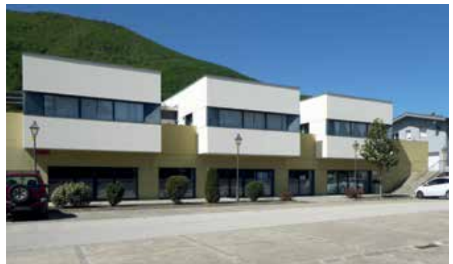
Edifici de l'Escola Bressol i la Biblioteca
