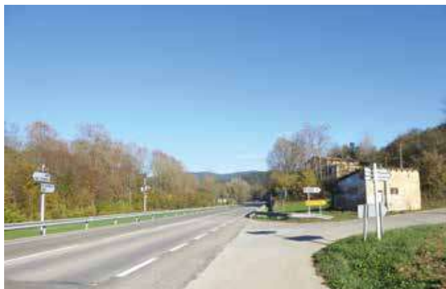
Punt PK 61.600 de la carretera C63
