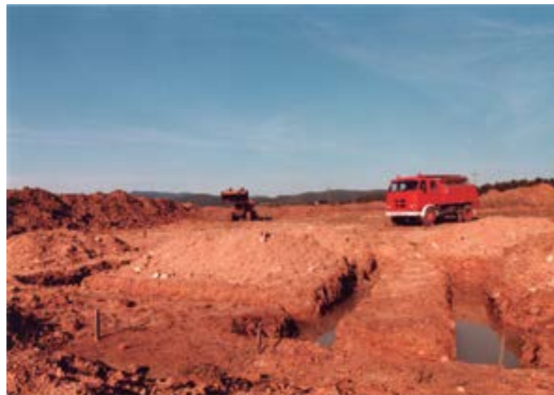
Fonaments del futur edifici del Parc de Bombers, finals dels anys 80.
