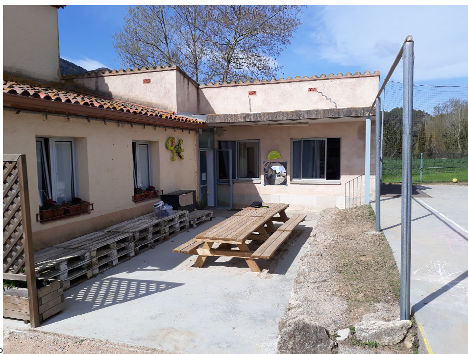
Vista façana sud –est, zona implantació PORXO/AULAVERDA
