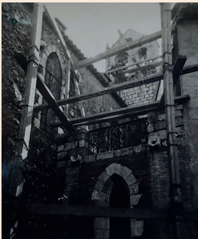
Bastida preparada per a enlairar les campanes, 1944 (BAPP. Sec. H R. 1.325. Fot. Modesto Domínguez)
