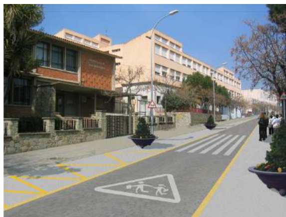
Carrer amb paviment únic i preferència per a vianants. Velocitat límit de 20 km/h.
