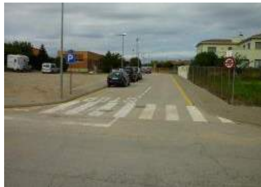
Imatge 70. Vista del carrer Toló. El CAP, al fons.
