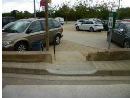
Imatge 95. Rampa actual cap a vorera. Estreta i en un itinerari de vianants poc evident per anar cap al centre a través de la plaça del Pont.
