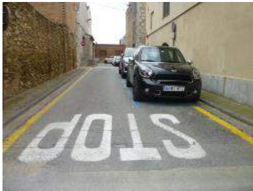
Imatge 26. Travessera Requesens. Voreres impracticables que conviuen amb aparcament.
