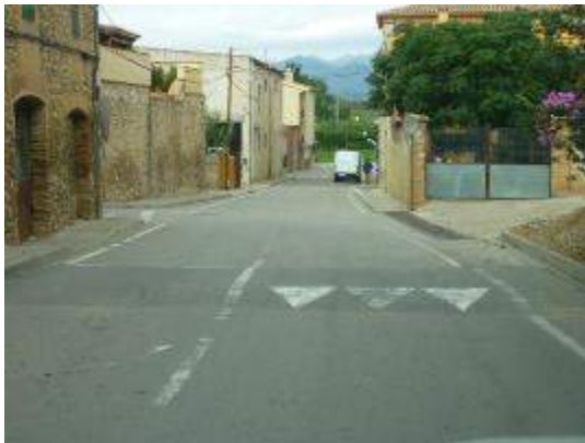
Imatge 5. Carretera de Mollet. Cal repàs de pintura per trencar visual ample excessiu de via.
