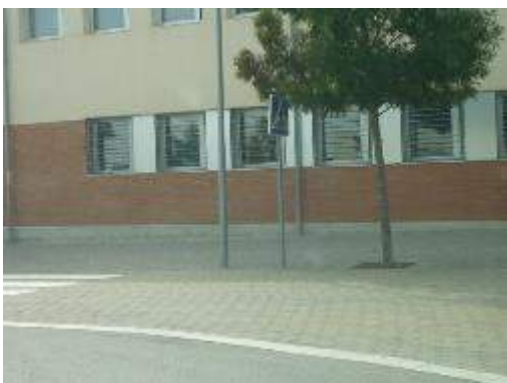
Imatge 112. El senyal queda desplaçat del carril de circulació i el conductor no el veu.
