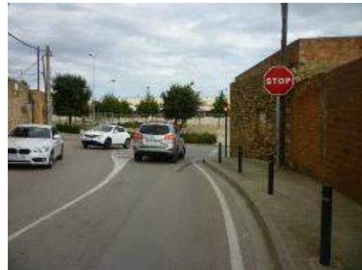
Imatge 29. Carrer de Garriguella. La col·locació de les pilones respecte de la vorada redueix encara més l'ample disponible de vorera.
