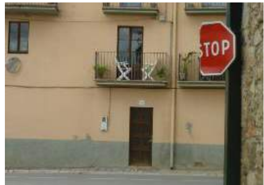
Imatge 12. Senyal deteriorat a la cruïlla del Camí Sota el Parc amb el carrer de Sant Sebastià.
