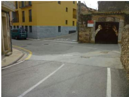
Imatge 30. Caldria pintar línia de cediu el pas al paviment tot sortint de Doctor Clos (a la dreta de la imatge) cap a la cruïlla.
