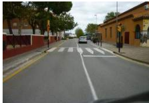
Imatge 61. Pas de vianants elevat, Camí de la Garriga.
