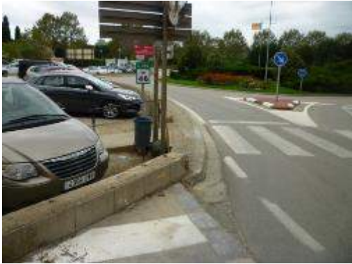
Imatge 94. Espai entre passos de vianants. Exposició al risc d'atropellament i manca d'accessibilitat.
