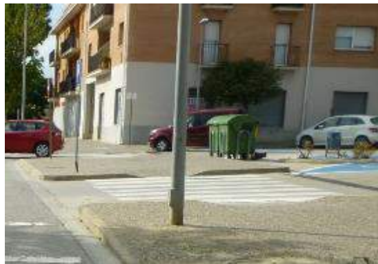
Imatge 24. Vorerer rebaixades als passos a l'av. de la Constitució.
