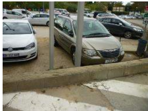
Imatge 93. Detall del voral i desnivell del pàrquing respecte del pas de vianants.
