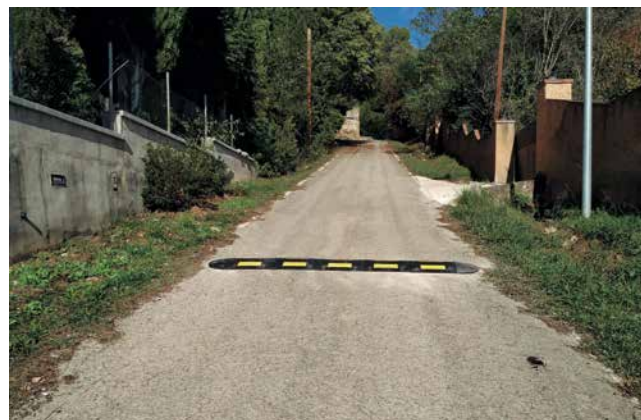
Instal·lació d'una banda reductora a la zona de can Comes.
