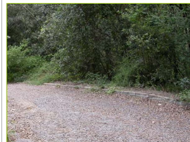
Obres precàries d'urbanització existents.
