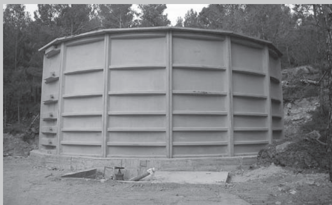
El nou dipòsit de l'aigua.
