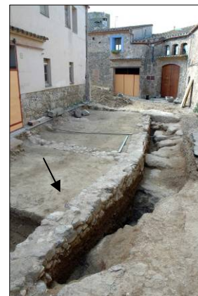
Vista del 1001 des del nord
