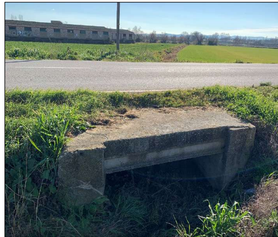
Imatge 8. Obra de drenatge 4.
