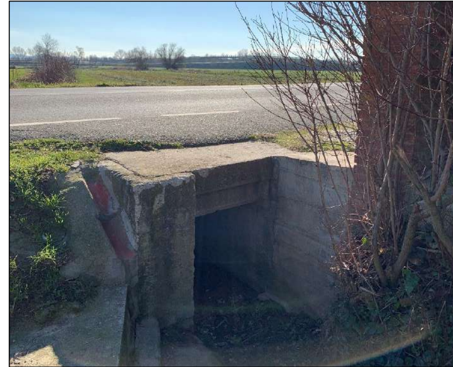
Imatge 7. Obra de drenatge 3.
