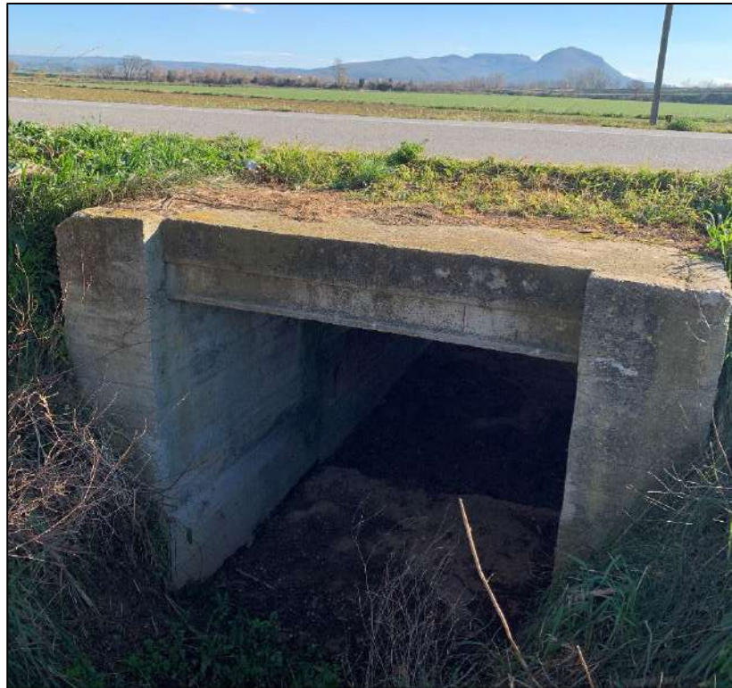
Imatge 5. Obra de drenatge 1.
