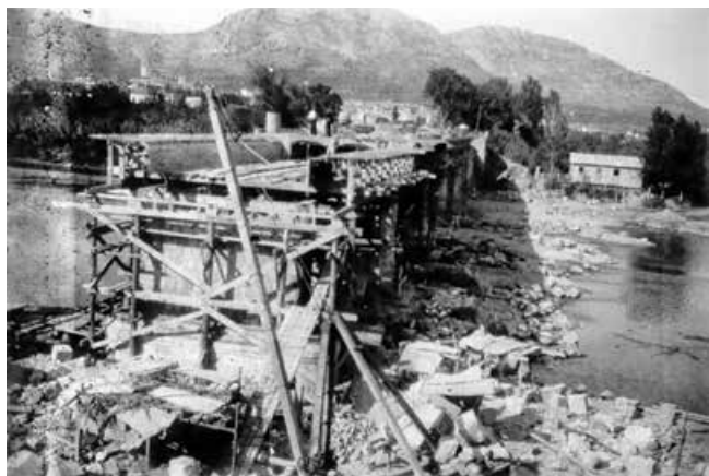
Construcció de l'actual pont de Torroella després que fos dinamitat per les tropes republicanes en retirada l'any 1939.
