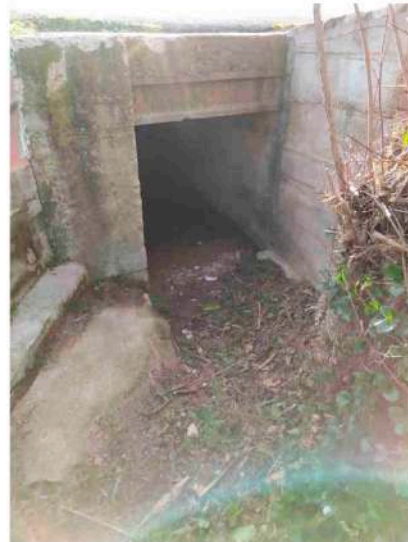
Obre de drenatge Nord de la casa.
