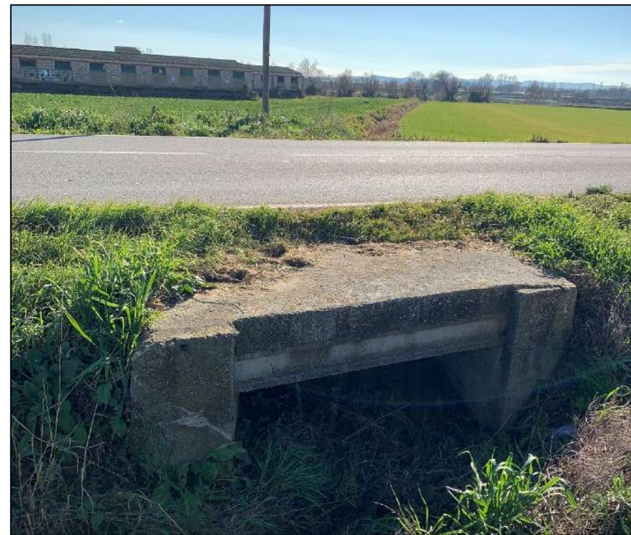
Imatge 8. Obra de drenatge 4.
