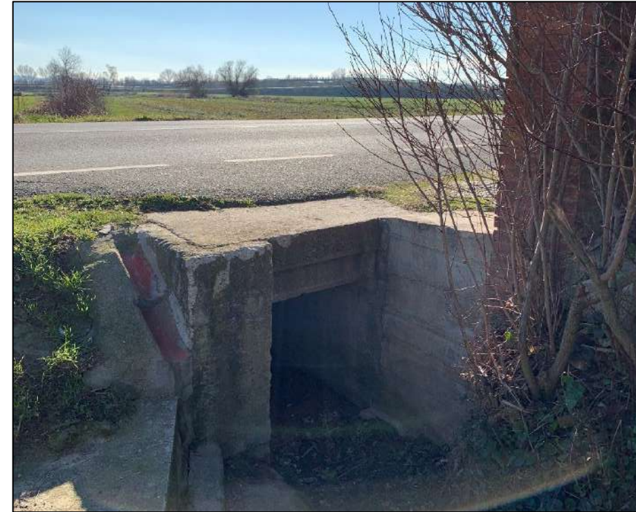
Imatge 7. Obra de drenatge 3.
