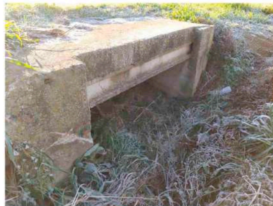
Obre de drenatge Sud de la casa.
