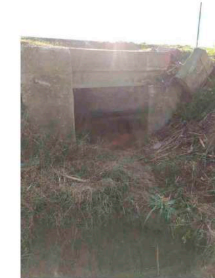
Obre de drenatge situada més al Sud.
