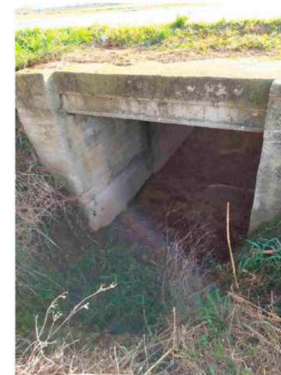
Obre de drenatge situada més al Nord.
