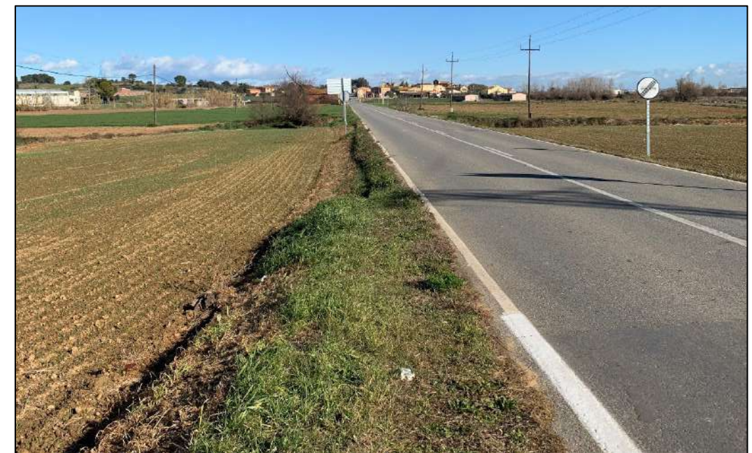
Imatge 4. Carretera C-31a. La traça discorre pel marge esquerra.
