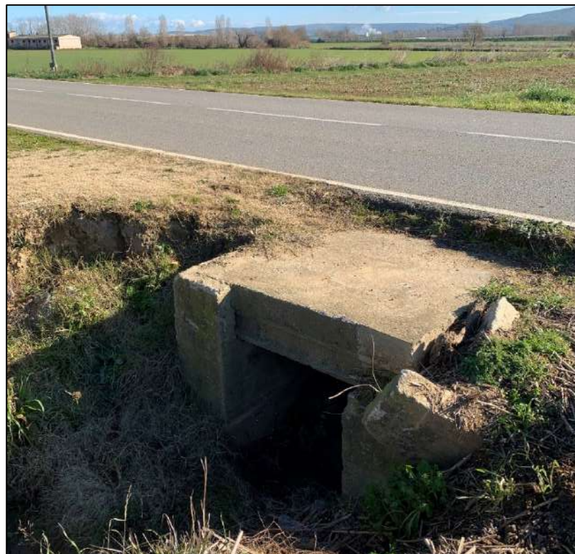
Imatge 6. Obra de drenatge 2.
