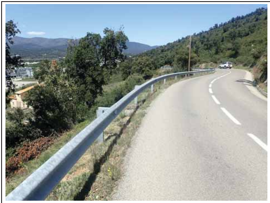
Foto 2. AP 1. Carretera GI-601.
