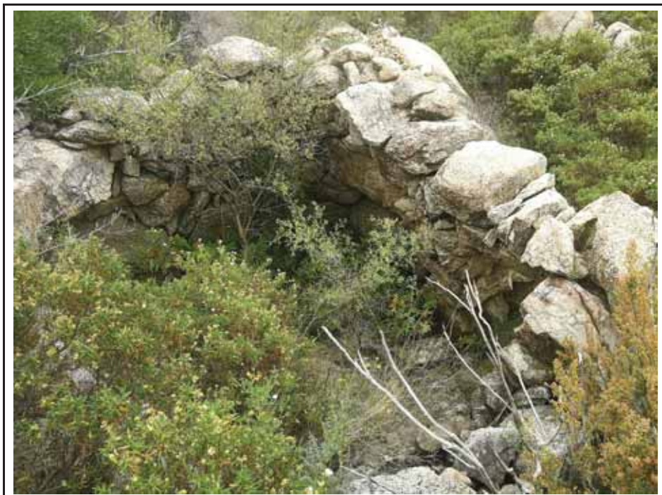
Foto 44. ED 4, construcció de pedra seca.
