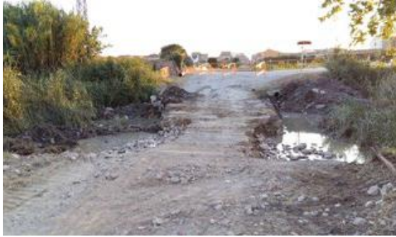
Inici de la reforma de la passera
