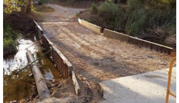
Durant les obres
