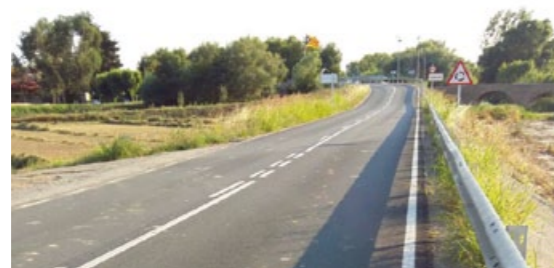
Obres efectuades en el vial d'entrada al poble des de la GI643
