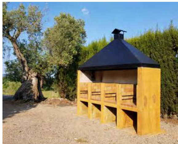
Construcció d'unes barbacoes
