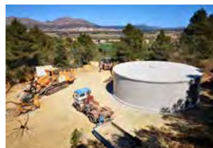
Obres del nou dipòsit d'aigua potable
