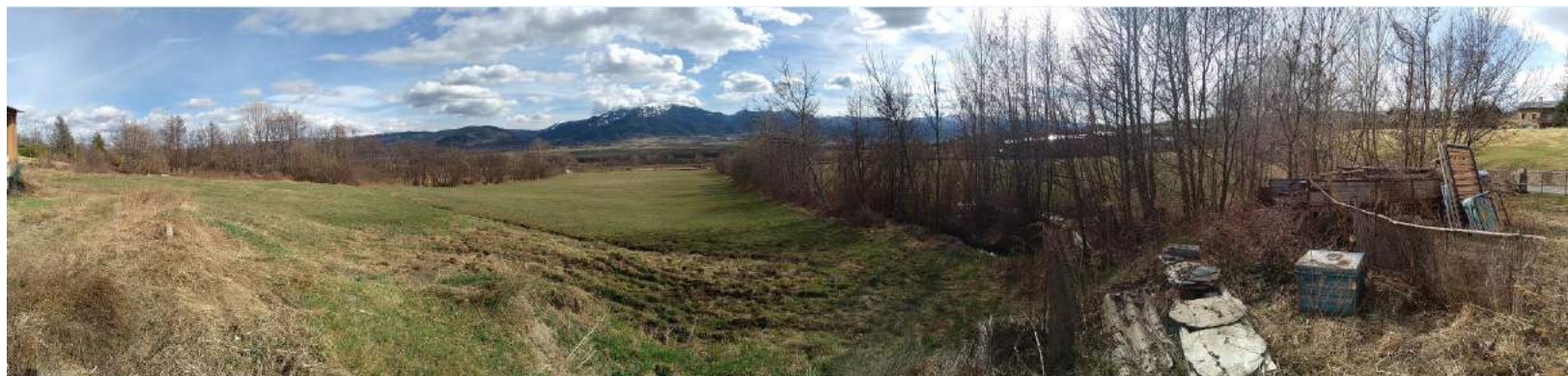
Figura 32. Vista general de l'àmbit d'estudi. Fotografia realitzada des de l'edificació situada al nord del la ZAE.
