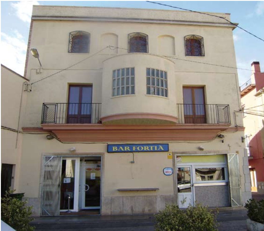
Façana de l'edifici on encara s'hi observa la cabina per la màquina projectora de cine.
