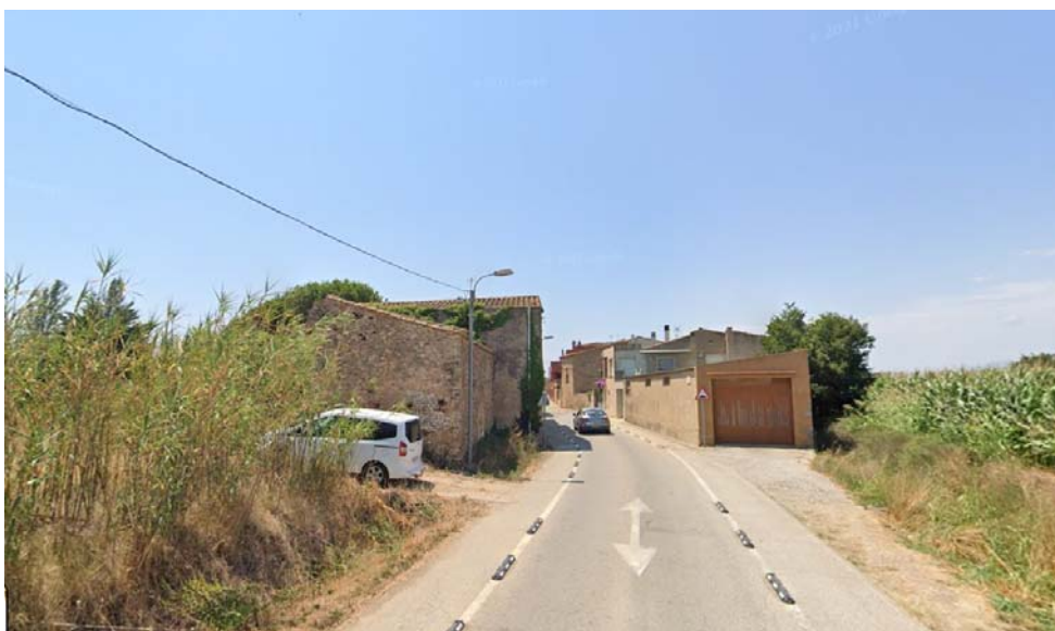
Figura 15. Actual encontre amb la carretera de Castelló entrant al nucli urbà de Fortià
