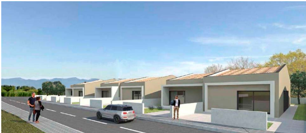
Figura 13. Vista de la inserció de la proposta del conjunt de llevant en l'enllaç amb la carretera de Castelló amb habitatges en planta baixa segons avantprojecte de la promoció
