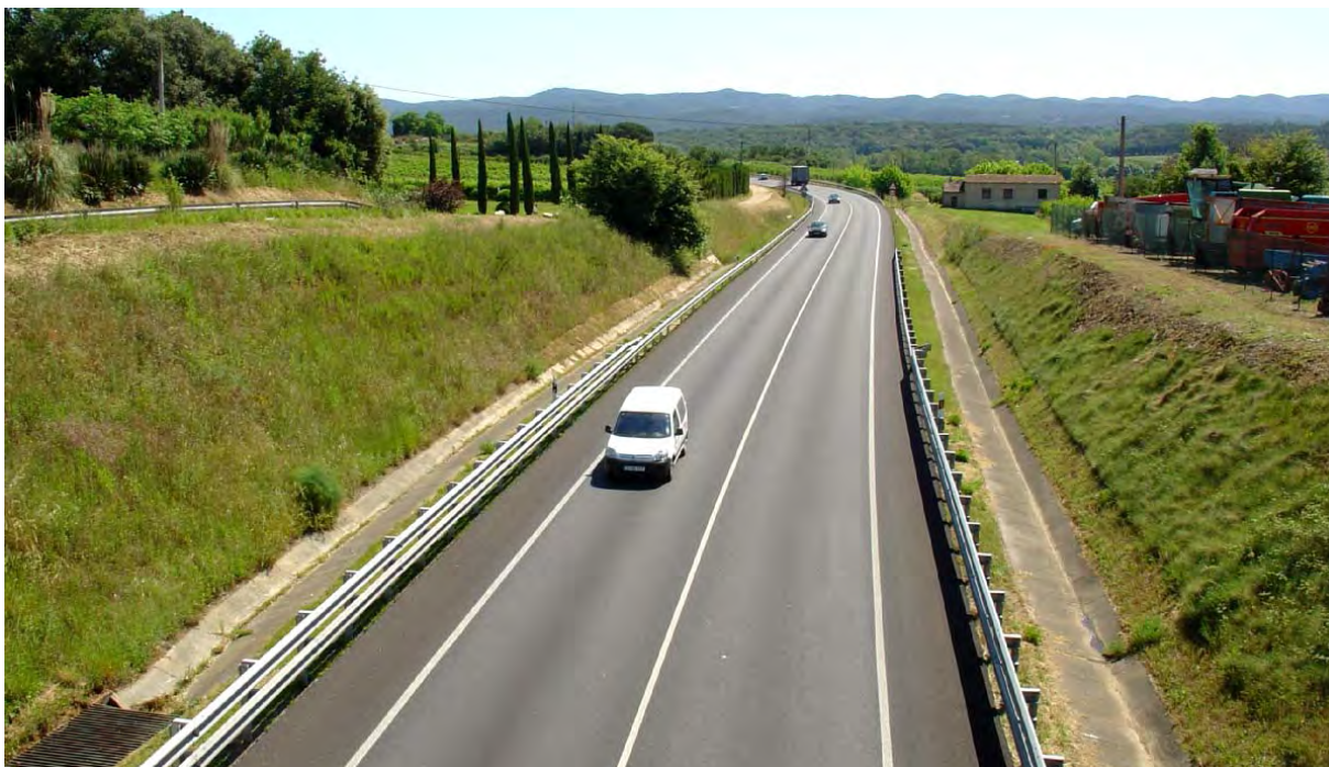
Marges verticals estables en un tram de la carretera A-2 quan va en trinxera en n tram proper al nucli urbà.
