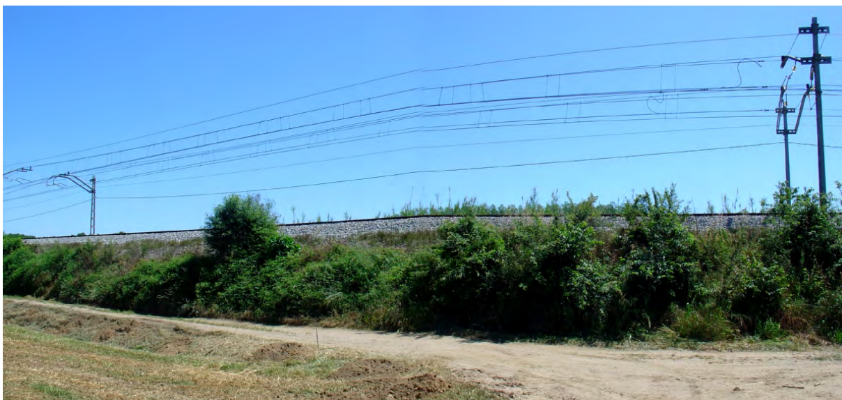
Marge de poc de més de 2 metres i pendent 3H:2V a l'entorn de la via del tren
