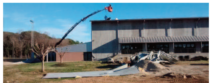
L'endemà, de bon matí, es van treure les planxes metàl·liques amb una gran ploma hidràulica que es van disposar al costat del pavelló
