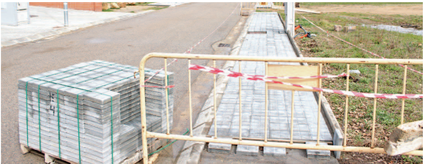
Col·locació de panots al carrer Joan Fuster
