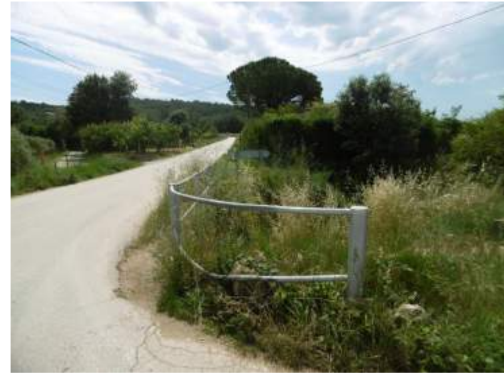
Fotografia 20. Vista actual de la carretera de Martís a la Central Elèctrica i del creuament amb el clot d'Espionella.
