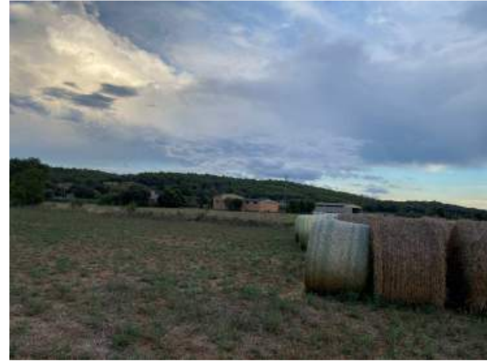
Fotografia 39. Vista actual de la línia aèria a 25 kV existent "Centrals" a retirar com a mesura compensatòria.
