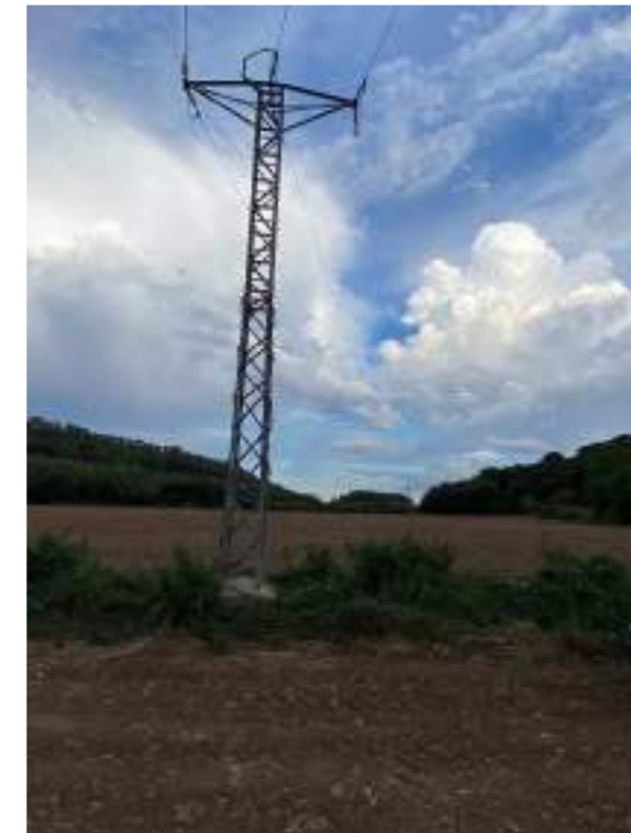
Fotografia 32. Vista dels suports existents de la línia aèria a 25 kV existent "Centrals" a retirar com a mesura compensatòria.
