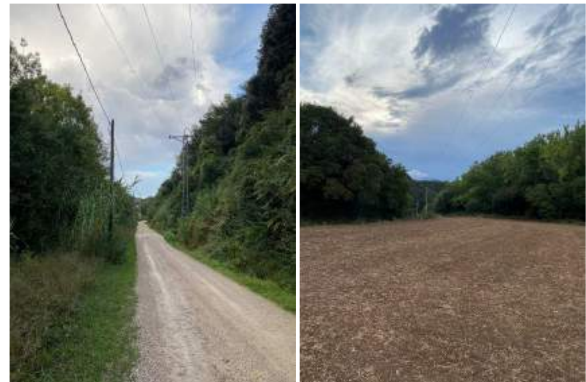
Fotografia 3 i 4. Vista actual de la línia aèria a 25 kV existent "Centrals" a retirar com a mesura compensatòria.
