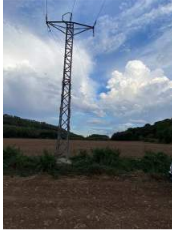
Fotografia 5. Vista dels suports existents de la línia aèria a 25 kV existent "Centrals" a retirar com a mesura compensatòria.
