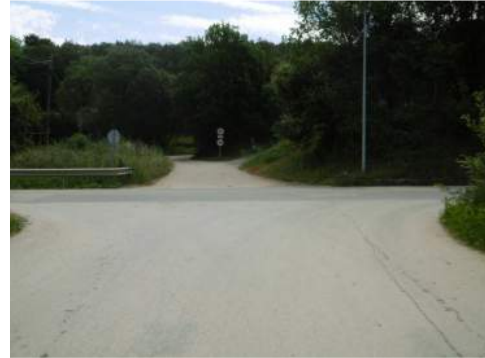
Fotografia 24. Vista actual del creuament entre la carretera de Martís a la Central Elèctrica i la carretera GIP-5121, per on transcorreran les línies d'evacuació subterrànies a 25 kV.
