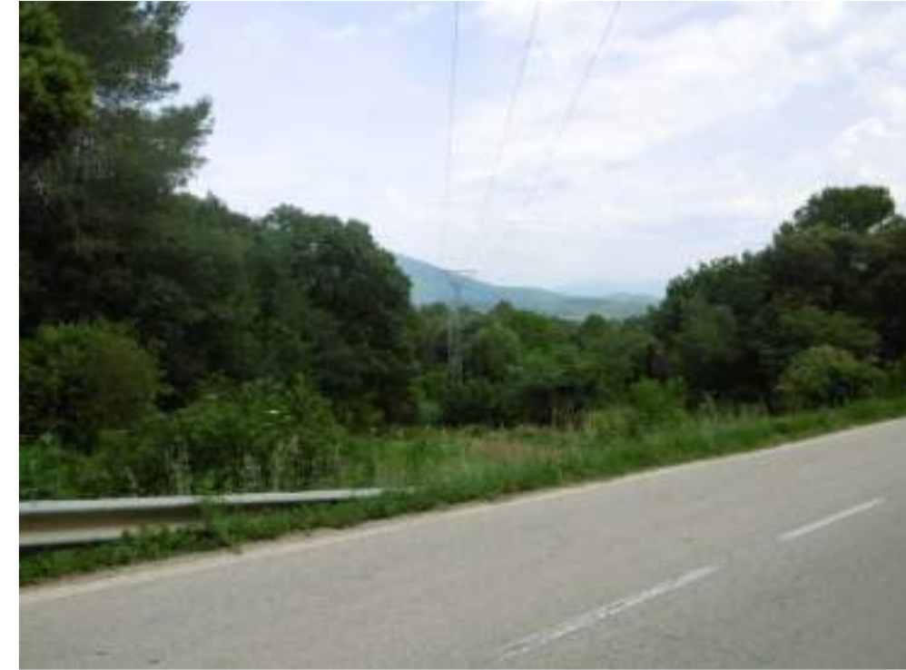
Fotografia 53. Vista actual de la línia aèria a 25 kV existent "Centrals" a retirar.
