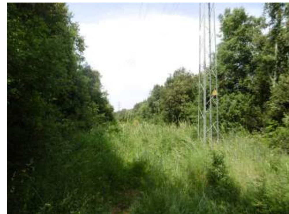
Fotografia 42. Vista actual del terreny on s'instal·laran les noves línies d'evacuació subterrànies a 25 kV, i per on es realitzarà l'accés a la nova S.E. Esponellà. Vista de la línia aèria existent a 25 kV "Serinyà".
