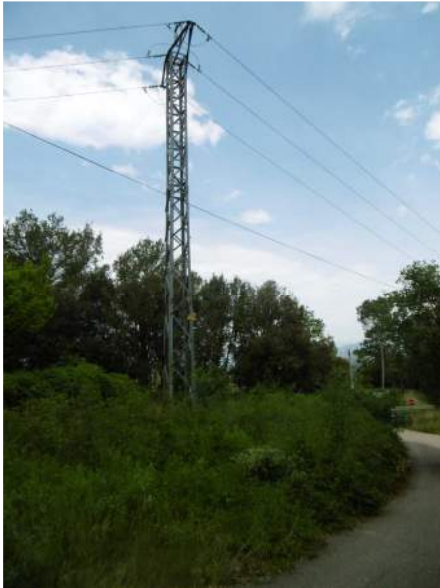
Fotografia 54. Vista actual de la línia aèria a 25 kV existent "Centrals" a retirar.
