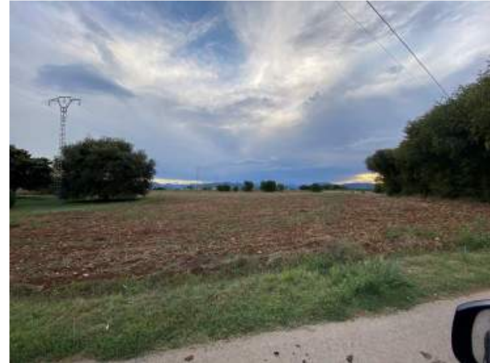
Fotografia 35. Vista actual de la línia aèria a 25 kV existent "Centrals" a retirar com a mesura compensatòria.
