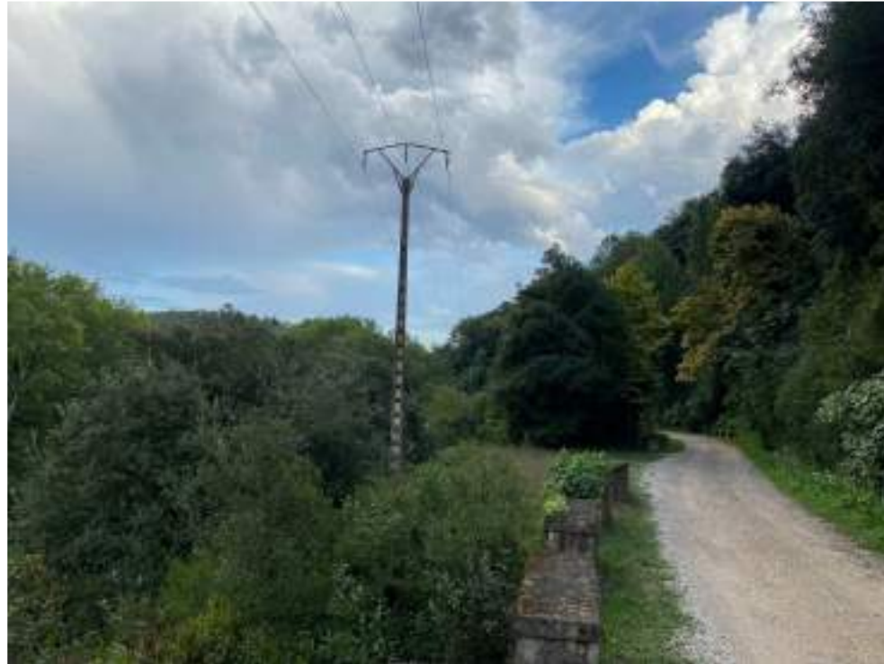
Fotografia 28. Vista actual de la línia aèria a 25 kV existent "Centrals" a retirar com a mesura compensatòria.
