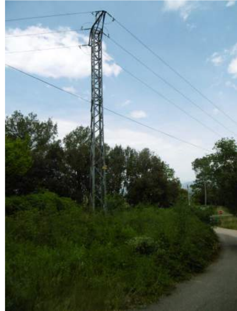
Fotografia 27. Vista actual de la línia aèria a 25 kV existent "Centrals" a retirar.
