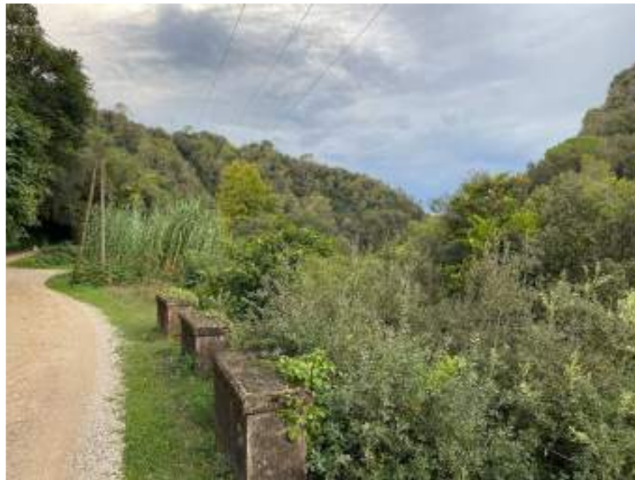
Fotografia 29. Vista actual de la línia aèria a 25 kV existent "Centrals" a retirar com a mesura compensatòria.
