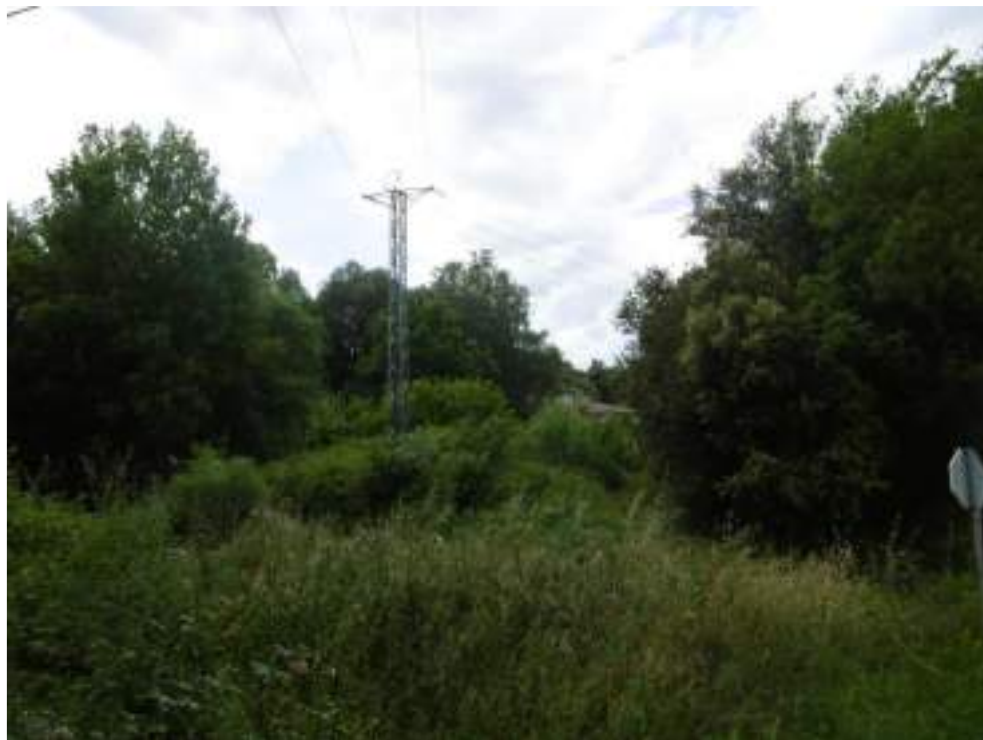
Fotografia 52. Vista actual de la línia aèria a 25 kV existent "Centrals" a retirar.
