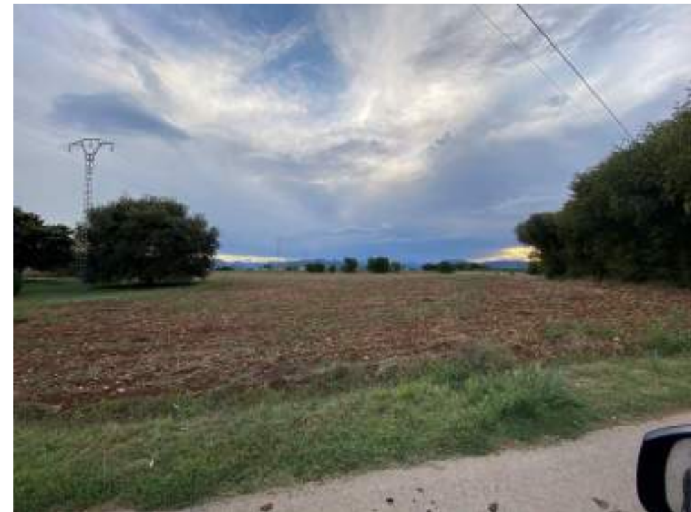
Fotografia 8. Vista actual de la línia aèria a 25 kV existent "Centrals" a retirar com a mesura compensatòria.
