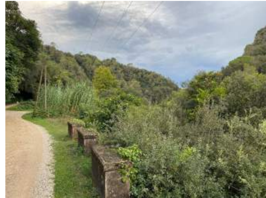
Fotografia 2. Vista actual de la línia aèria a 25 kV existent "Centrals" a retirar com a mesura compensatòria.
