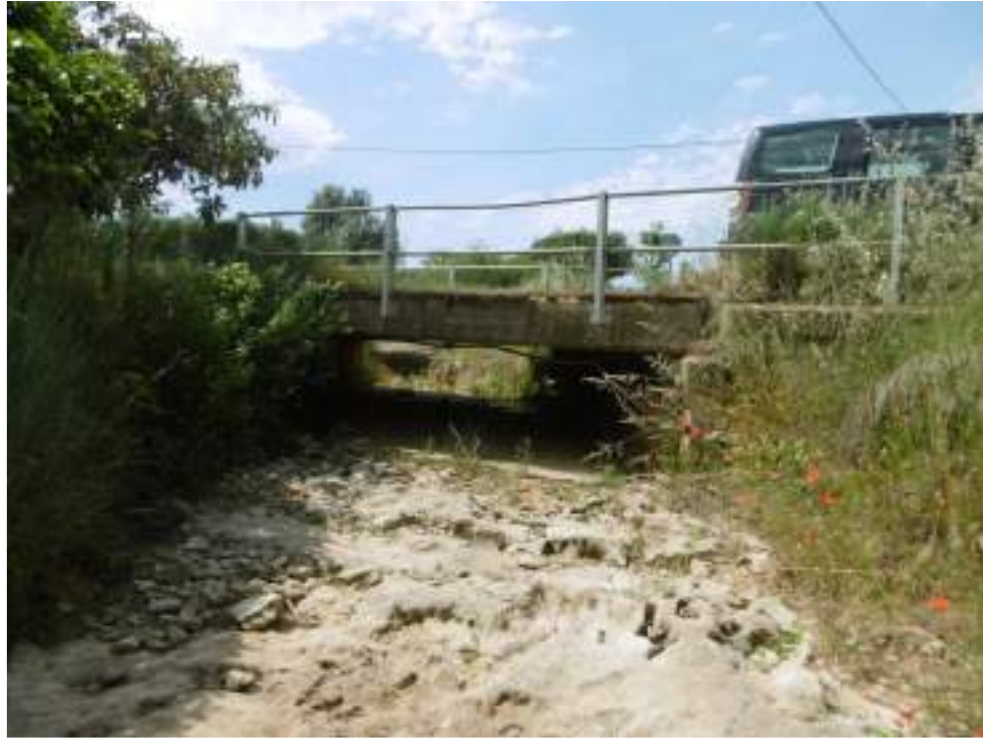
Fotografia 22. Vista actual de la carretera de Martís a la Central Elèctrica i del creuament amb el clot d'Espionella.
