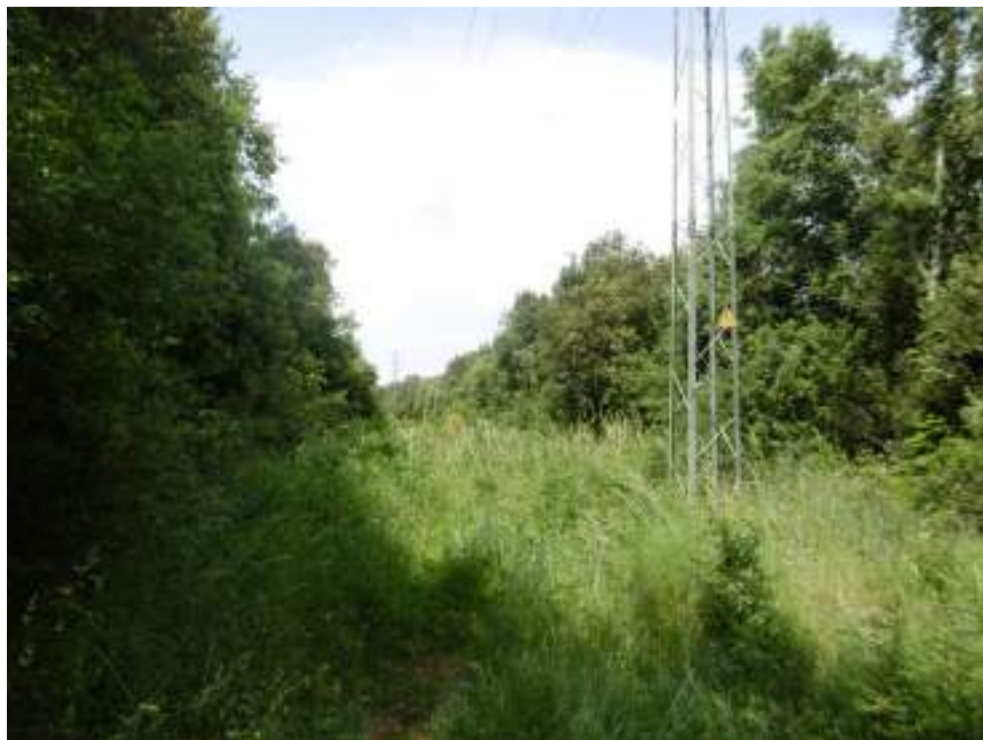
Fotografia 15. Vista actual del terreny on s'instal·laran les noves línies d'evacuació subterrànies a 25 kV, i per on es realitzarà l'accés a la nova S.E. Esponellà. Vista de la línia aèria existent a 25 kV "Serinyà".
