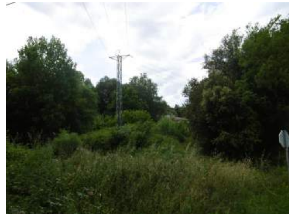
Fotografia 25. Vista actual de la línia aèria a 25 kV existent "Centrals" a retirar.
