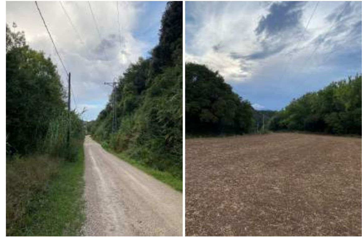
Fotografies 30 i 31. Vista actual de la línia aèria a 25 kV existent "Centrals" a retirar com a mesura compensatòria.
