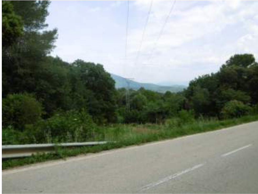
Fotografia 26. Vista actual de la línia aèria a 25 kV existent "Centrals" a retirar.
