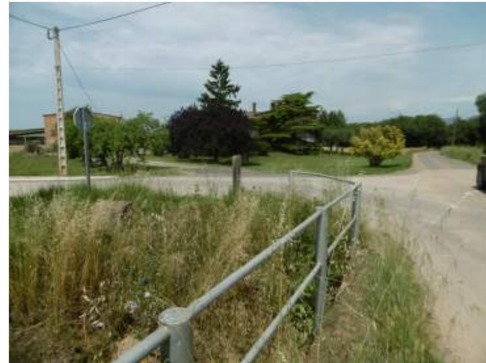
Fotografia 33. Vista actual de la zona on s'implantarà el nou CT-020 "Martís".
