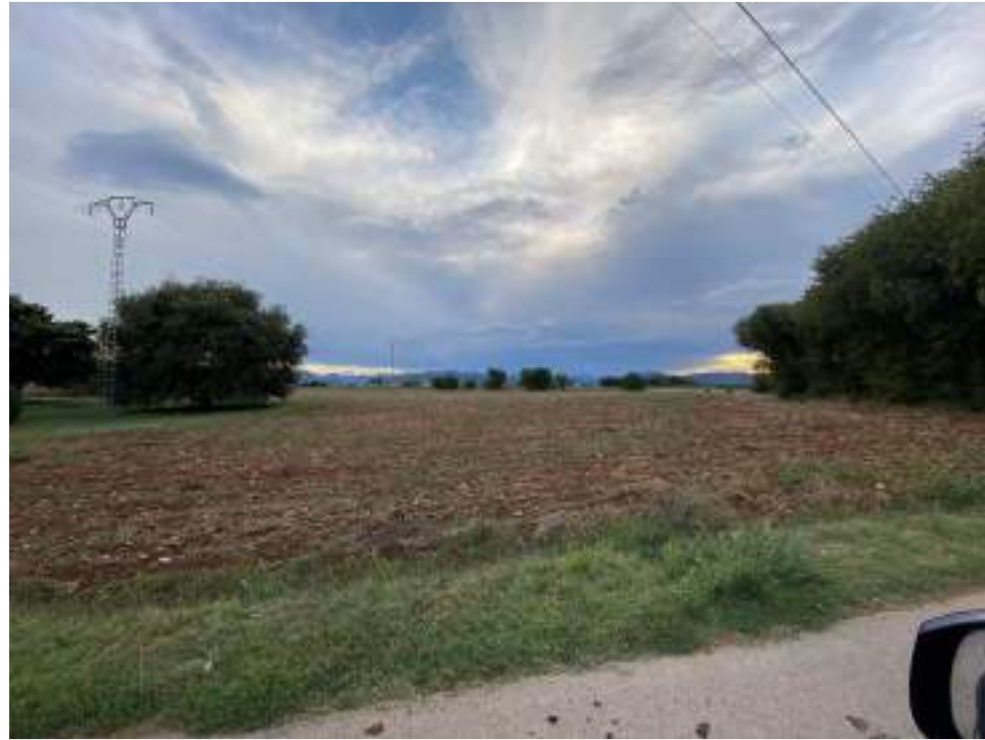
Fotografia 22. Vista actual de la línia aèria a 25 kV existent "Centrals" a retirar com a mesura compensatòria.
