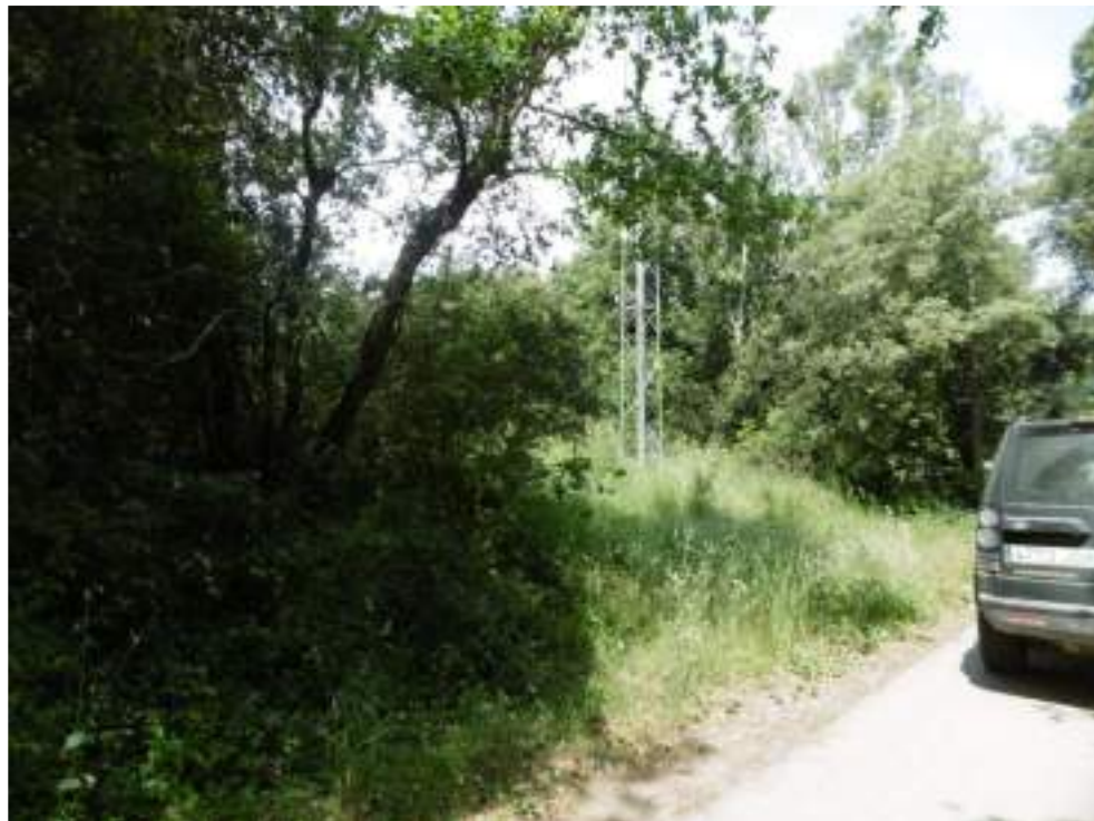
Fotografia 4. Vista actual de la línia aèria existent a 25 kV "Serinyà", i de la zona on s'iniciarà l'accés a la nova S.E. Esponellà des de la carretera de Martís a la Central Elèctrica.
