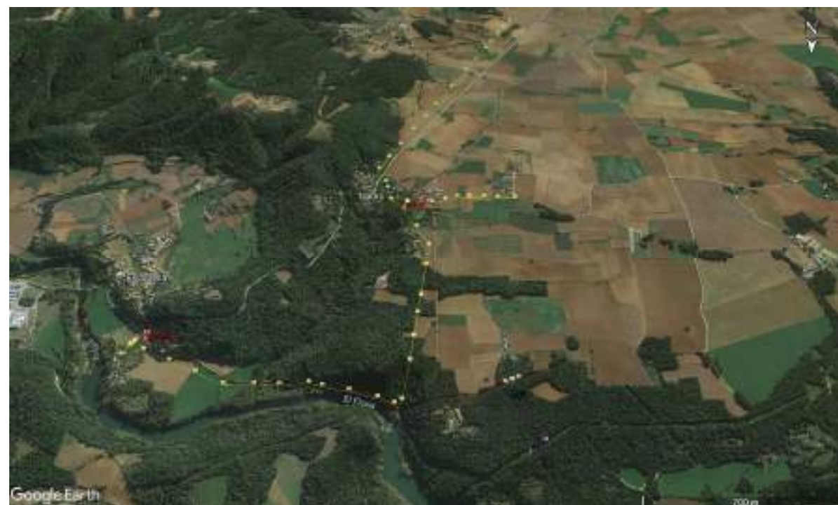
Imatge 59. Geomorfologia de l'alternativa 2 de la nova S.E. Espanellà i línies de connexió i evacuació. Font: Elaboració pròpia a partir de imatges del Google Earth.
