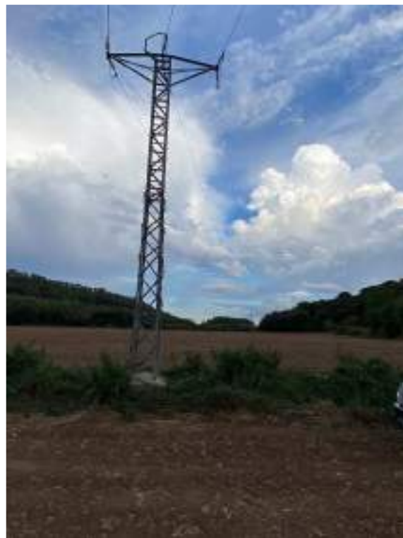
Fotografia 19. Vista dels suports existents de la línia aèria a 25 kV existent "Centrals" a retirar com a mesura compensatòria.
