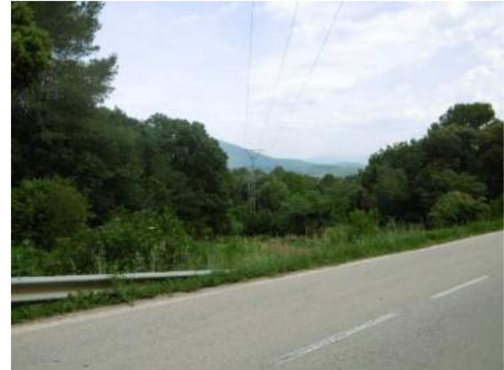
Fotografia 13. Vista actual de la línia aèria a 25 kV existent "Centrals" a retirar.
