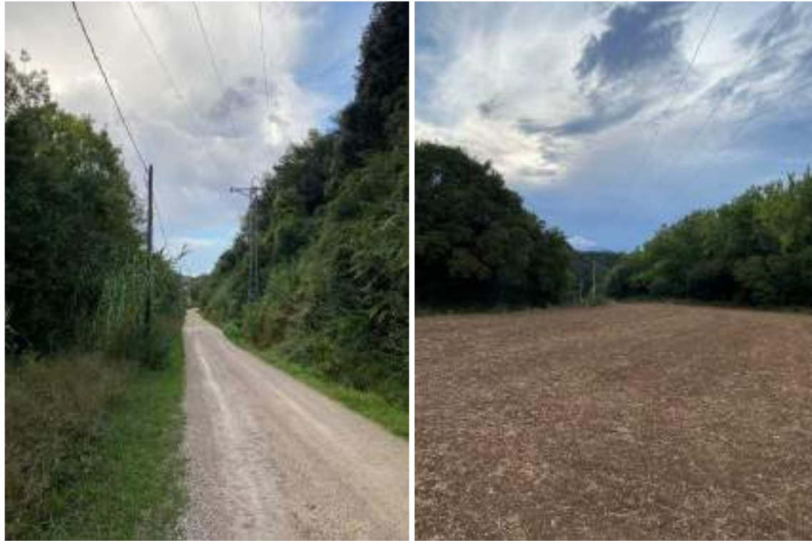
Fotografies 17 i 18. Vista actual de la línia aèria a 25 kV existent "Centrals" a retirar com a mesura compensatòria.
