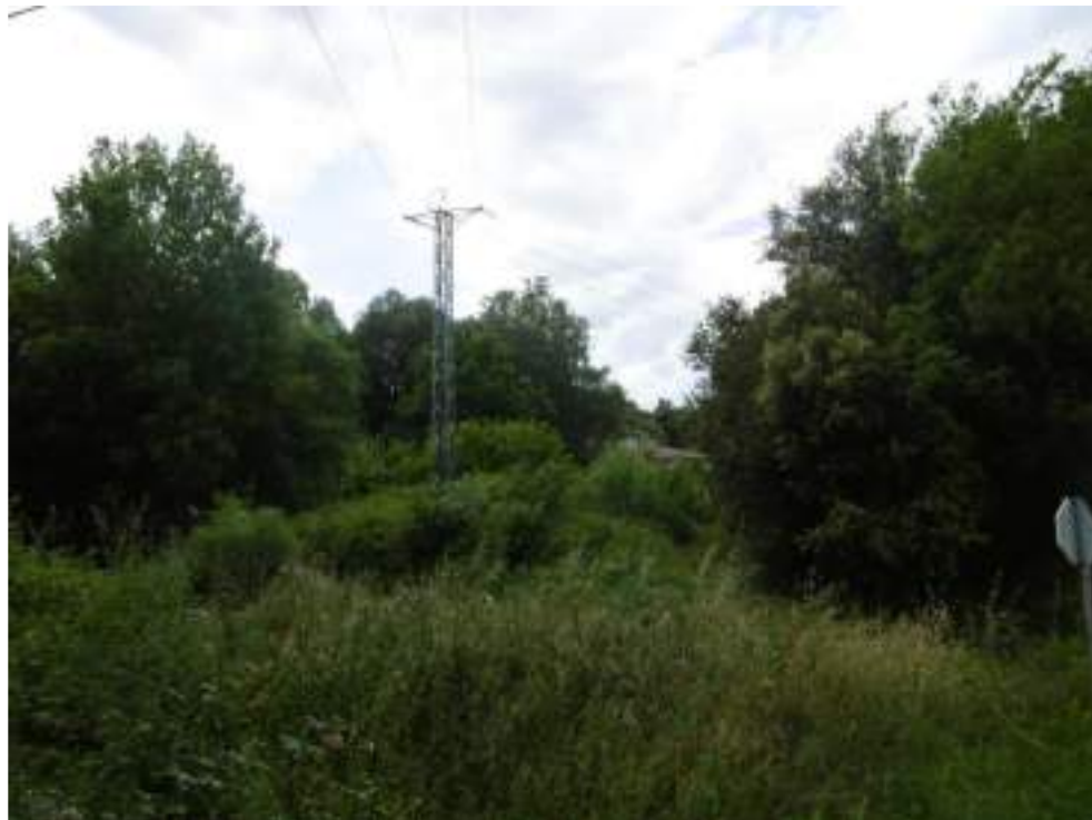
Fotografia 12. Vista actual de la línia aèria a 25 kV existent "Centrals" a retirar.
