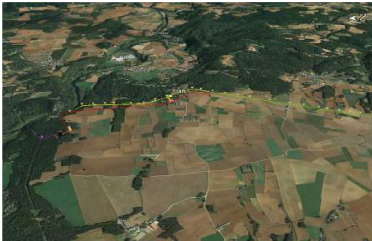
Imatge 62. Geomorfologia de l'alternativa 3 de la nova S.E. Esponellà i línies de connexió i evacuació. Font: Elaboració pròpia a partir de imatges del Google Earth.
