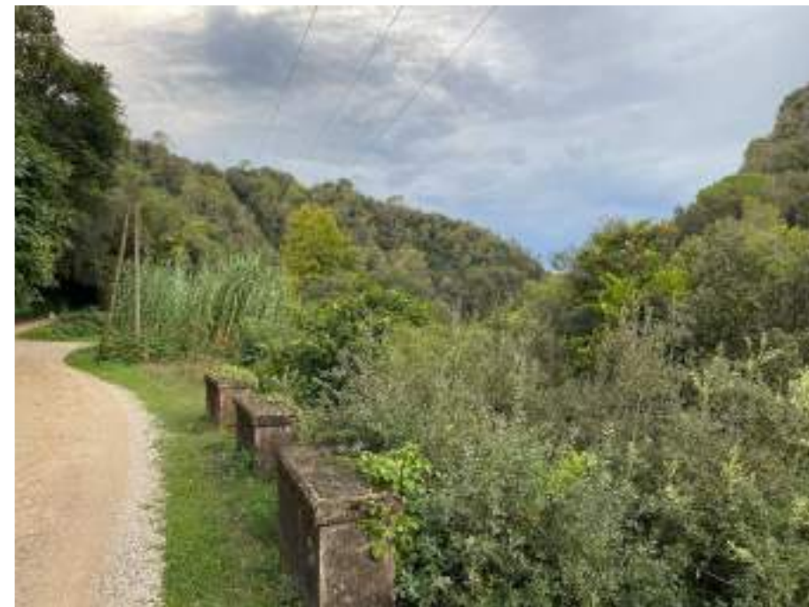
Fotografia 16. Vista actual de la línia aèria a 25 kV existent "Centrals" a retirar com a mesura compensatòria.
