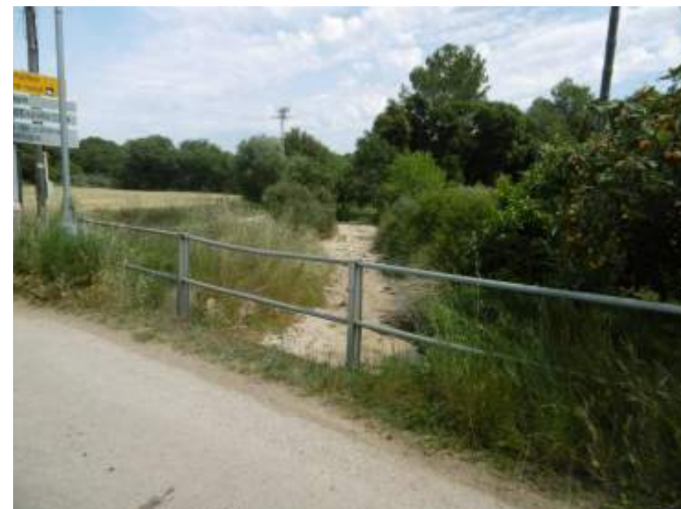
Fotografia 10. Vista actual de la carretera de Martís a la Central Elèctrica i del creuament amb el clot d'Espot.
