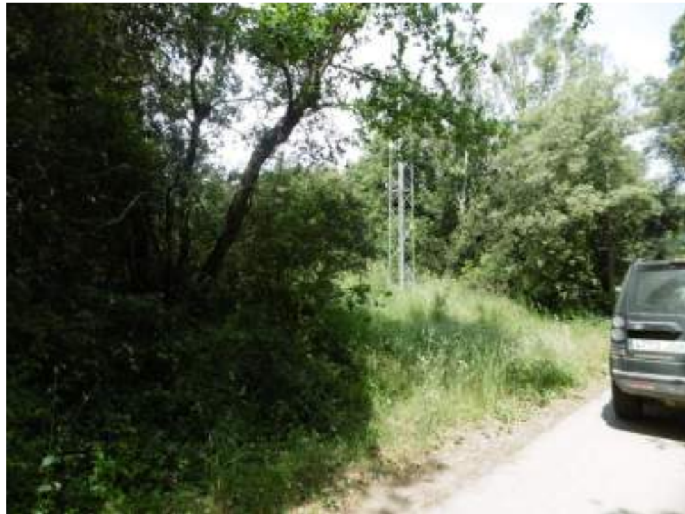
Fotografia 31. Vista actual de la línia aèria existent a 25 kV "Serinyà", i de la zona on s'iniciarà l'accés a la nova S.E. Esponellà des de la carretera de Martís a la Central Elèctrica.
