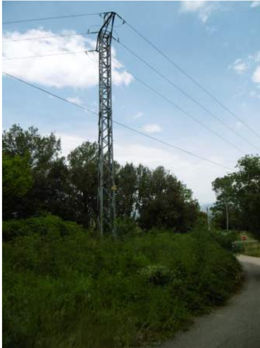
Fotografia 41. Vista actual de la línia aèria a 25 kV existent "Centrals" a retirar.
