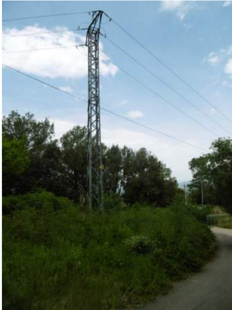
Fotografia 14. Vista actual de la línia aèria a 25 kV existent "Centrals" a retirar.
