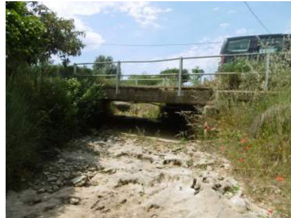
Fotografia 9. Vista actual de la carretera de Martís a la Central Elèctrica i del creuament amb el clot d'Espot.
