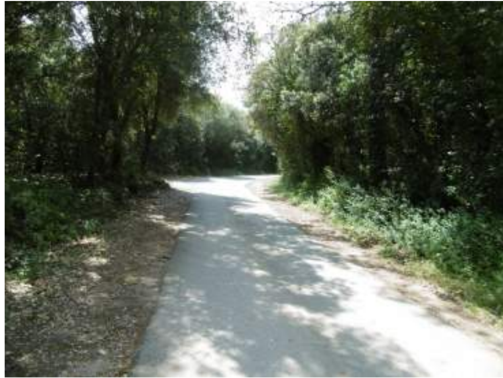
Fotografia 30. Vista actual de la carretera de Martís a la Central Elèctrica per on transcorreren les noves línies d'evacuació subterrànies a 25 kV.
