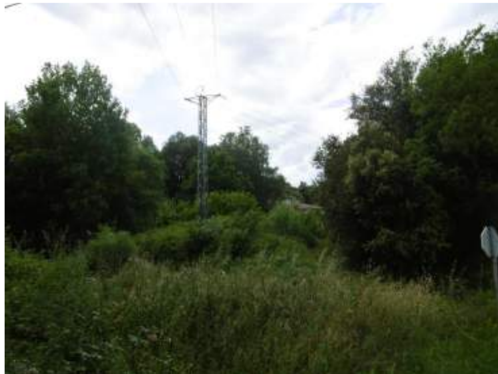
Fotografia 39. Vista actual de la línia aèria a 25 kV existent "Centrals" a retirar.
