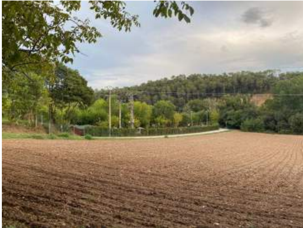
Fotografia 27. Vista actual de la línia aèria a 25 kV existent "Espanellà" a retirar com a mesura compensatòria.
