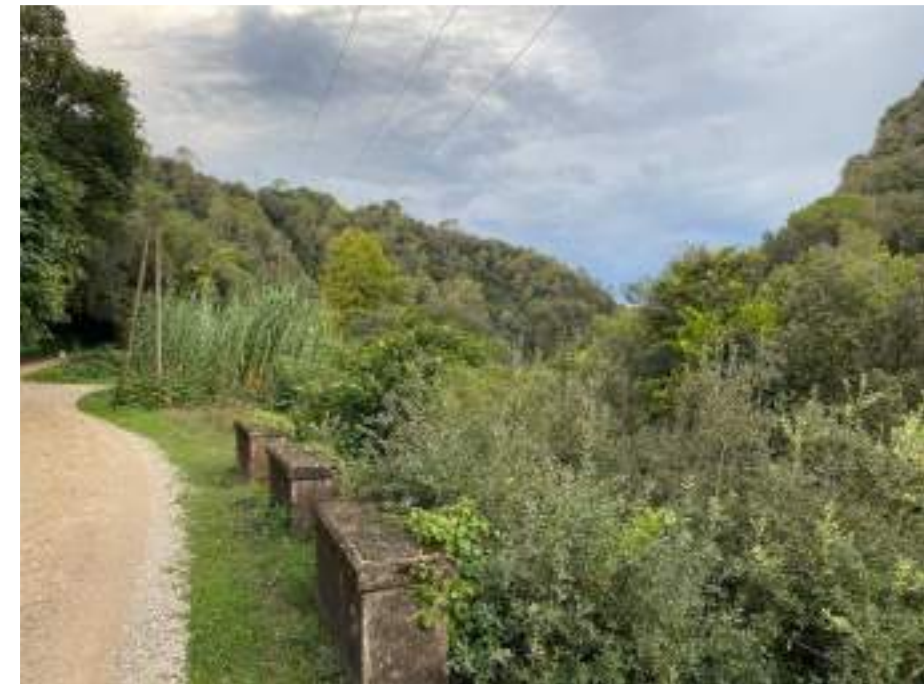
Fotografia 43. Vista actual de la línia aèria a 25 kV existent "Centrals" a retirar com a mesura compensatòria.
