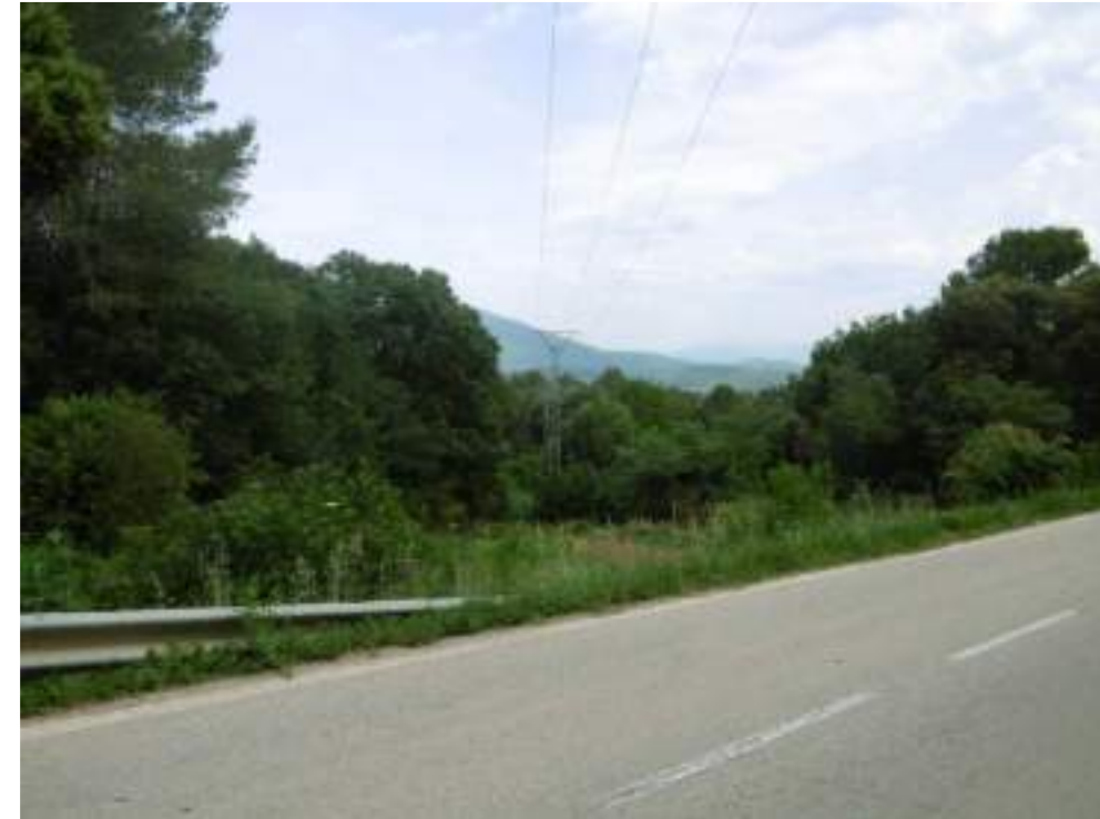
Fotografia 40. Vista actual de la línia aèria a 25 kV existent "Centrals" a retirar.
