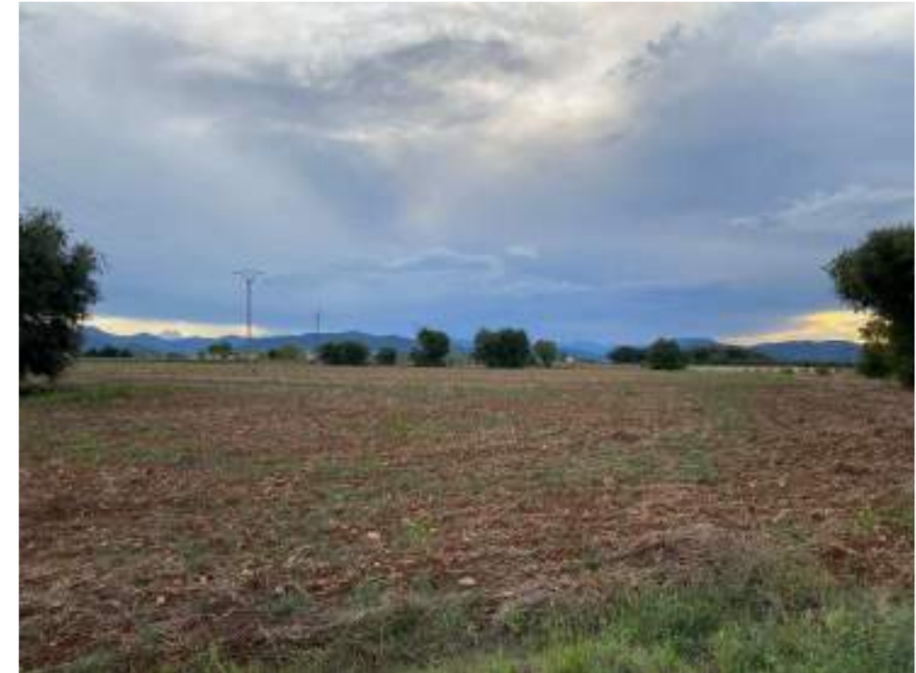
Fotografia 20. Vista actual de la línia aèria a 25 kV existent "Centrals" a retirar com a mesura compensatòria.
