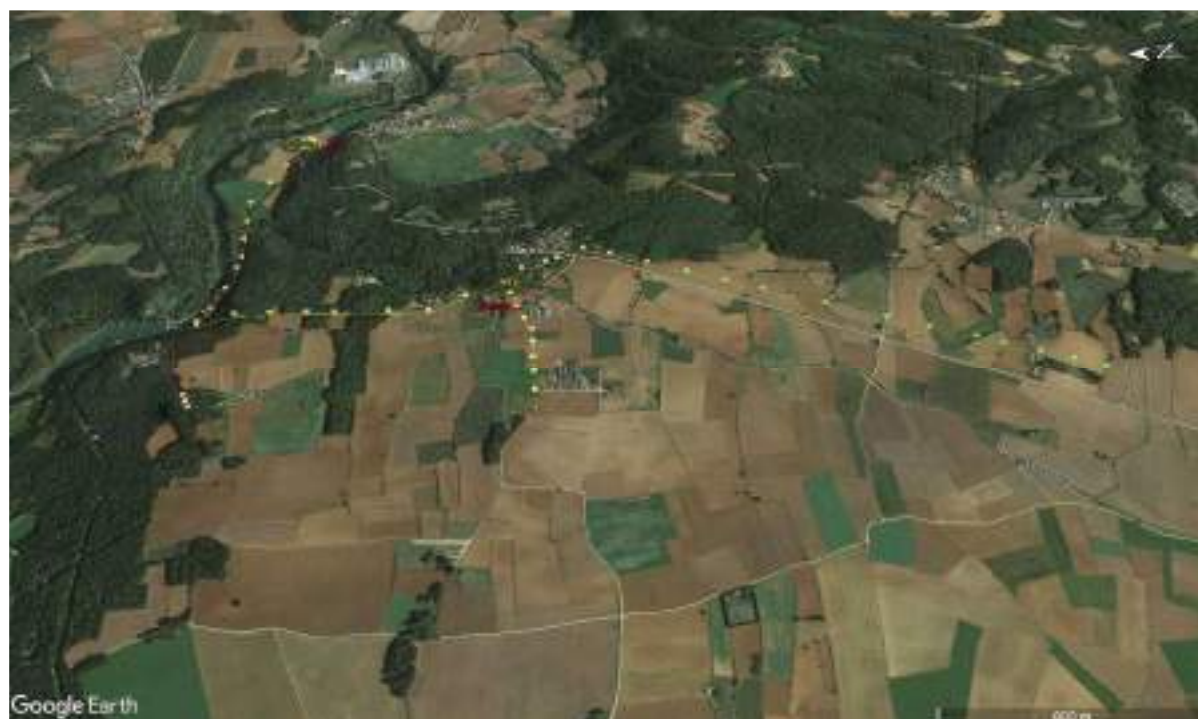
Imatge 58. Geomorfologia de l'alternativa 2 de la nova S.E. Espanellà i línies de connexió i evacuació. Font: Elaboració pròpia a partir de imatges del Google Earth.
