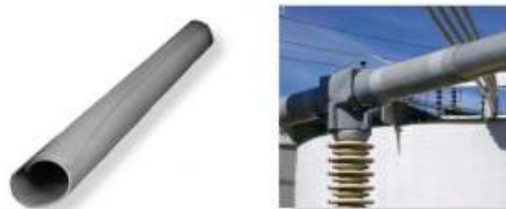
Imatge 228. Exemple de protecció embarrat 25 kV.
