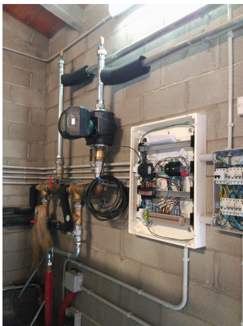
Imatge 6.- Situació del col·lector existent durant el seu muntatge
