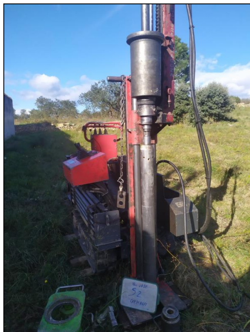
Foto 3. Execució sondeig S-2
