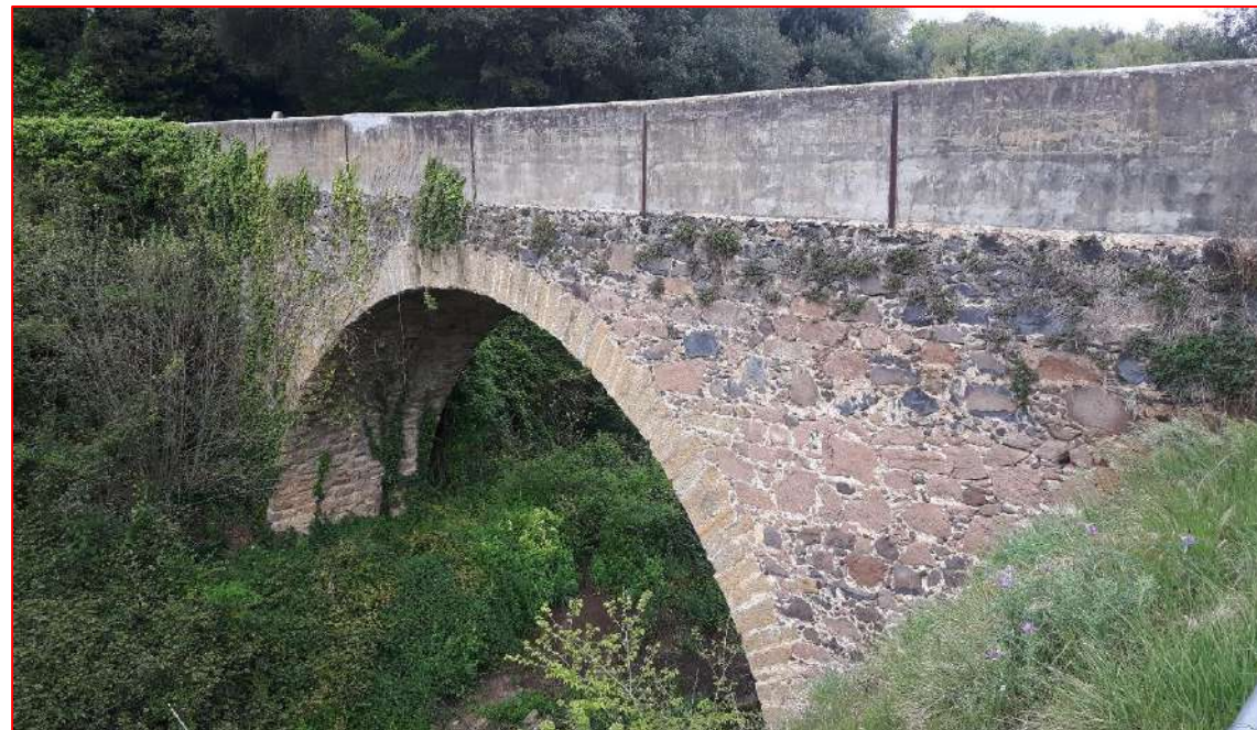
Figura 1. Vista de la cara d'aigua avall del pont de l'Estanyol des del marge esquerre.
