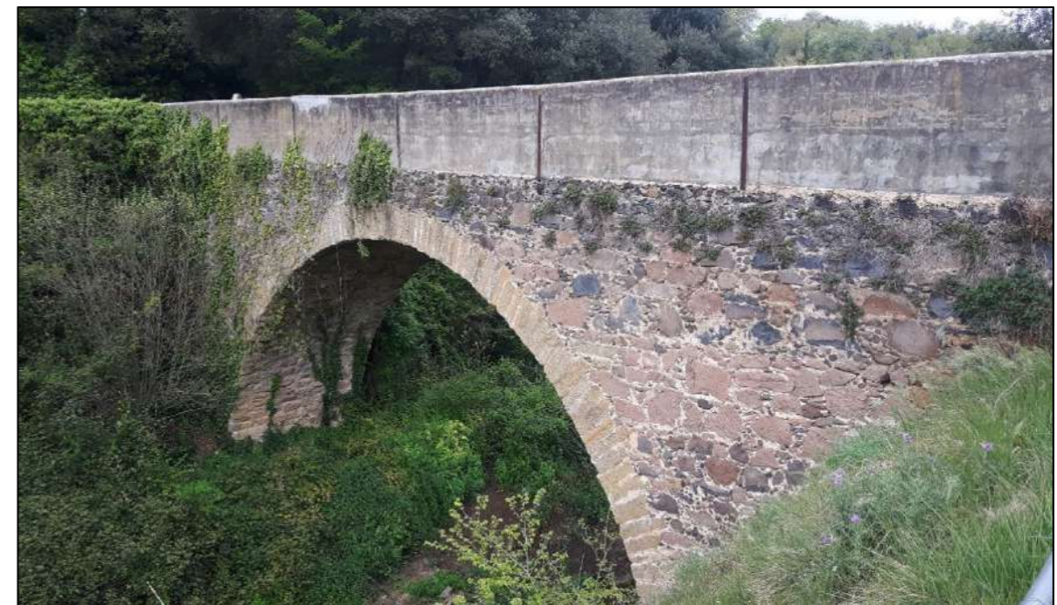
Figura 2. Vista lateral del pont des d'aigua avall.
