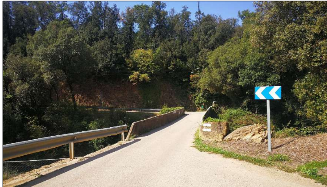
Figura 3. Vista del pont de l'Estanyol des de l'accés del marge esquerre.
