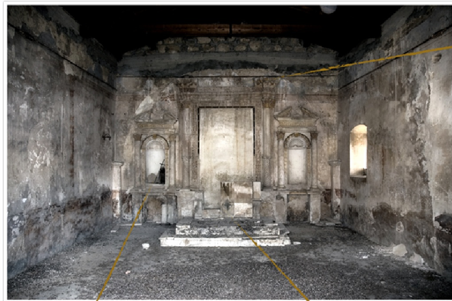
All'interno risulta a vista la trave perimetrale in cemento armato, realizzata in occasione del rifacimento del tetto avvenuto nel 1995.
