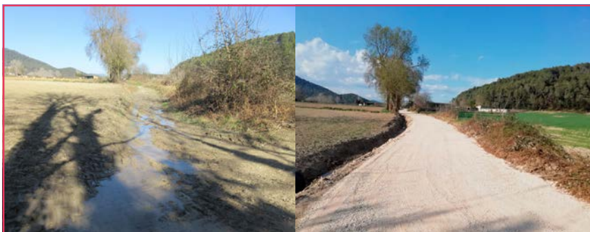
Camí de Can Pigem abans i després de l'arranjament.
