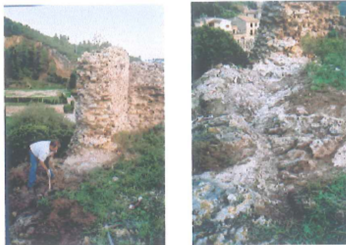
Fig. 4: Dues vistes de lloc on es va realitzar el sondeig núm. 2, on s'aprecia l'arrasament total del mur i la canalització excavada a la roca
