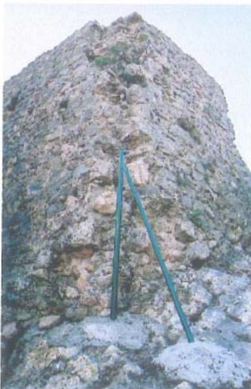
Fig. 3: Detall de la fonamentació de l'angle sud-est l'edifici damunt la roca natural del subsòl
