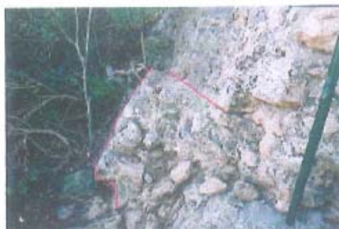
Fig 7: Detall de la banquetta a l'angle sud-est del mateix mur
