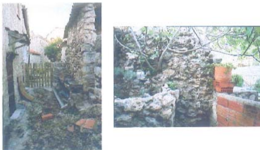
Fig. 8: Vista general del carreró annex pel costat de ponent i detall d'unes restes de possible mur del castell per aquest costat
