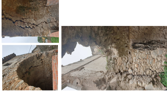
Fotografies de reforçament i separació dels murs.
