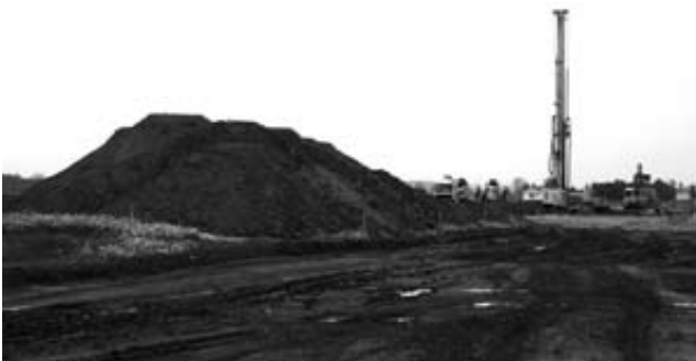
Les obres que s'han iniciat a la carretera de Torroella de Fluvià.
