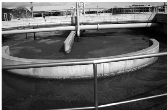
Figura 1. Reactor biològic
