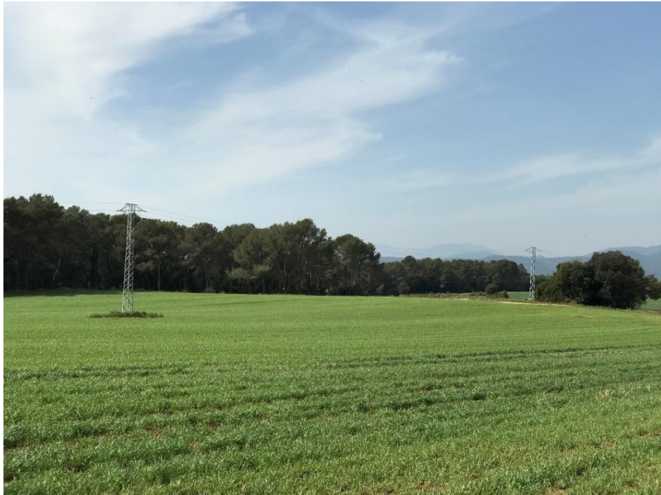
Figura 31. Línia elèctrica de MT pertanyent a Electra Avellana que discorre paral·lela a la carretera pel PK 0+800
