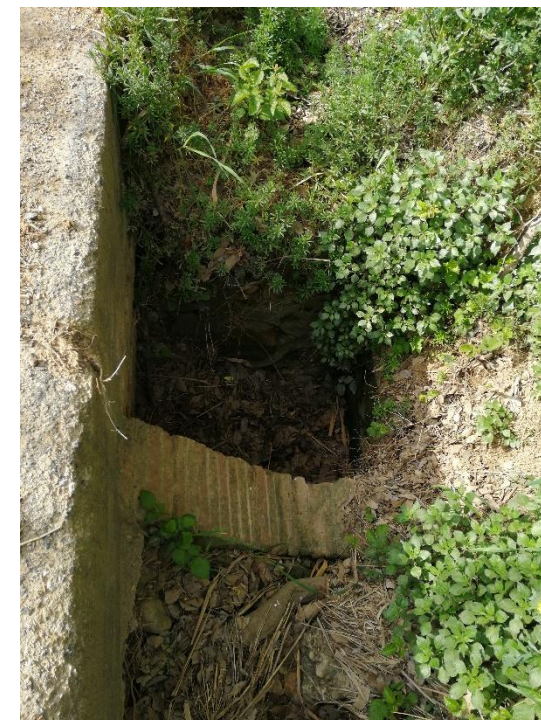
Figura 58. Obra de drenatge 6 al PK 2+650 de la GIV-5142
