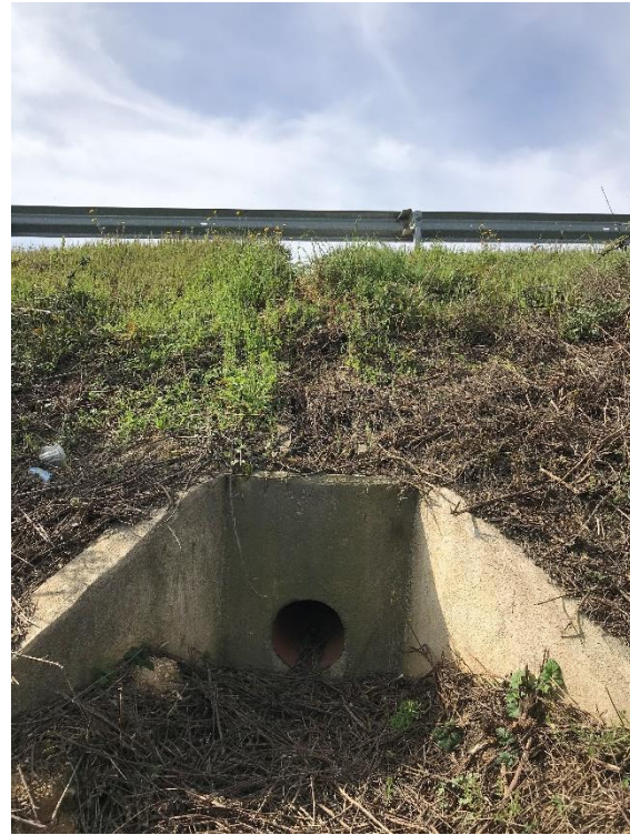
Figura 5. Imatge de l'obra de drenatge 1 al PK 0+140
