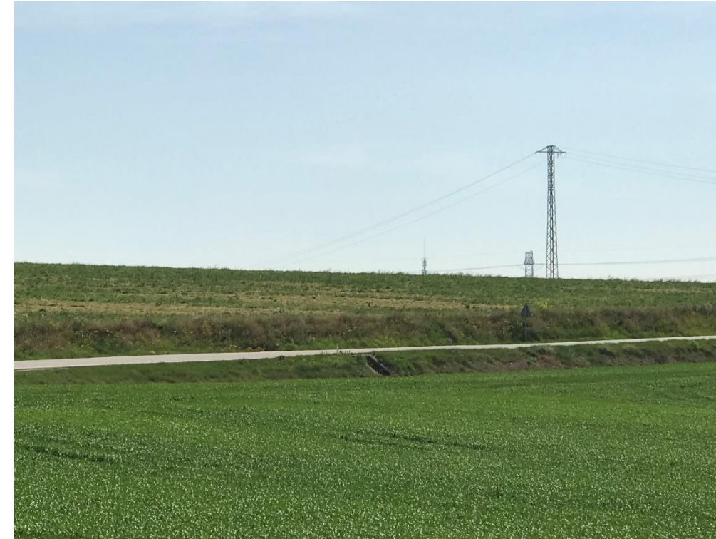
Figura 25. Vista de la zona del PK 0+450 de la carretera actual des del PK 0+650
