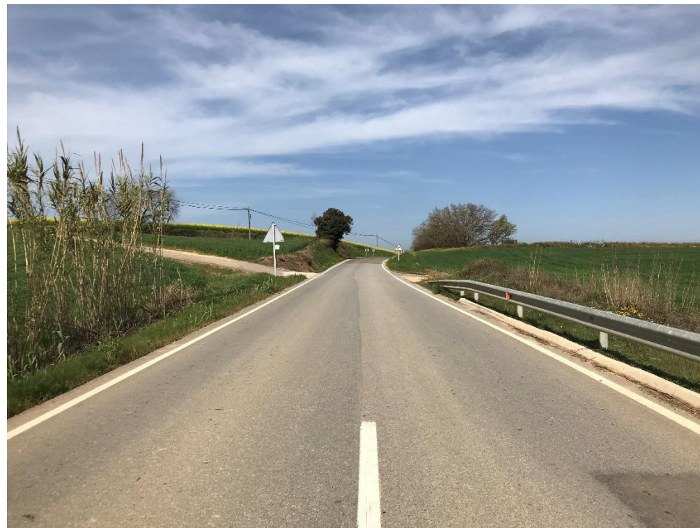
Figura 6. Vista general des del PK 0+200 en sentit Sant Esteve de Guialbes
