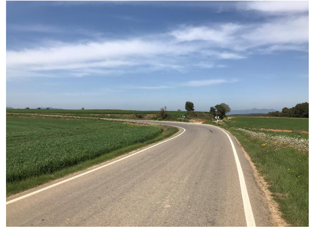
Figura 21. Vista general de la GIV-5142 en sentit Sant Esteve de Guialbes al PK 0+550
