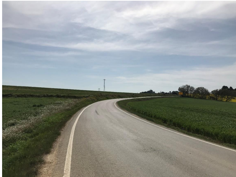
Figura 23. Vista des del PK de projecte 0+600 en sentit Girona-Figueres
