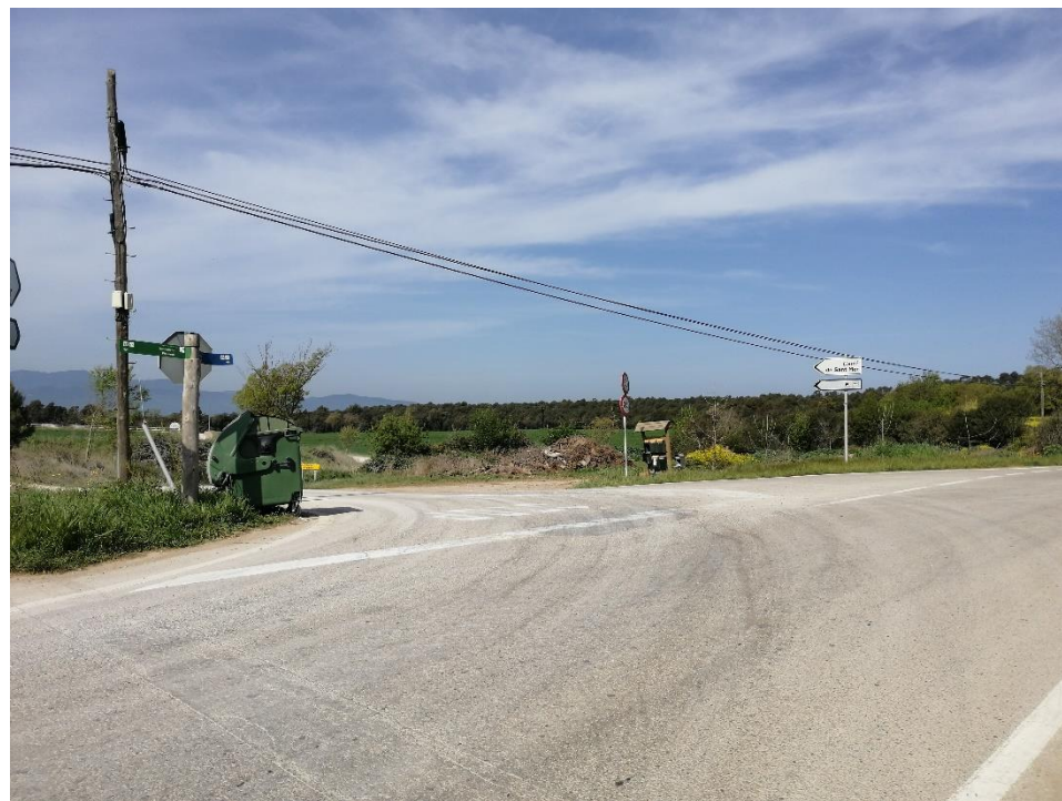
Figura 52. Intersecció al PK 2+250 de la GIV-5142, amb creuament de línia telefònica
