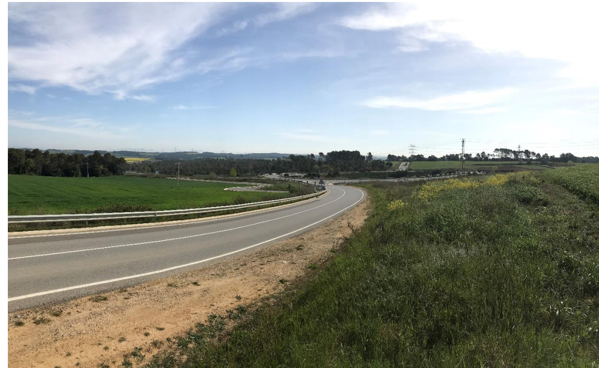
Figura 3. Vista general del tram inicial de la GIV-5142
