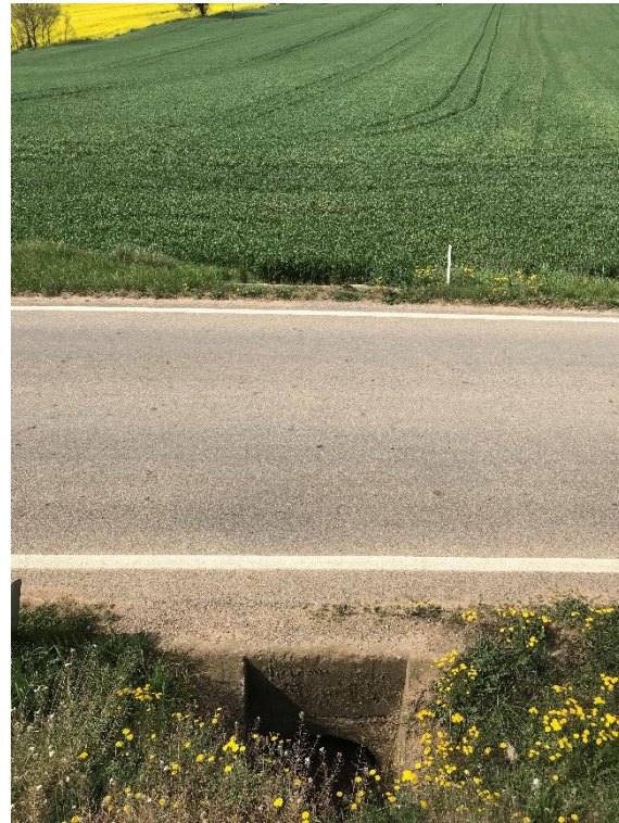
Figura 19. Imatge de l'obra de drenatge 2 al PK 0+480
