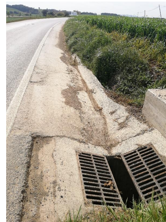
Figura 50. Entrada de l'obra de drenatge 5 PK 2+100
