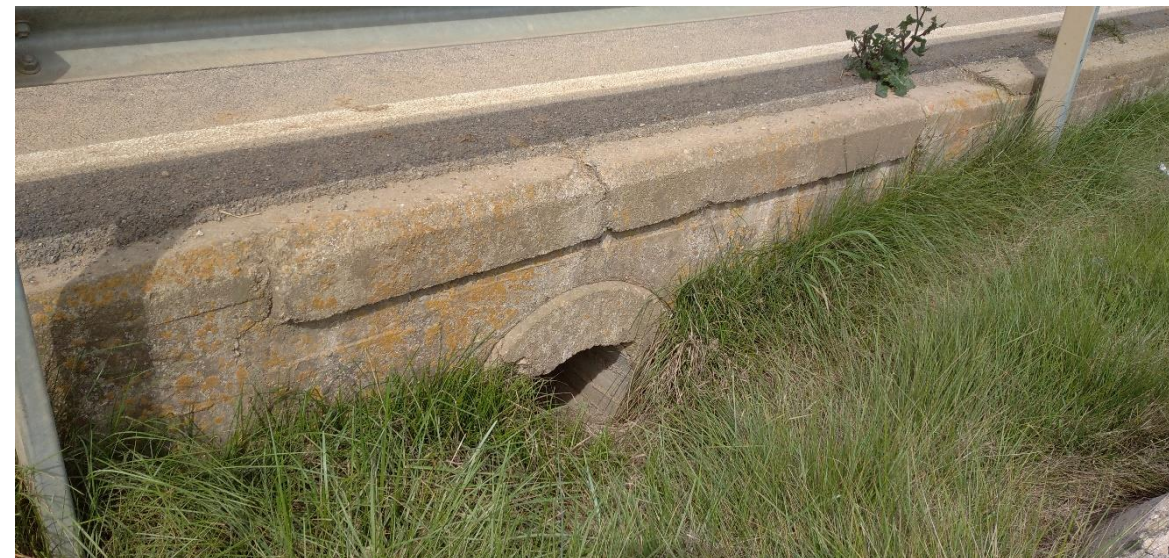
Figura 42. Entrada de la ODTL 3 i mur al PK 1+300
