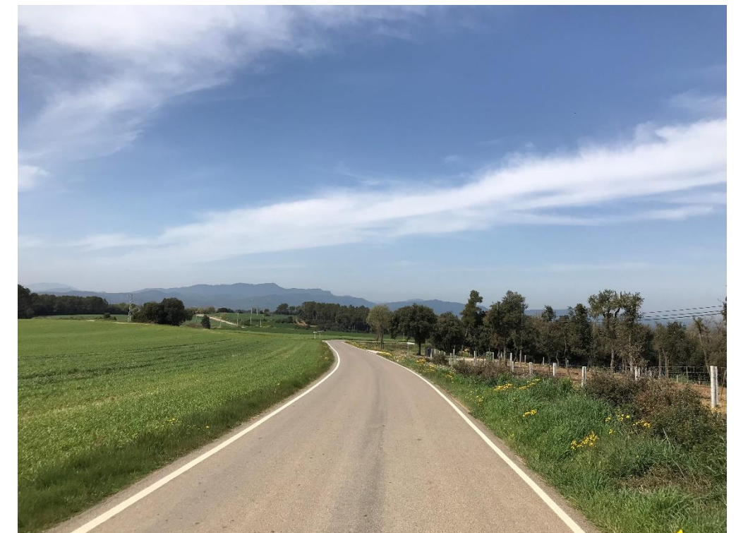
Figura 30. Vista general de la carretera en sentit Sant Esteve de Guialbes, des del PK 0+750
