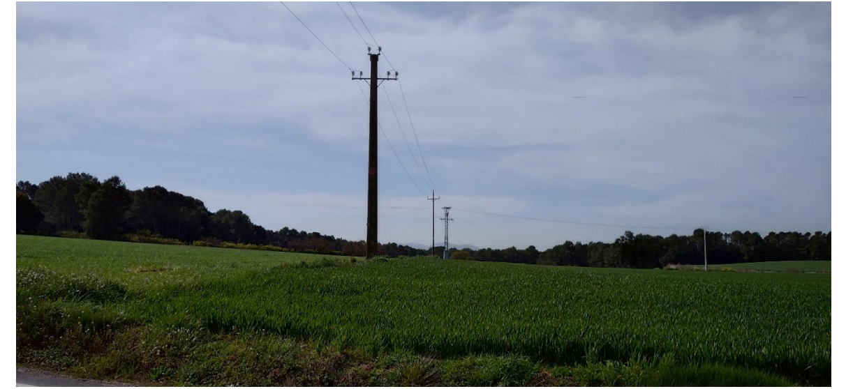
Figura 38. Línia elèctrica de MT que creua la traça d'ela carretera pel PK 1+050
