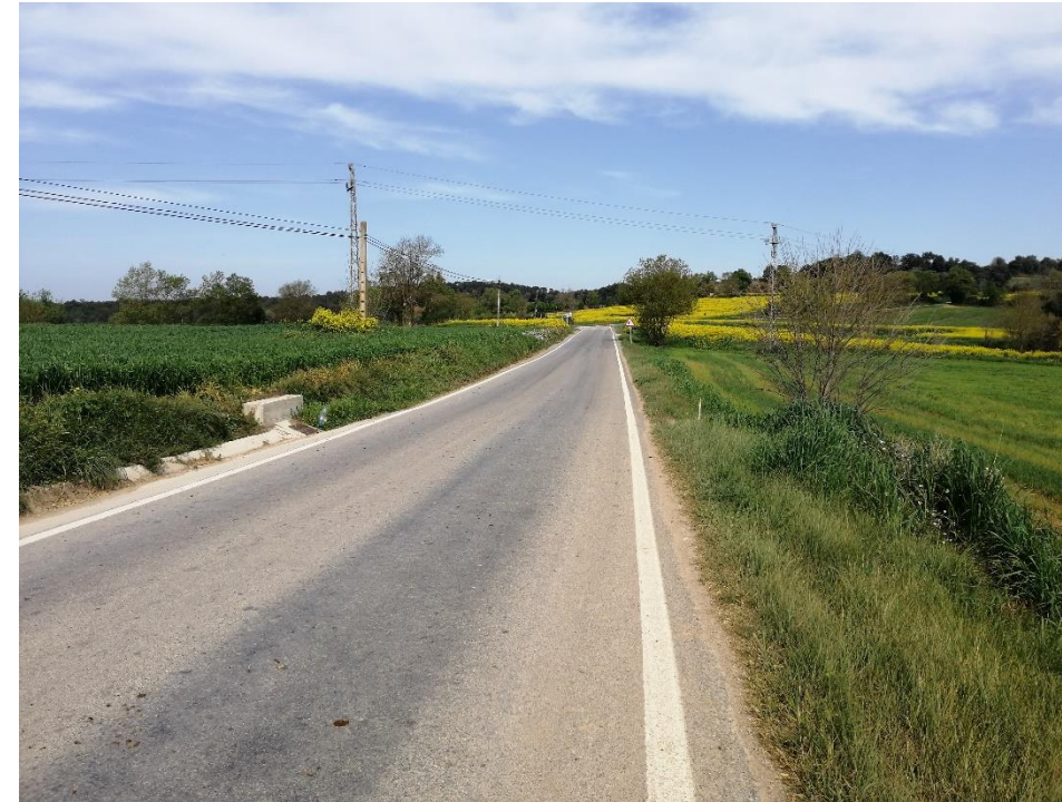
Figura 49. Vista general de la GIV-5142 en sentit Sant Esteve de Guialbes, des del PK 2+100, amb línia telefònica que discorre paral·lela a la carretera i línia de MT que la creua
