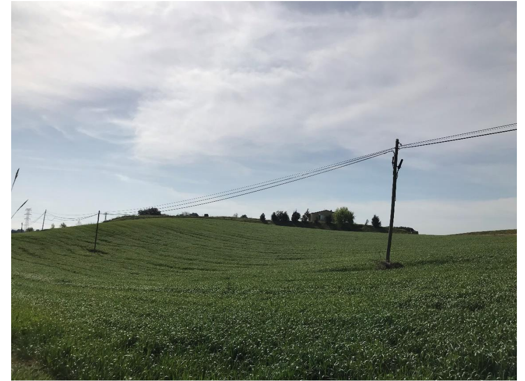
Figura 7. Vista general de la línia de telecomunicacions que discorre pel marge esquerre, al voltant del PK 0+230
