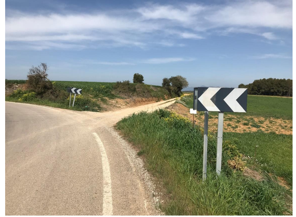
Figura 22. Vista de l'accés a finques al marge dret de la carretera pel PK 0+600
