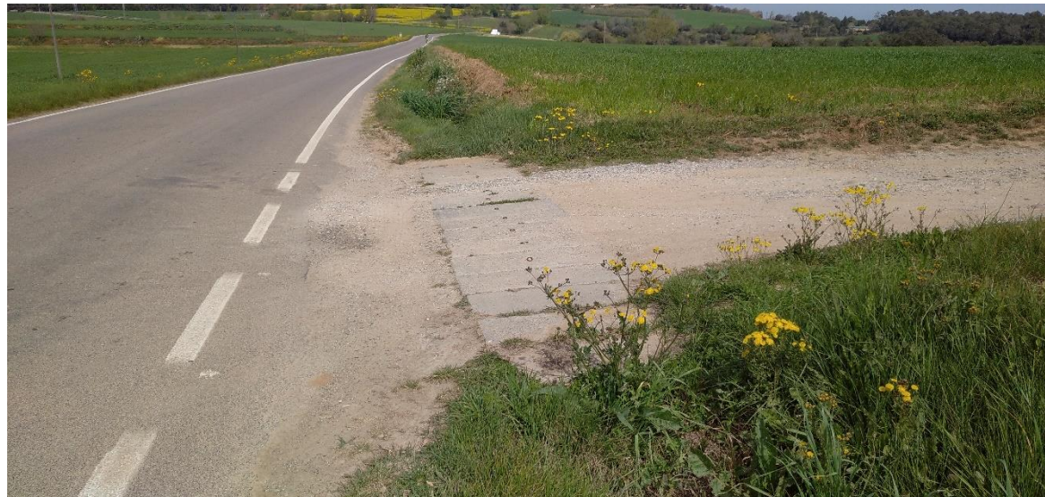
Figura 44. Accés a finques al marge dret de la carretera, al PK 1+590.
