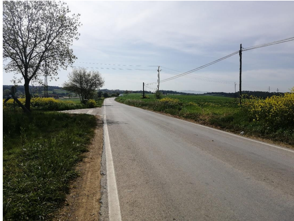
Figura 51. Accés al marge dret de la carretera, al PK 2+190
