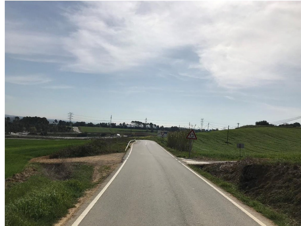
Figura 11. Vista general de la carretera al PK 0+250, en sentit Girona-Figueres
