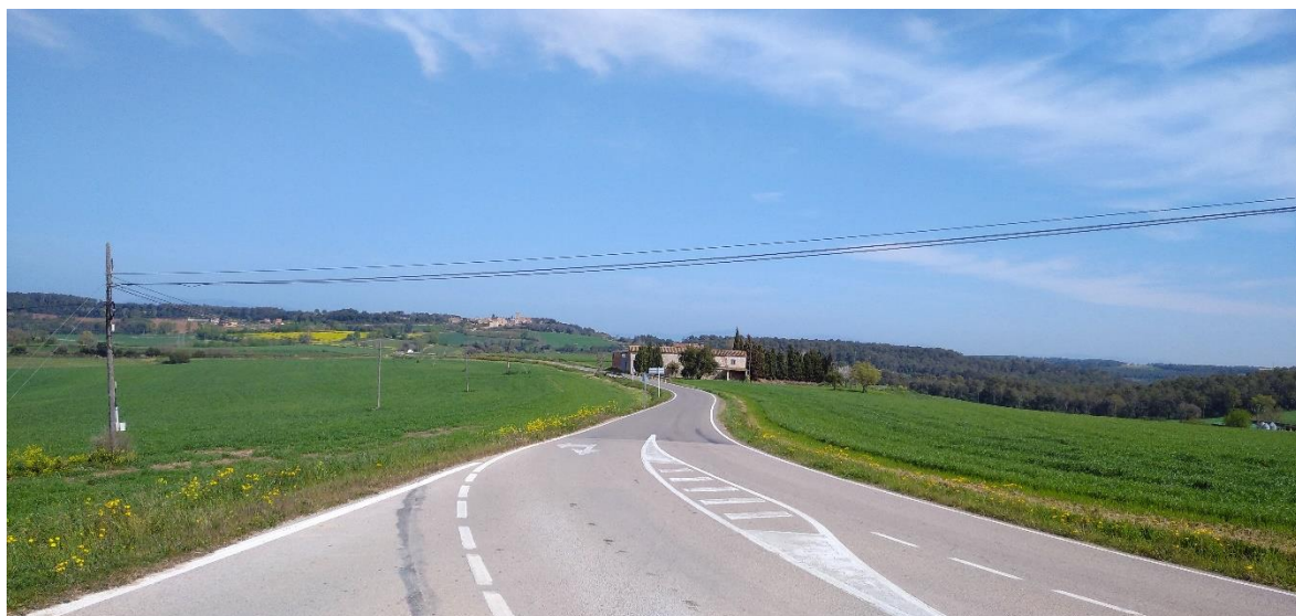
Figura 40. Tram on s'executaran les noves parades de bus, vist des del PK 1+150, i creuament de línia de telecomunicacions, amb Sant Esteve al fons
