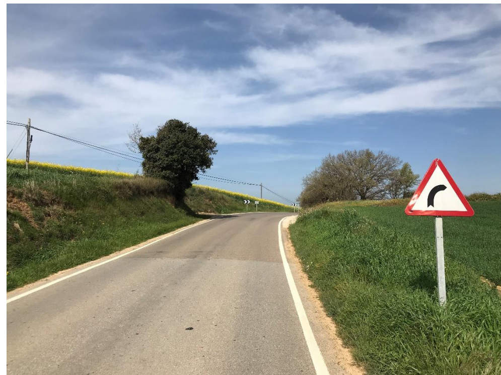
Figura 10. Vista general de la carretera al PK 0+250, en sentit Sant Esteve de Guialbes
