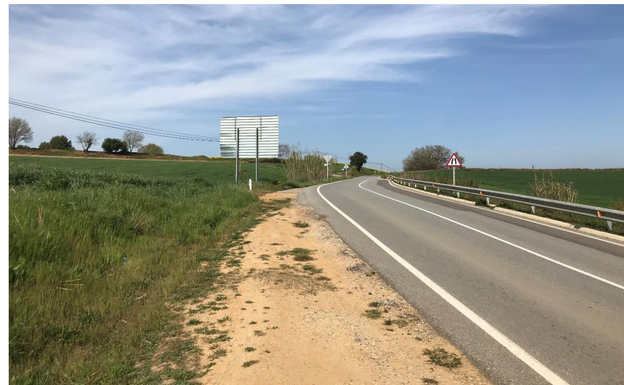
Figura 4. Vista general de l'inici del tram d'actuació, en sentit Sant Esteve de Guialbes
