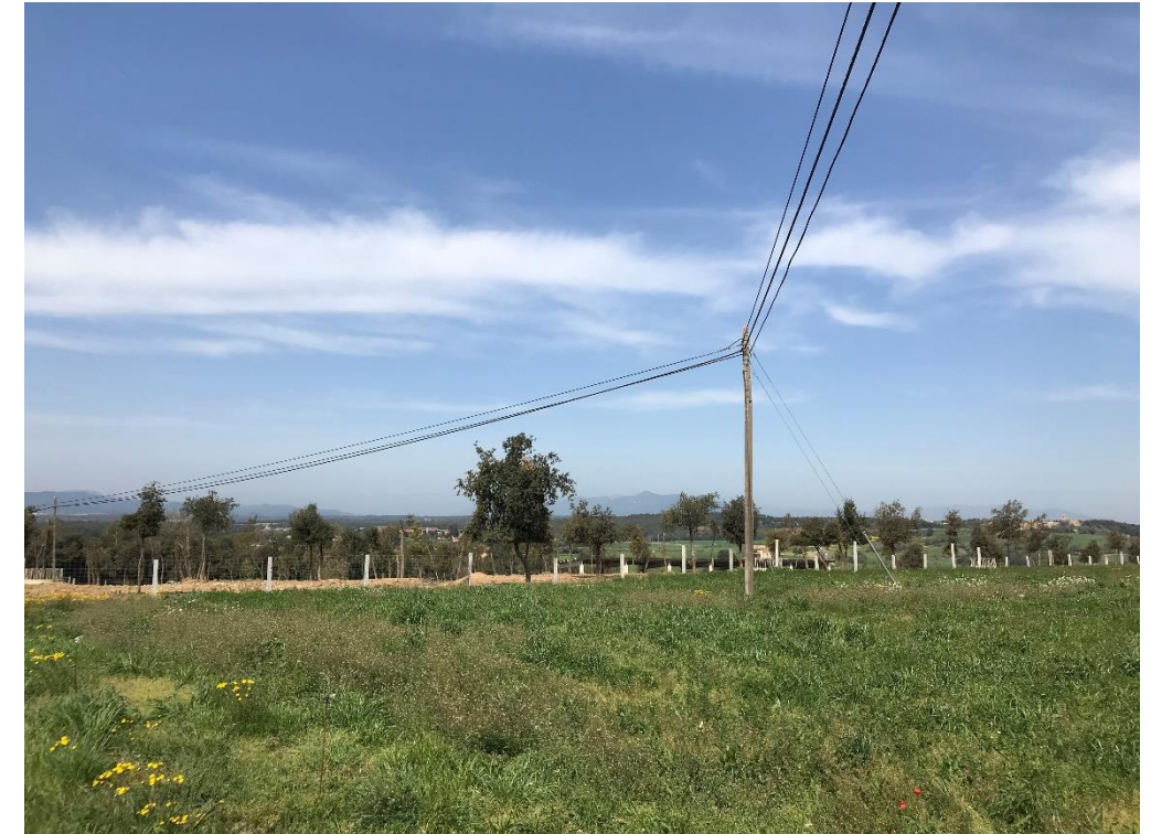
Figura 29. Línia de serveis de telecomunicacions que creua la carretera al PK 0+770 al marge dret
