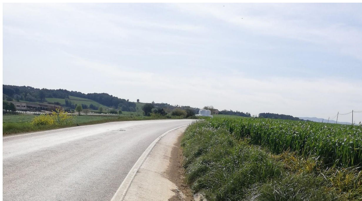
Figura 11 Cuneta de formigó trepitjable
