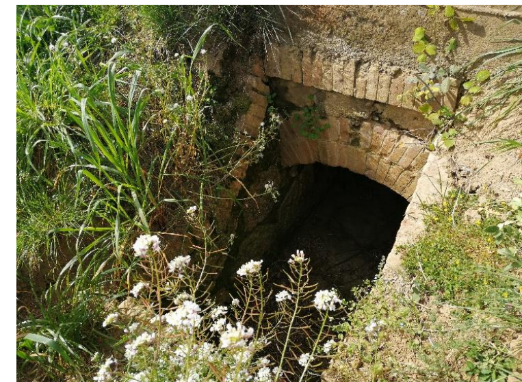
Figura 46. Obra de drenatge 4 al PK 1+720
