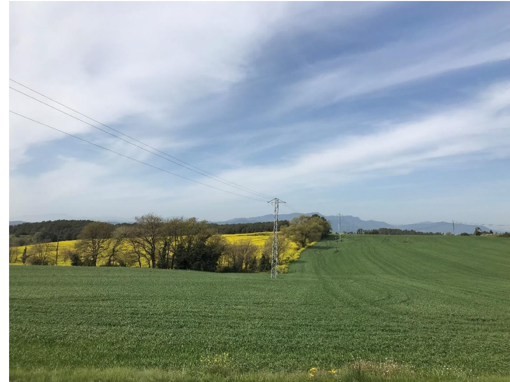
Figura 17. Línia de distribució elèctrica propietat de Electra Avellana que creua la carretera pel PK 0+400
