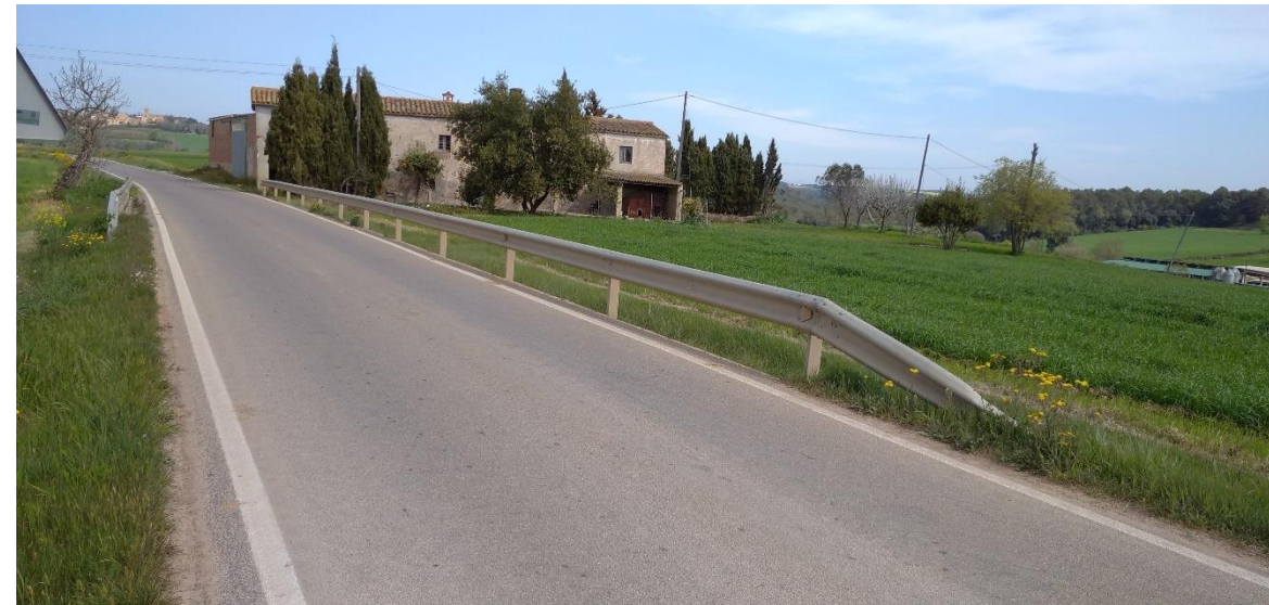
Figura 41. Tram amb defenses per el pas d'una ODTL al PK 1+300 i edificació al PK 1+350
