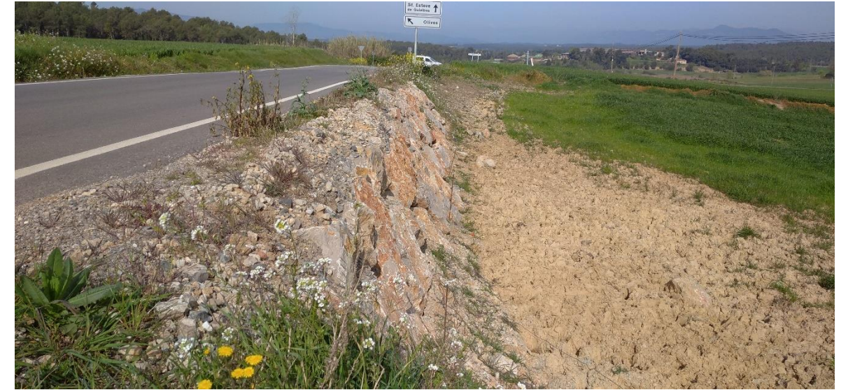
Figura 37. Mur existent al marge dret de la carretera, al PK 1+100
