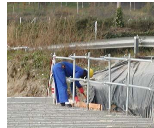
Fig. 6 Encofrat de tap lateral
