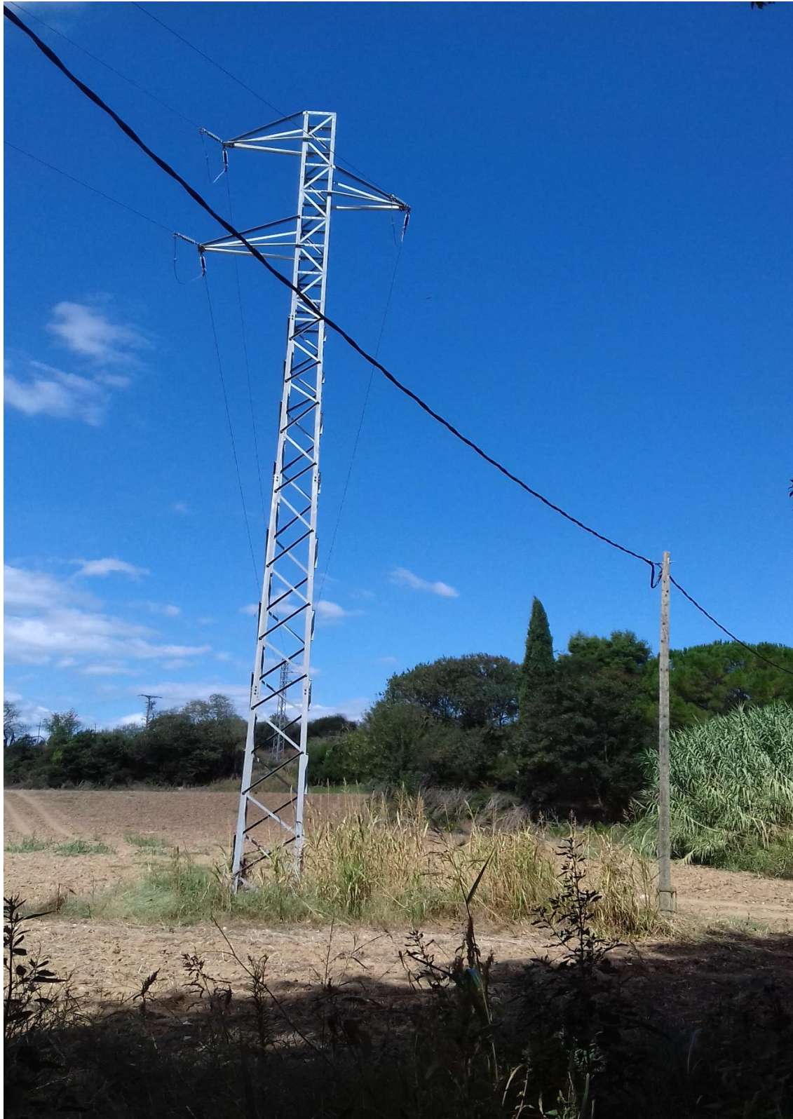
Figura 25. Serveis de baixa i mitja tensió afectats per la futura execució del viaducte al marge oest del riu Manol
