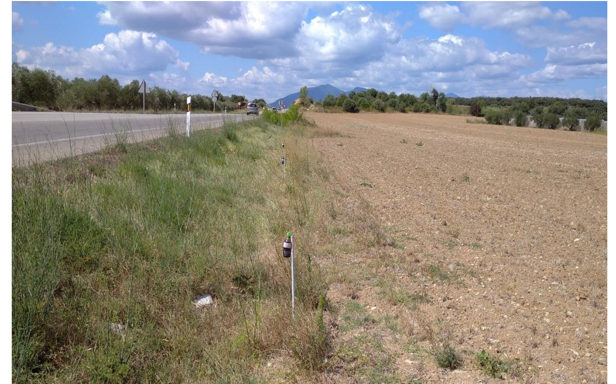
Figura 38. Cuneta de terres al marge nord de la N-260
