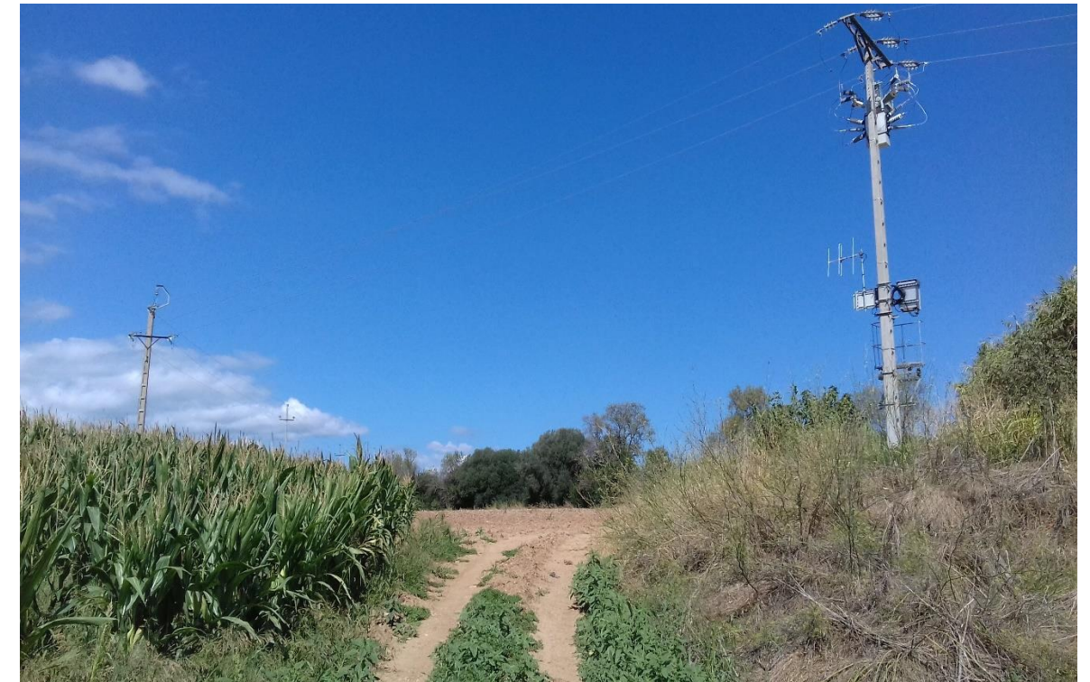
Figura 30. Línia aèria de MT propietat d'Endesa que creuarà la futura traça de la variant al PK de projecte 0+840
