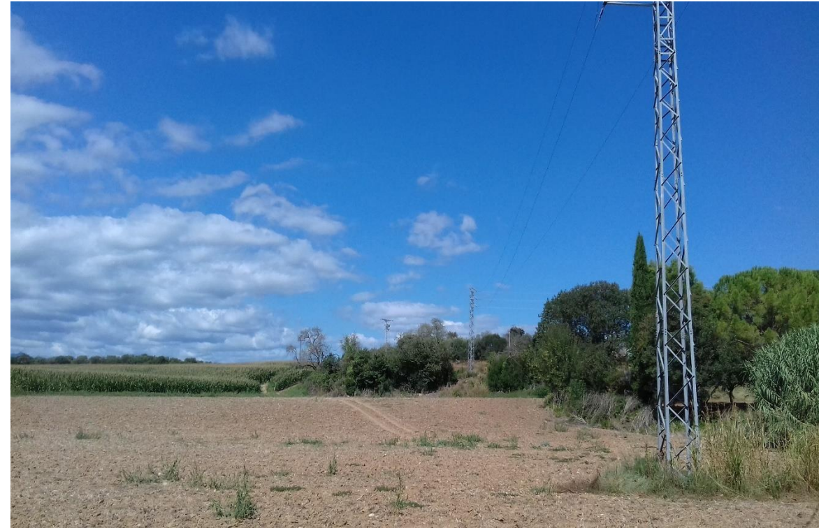
Figura 26. Vista des del PK de projecte 0+650, dels terrenys sobre els quals discurrerà la nova variant (sentit Vilafant)
