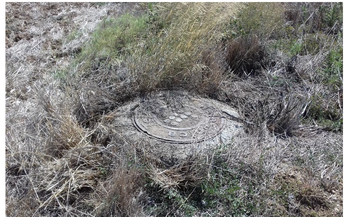
Figura 39. Arqueta de telefonia afectada pels futurs treballs de l'enllaç entre la GIP-5129 i la N-260
