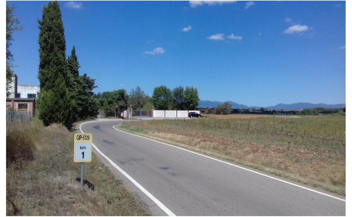
Figura 7. Carretera GIP-5129 al PK 1+000
