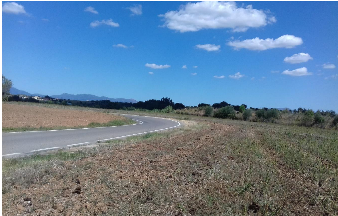
Figura 9. Imatge del revolt on la variant enllaçarà amb l'antiga traça de la GIP-5129 (PK de projecte 0+360)
