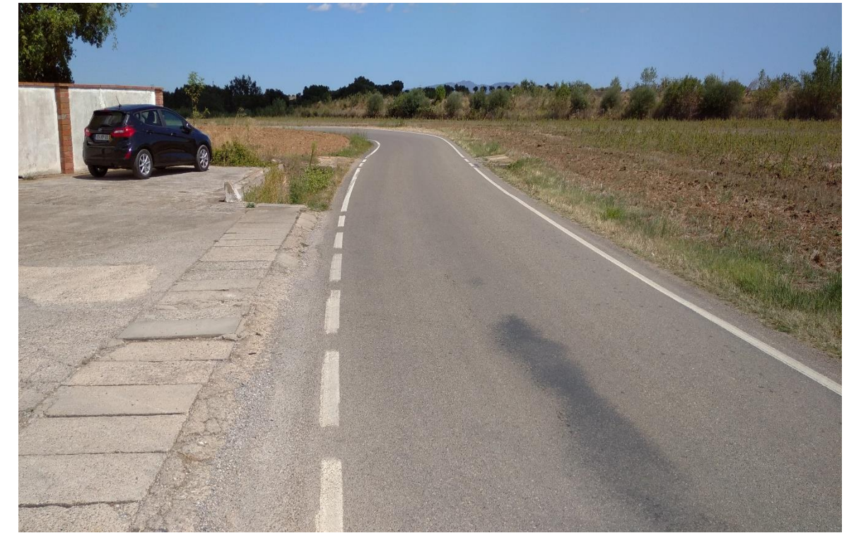
Figura 8. Vista de la carretera GIP-5129 en sentit Vilafant des del PK 0+940
