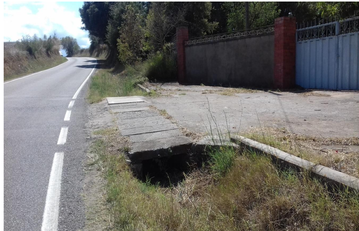
Figura 14. Salvacunetes existent al PK 0+715 de la carretera existent
