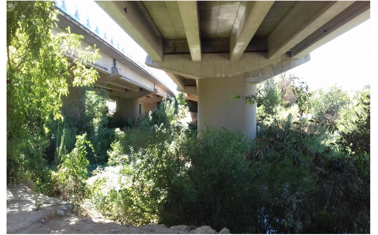
Figura 23. Vista inferior del viaducte de l'AP-7 sobre el riu Manol
