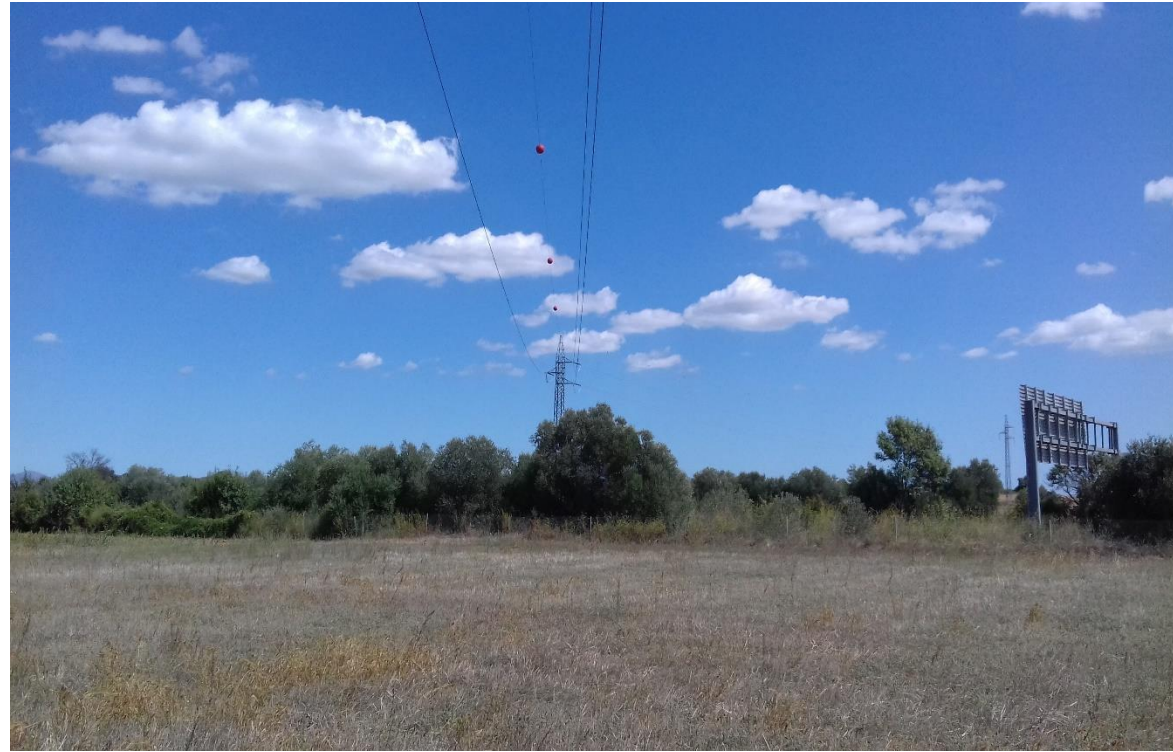
Figura 5. Línia elèctrica d'alta tensió que creuarà la futura traça de la variant a l'alçada del PK de projecte 0+200
