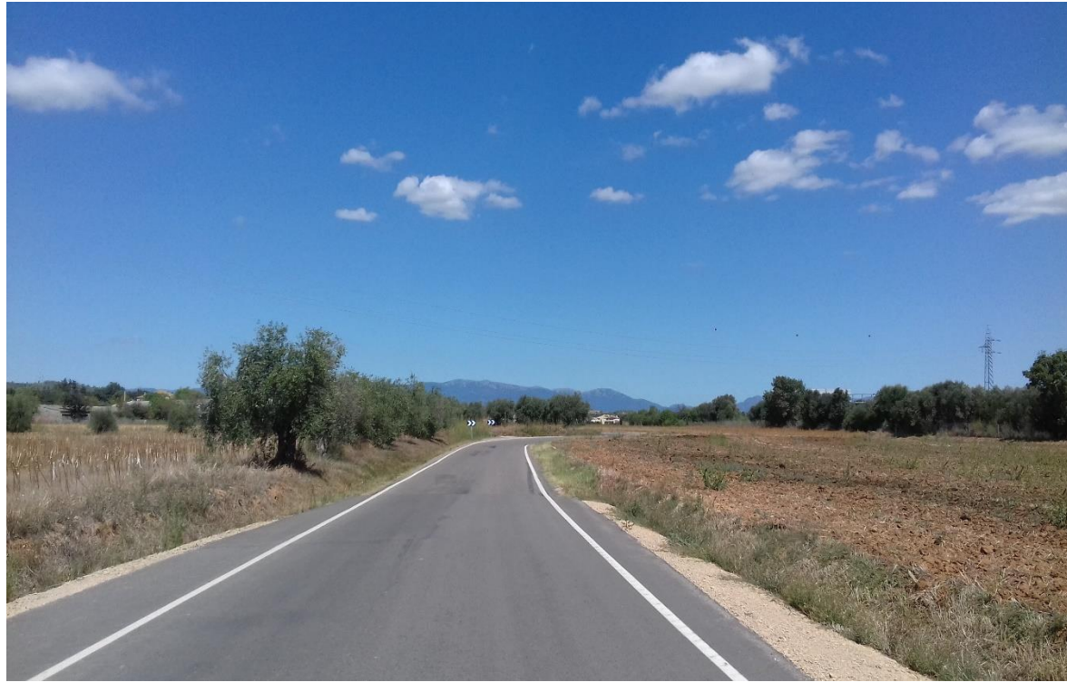
Figura 1. Vista general del vial a l'inici del tram
