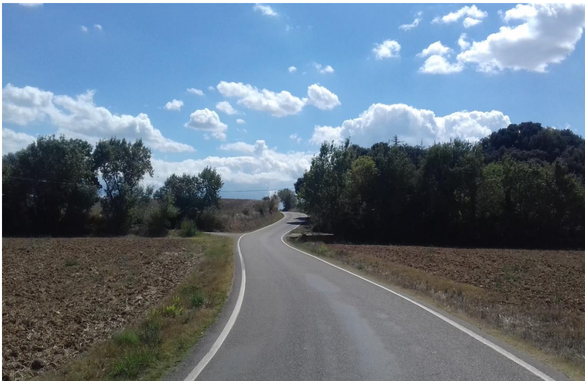
Figura 18. Vista general de la GIP-5129 en sentit Borrassà des del PK 0+620
