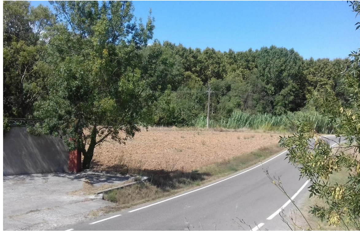
Figura 13. Vista de la GIP-5129 des del PK 0+720
