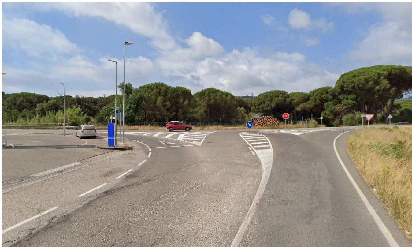
Foto 5. Foto des del ramal de Calonge amb l'aspecte de la cruïlla en l'estat actual
