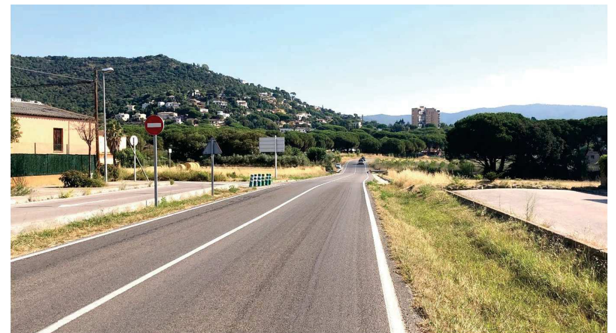
Tram final de la carretera abans d'entrar al poble de Calonge (PK 17)
