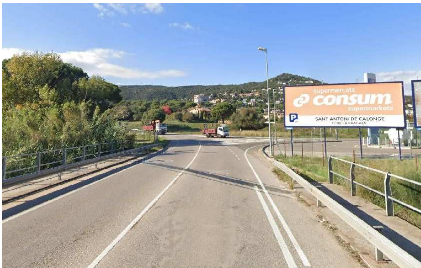
Foto 6. Foto des del ramal de l'accés a la C-31 amb la junta esbiaixada del pont fins on caldrà actuar
