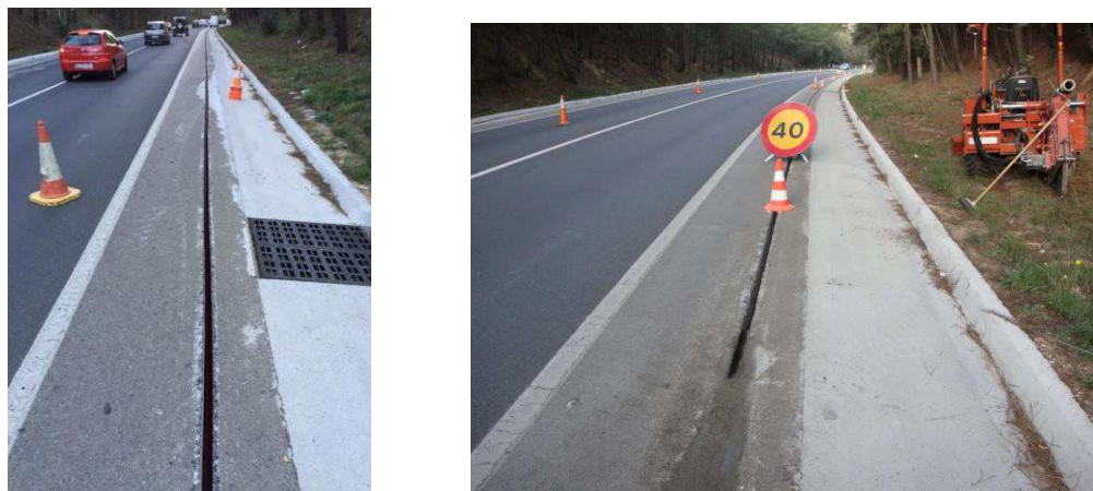
Figura 21. Exemple de senyalització de la zona de treball a la C-65
