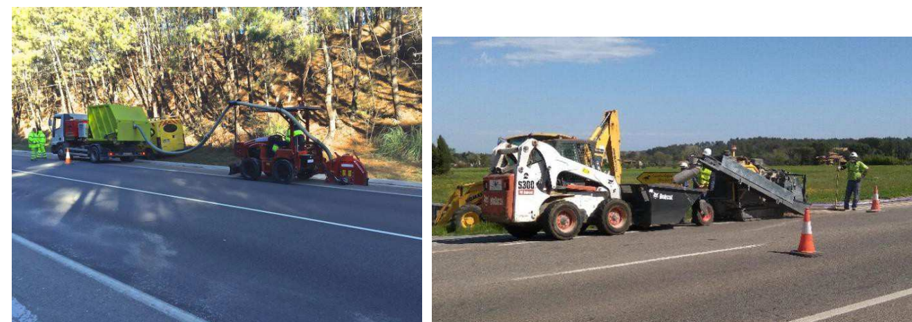
Figura 14. Rasadora i camió de recollida de runes
