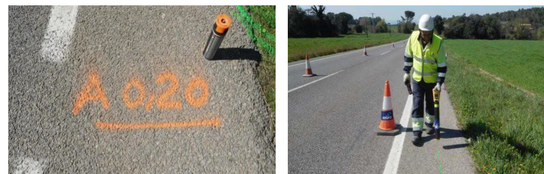
Figura 1. Localització de serveis amb georadar
