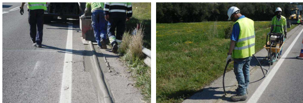
Procés de rebliment de la rasa amb morter.
