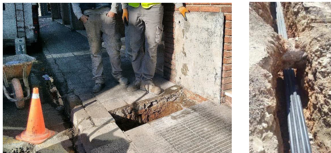
Figura 2. Exemple d'execució de cata amb detecció de serveis i minat de canonada
