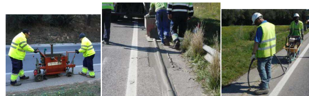
Figura 26. Exemple de treballs de rebliment de la rasa
