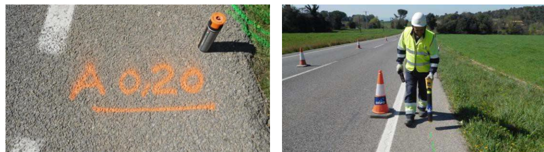
Figura 22. Localització dels serveis amb georadar
