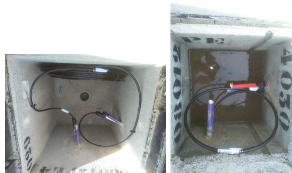
Figura 28. Exemples Terminació microductes en pericó
