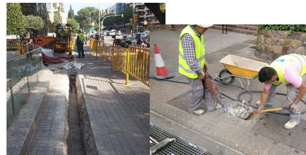
Figura 9. Exemples canalització convencional en àmbit municipal
