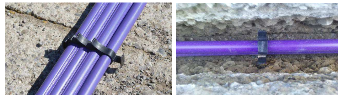
Figura 23. Centrador plàstic per homogeneïtzar la distribució del morter.
